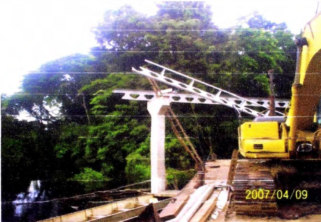
Montaje de Vigas con máquina excavadora, sobre barcaza Elvira
