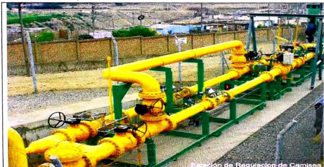
**Figura 2.10: Estación de Regulación y Medida de Camisea**
