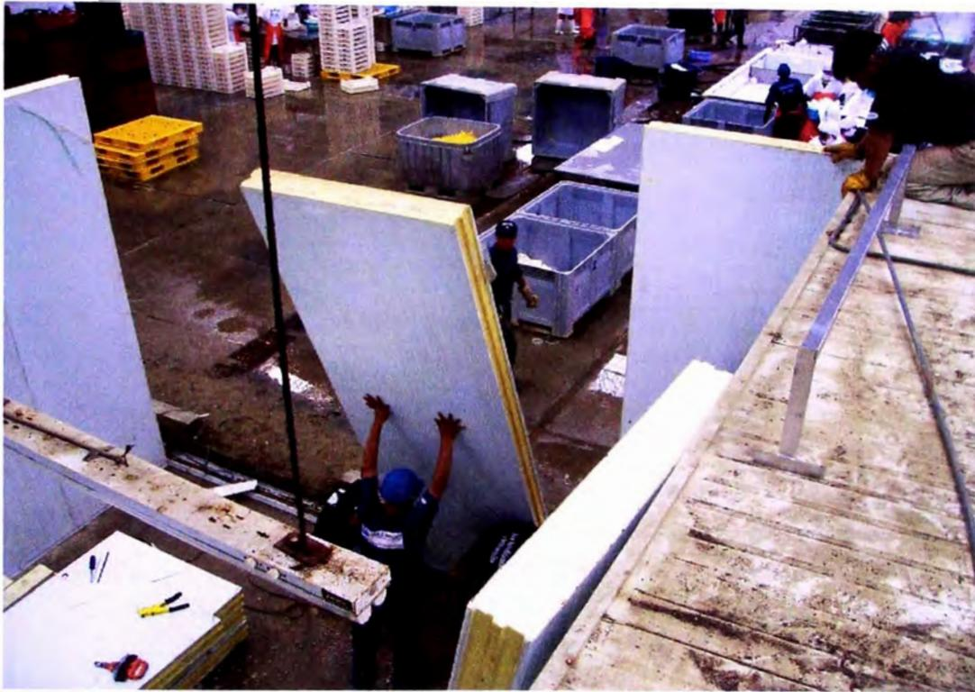
Fig.B.4 Montaje paneles de pared
