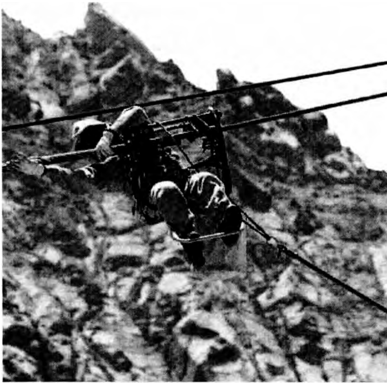
Gráfico N° 6.2 Limpieza de conductores de forma manual.
