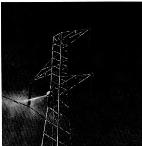
Gráfico N° 6.4 Lavado de aisladores con la línea energizada.
