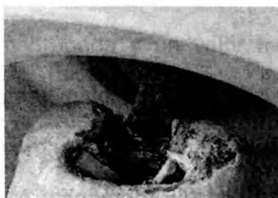
GRÁFICO N° 7.9 Corrosión del pin de aislador de vidrio, grado 1.
