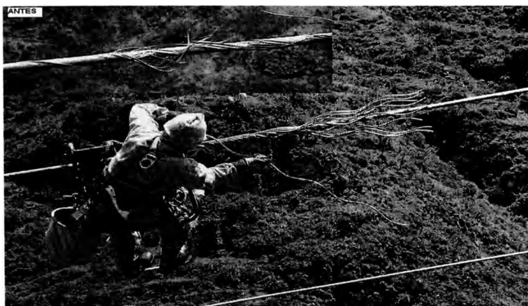
Gráfico N° 6.6 Reemplazo de conductores.
