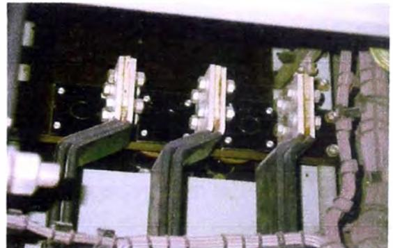
**Conexión de Barras de Llegada en Tablero Eléctrico**
