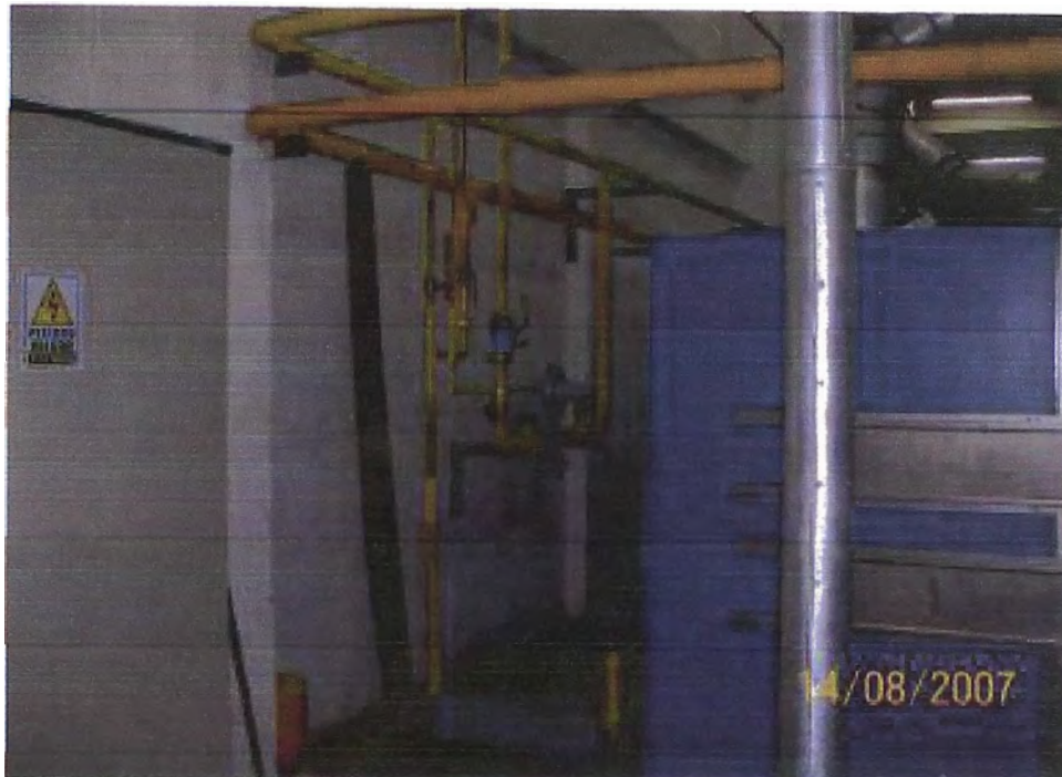
Foto N° 9 Instalación de gas – Rama Unitech
