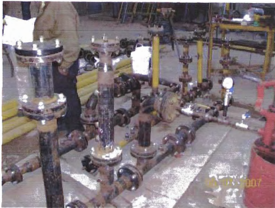
Foto N° 1 Prueba de Hermeticidad de la ERMP
