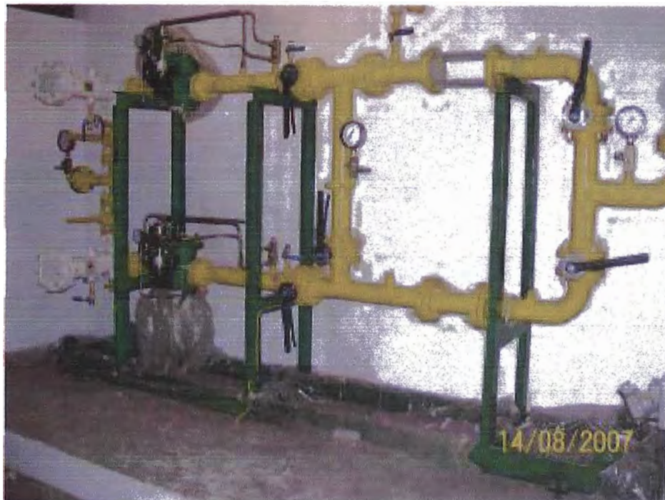
Foto N° 2 Vista de detalle de la ERMP terminada
