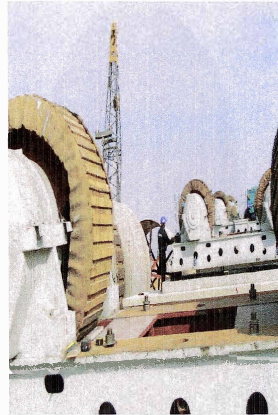
4 estaciones (parrilla y polines), instalados sobre bases de concreto y calzas metálicas con aproximación de +/- 1mm (Supporter Device)
