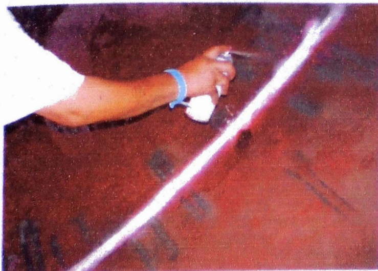
Inspección antes de soldar la parte interior del Horno
