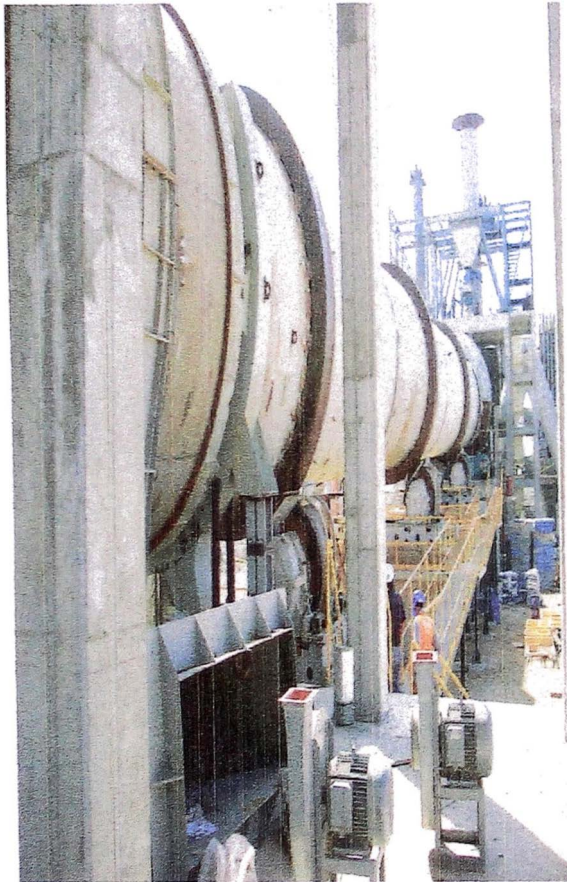
VISTA COMPLETA DEL HORNO ROTATORIO CONCLUIDO EL MONTAJE
