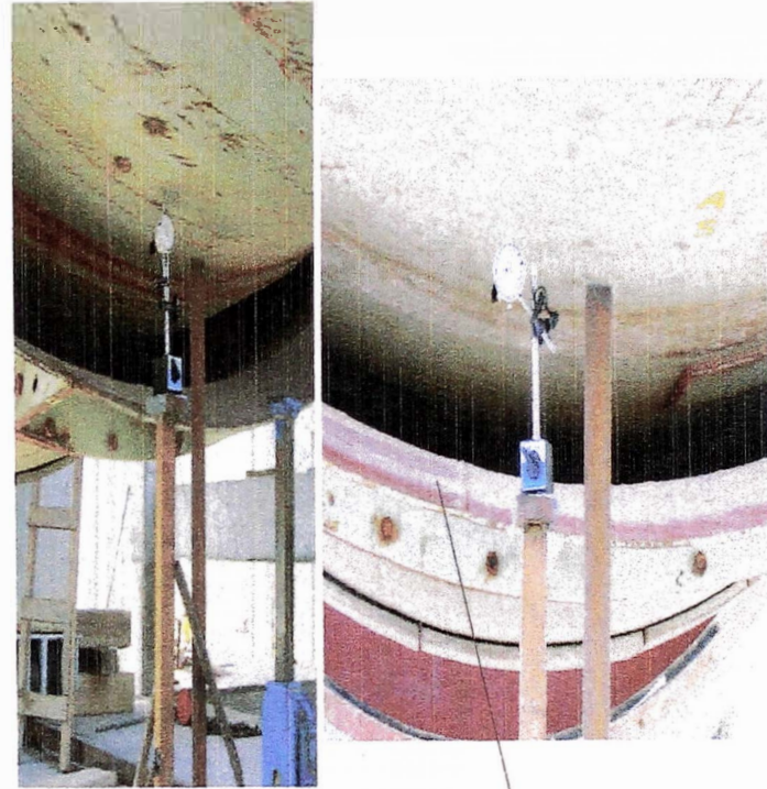
GRAMILADO DEL HORNO ANTES DEL SOLDEO LECTURAS DADAS POR EL RELOJ COMPARADOR
