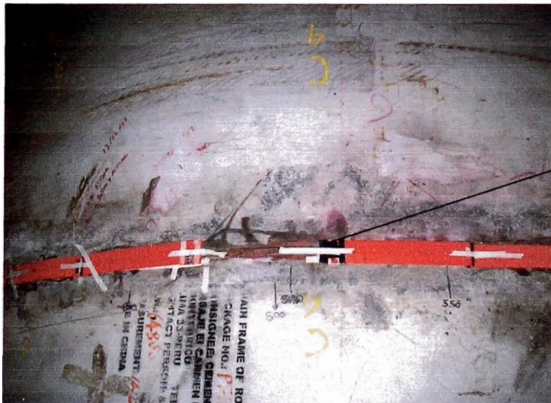
Plaqueo total de los segmentos reparados (cuatro placas) en la Costura "C1"
