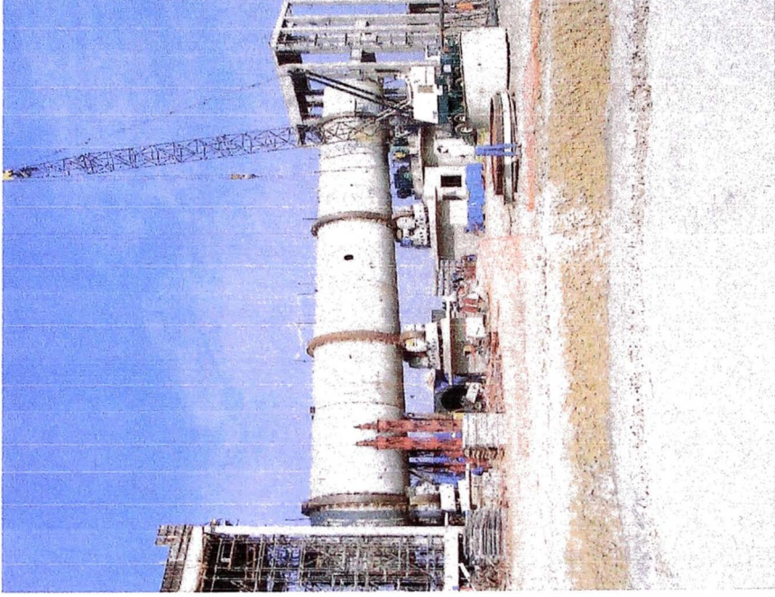
MONTAJE COMPLETO DEL HORNO ROTATORIO
