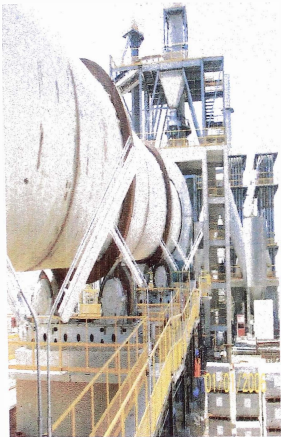
Vista del horno concluido el montaje
