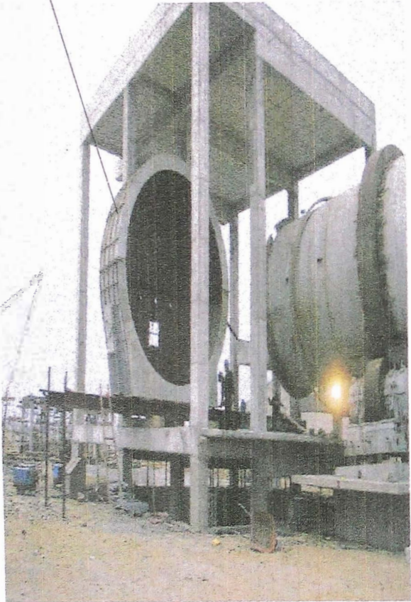
MONTAJE DEL CABEZAL DE DESCARGA Cabezal de descarga
