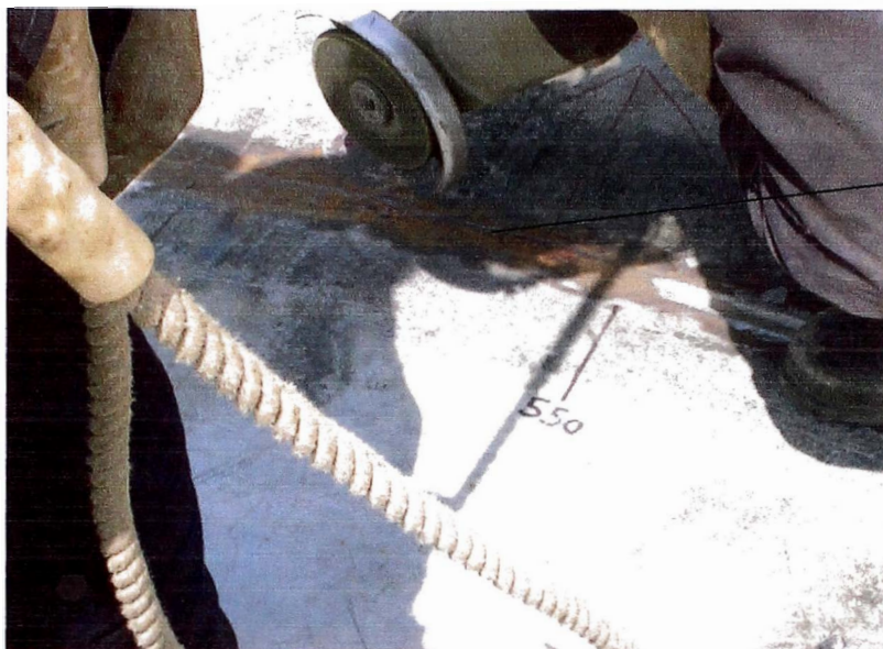
Esmerilado del tramo del cordón a ser corregido
