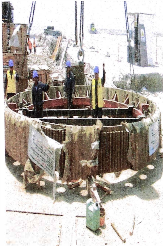
CONTROL DIMENSIONAL DE LA CORONA (GEAR) PRESENTACION EN EL TERRENO
