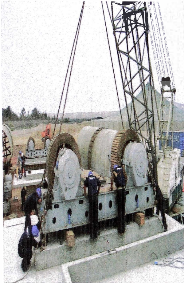
Montaje de Conjunto parrilla y Polines (bases del Horno)
