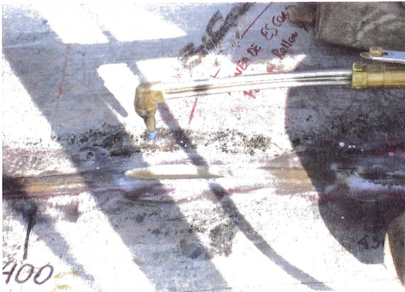
Pre calentamiento de la plancha base
