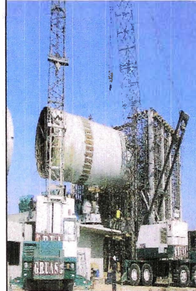
MONTAJE DE LA VIROLA Nº 5
