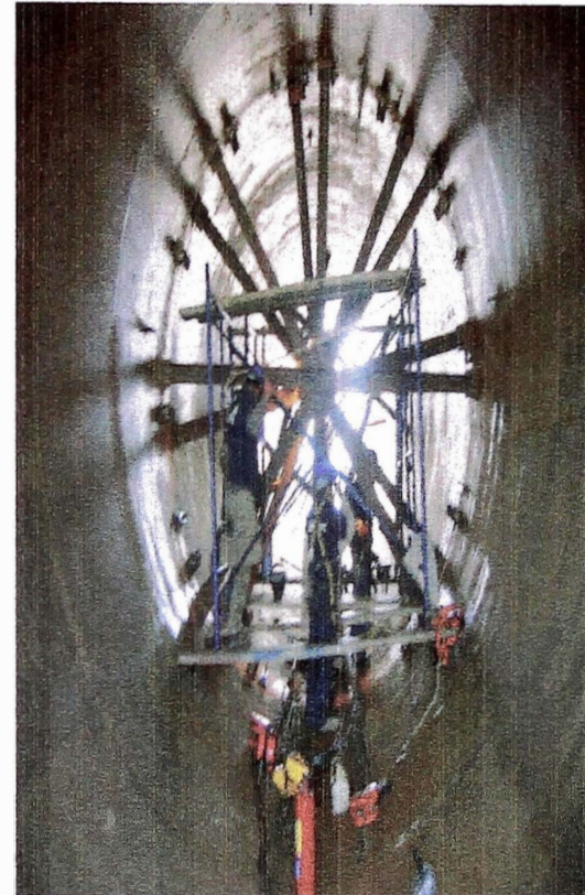
INSTALACION DE PUENTES Y ACCESORIOS PARA EL ENSAMBLE DE LAS VIOLAS
