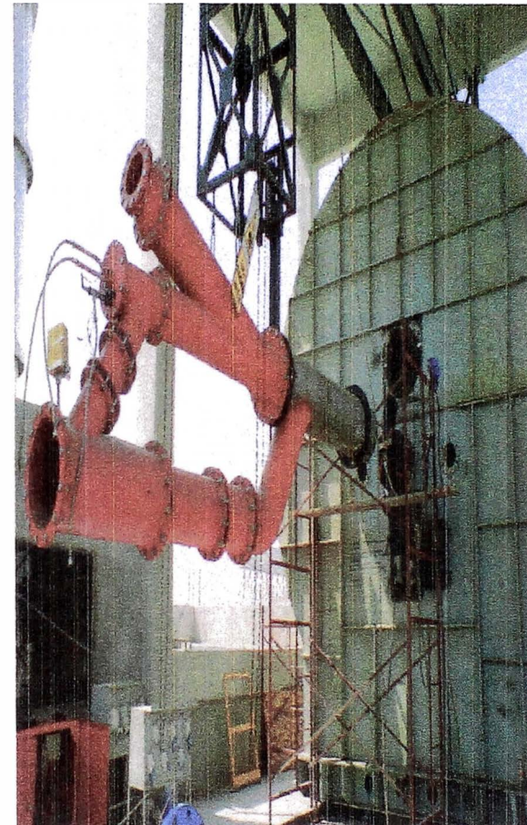
Instalación del quemador dual del horno
