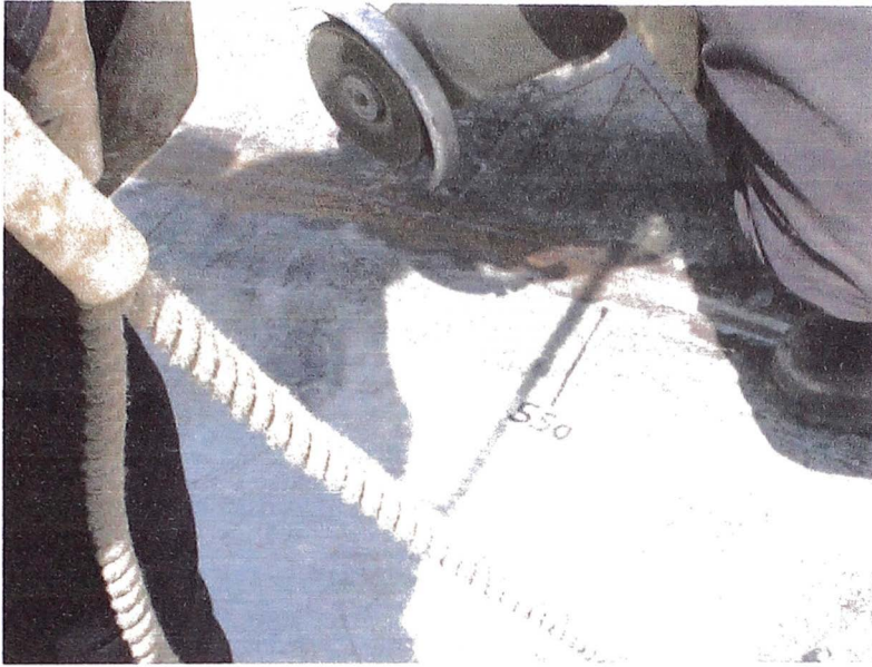
Limpieza y esmerilado de escoria encontrado
