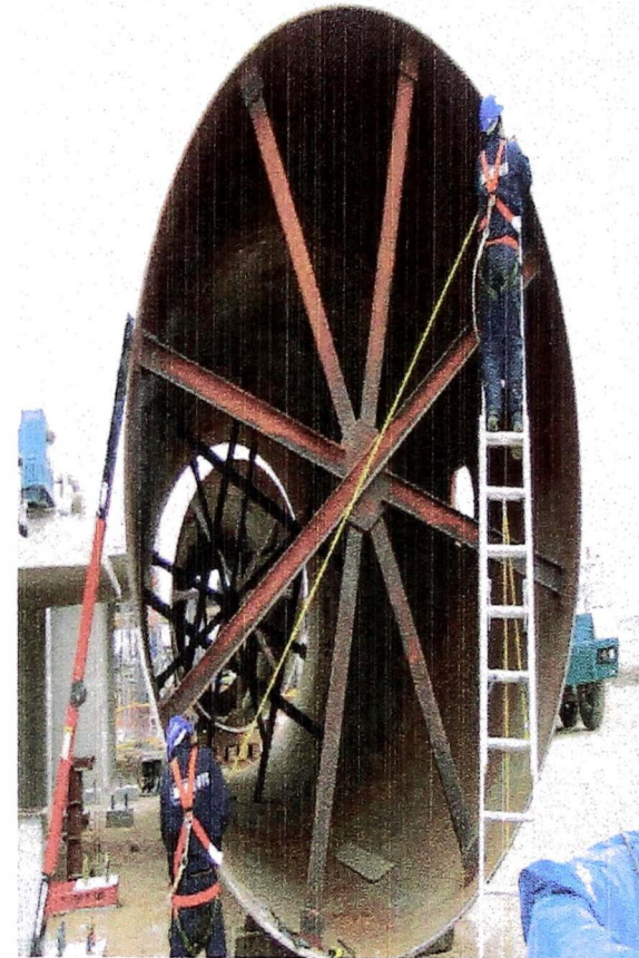
CONTROL DIMENSIONAL DE LOS DIAMETROS DE LAS VIROLAS DEL HORNO (SHELL)
