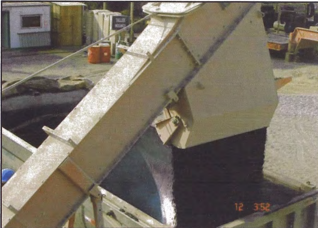
Foto 32: Forma de carguío con mezcla asfáltica modificada a los volquetes Fuente: Elaboración propia
