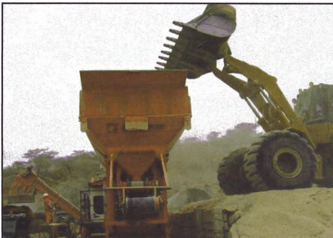
Foto 31: Abastecimiento de agregados para mezcla asfáltica modificada Fuente: Elaboración propia
