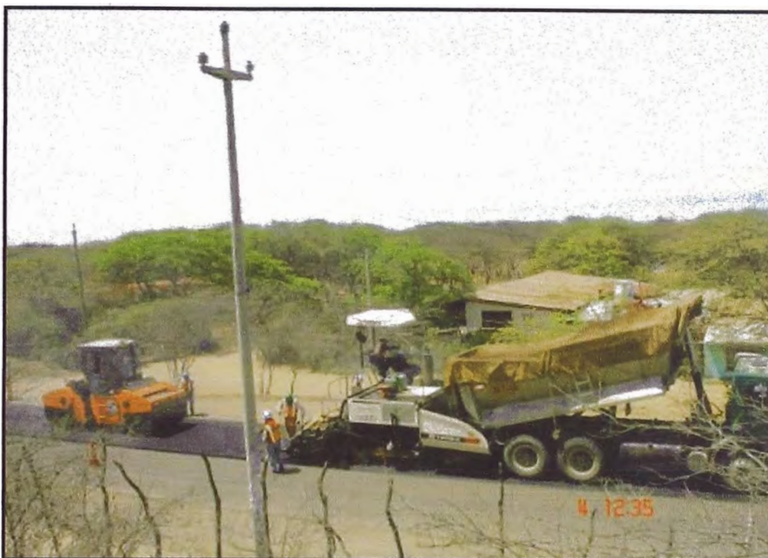
Foto 36: Vista de rodillo tándem cercano a la esparcidora Fuente: Elaboración propia
