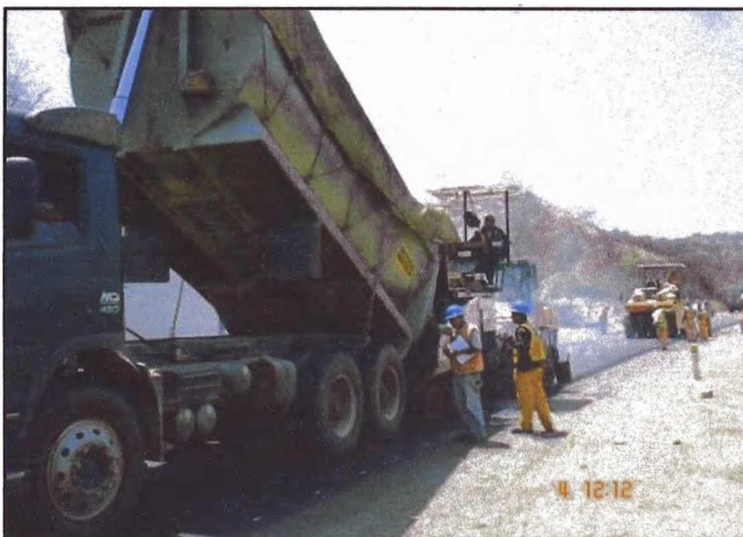
Foto 35: Descarga de mezcla asfáltica modificada sobre esparcidora Fuente: Elaboración propia
