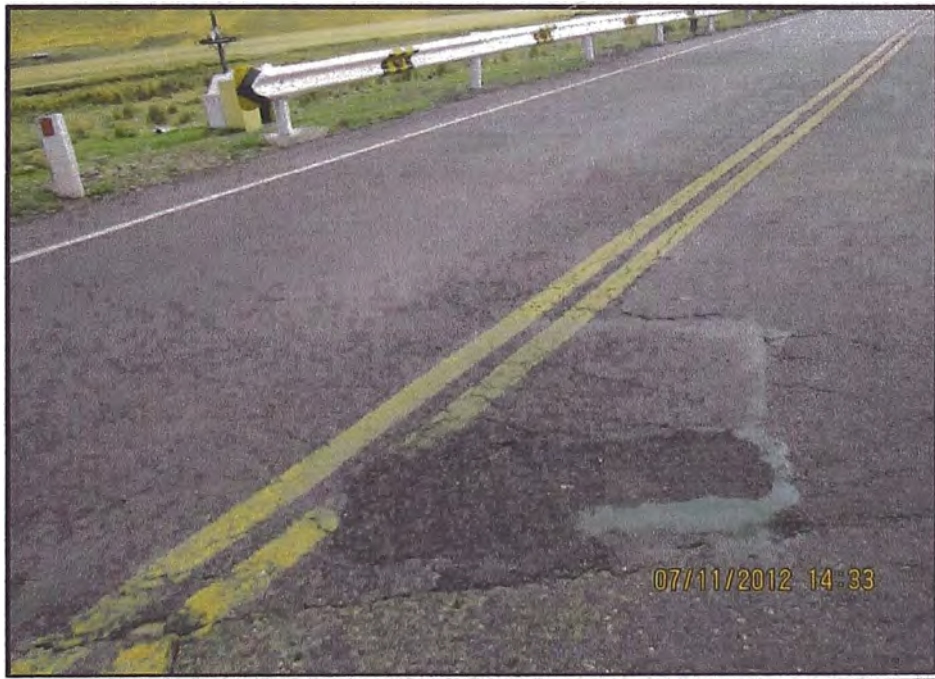
Fisura Piel de Cocodrilo de Severidad Media de 3-13 mm, cercana a la línea férrea.
