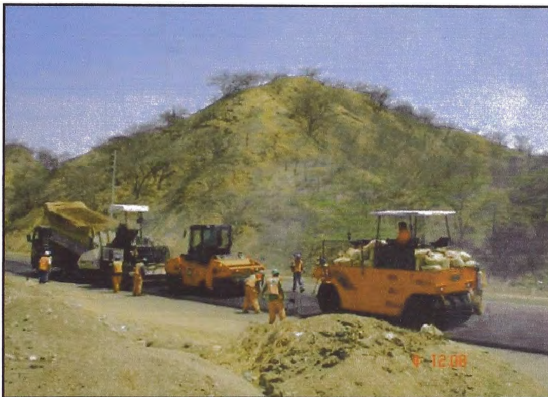
Foto 34: Tren de colocación de mezclas asfáltica modificada Fuente: Elaboración propia
