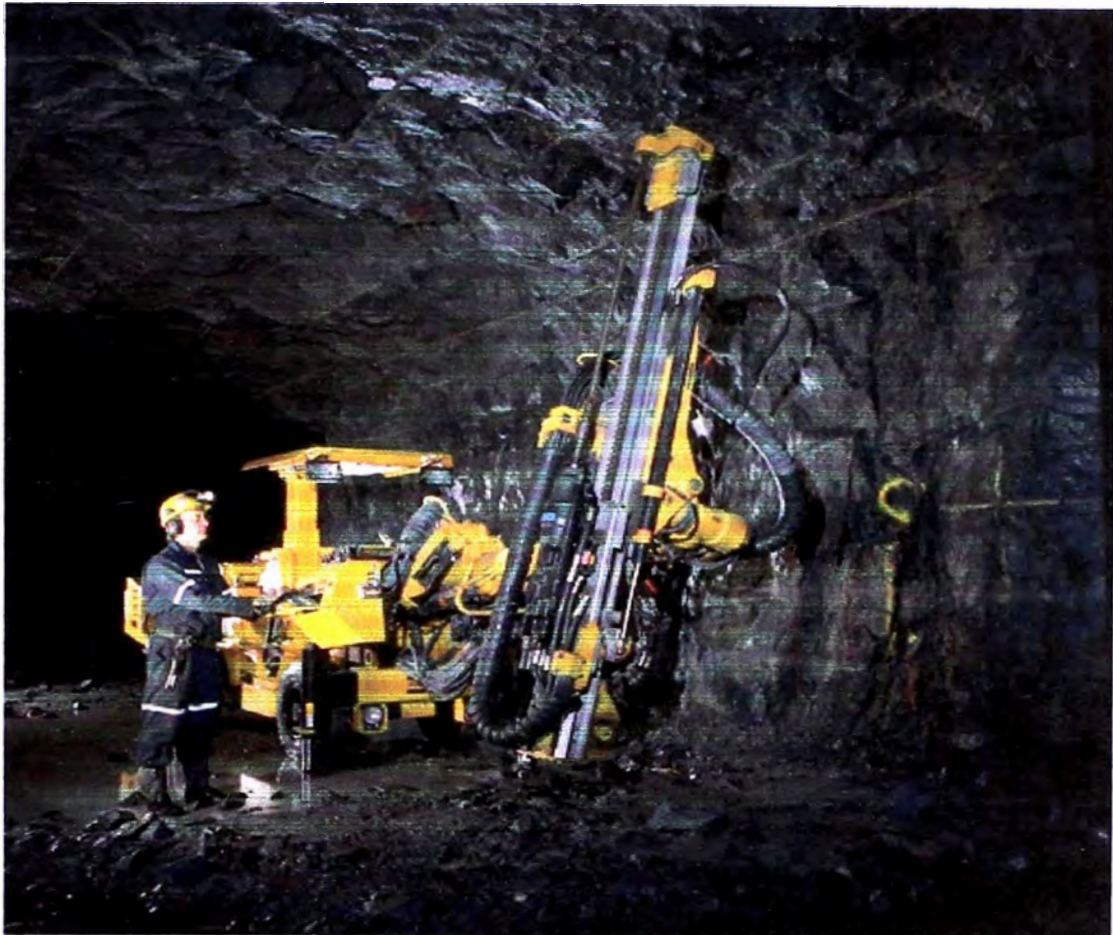
JUMBO SIMBA H-157 EN PLENA PERFORACION
