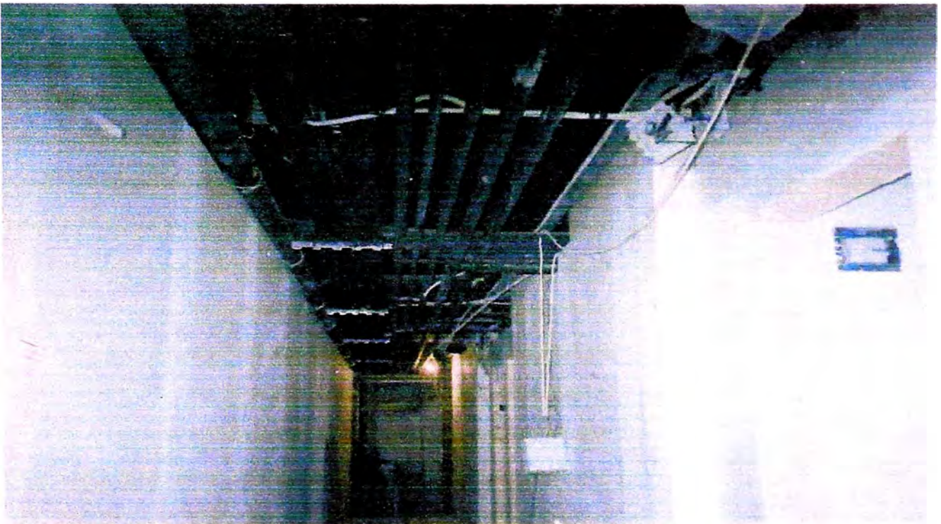
F16. FORRADO DE TUBERÍAS CON AISLAMIENTO ARMAFLEX
