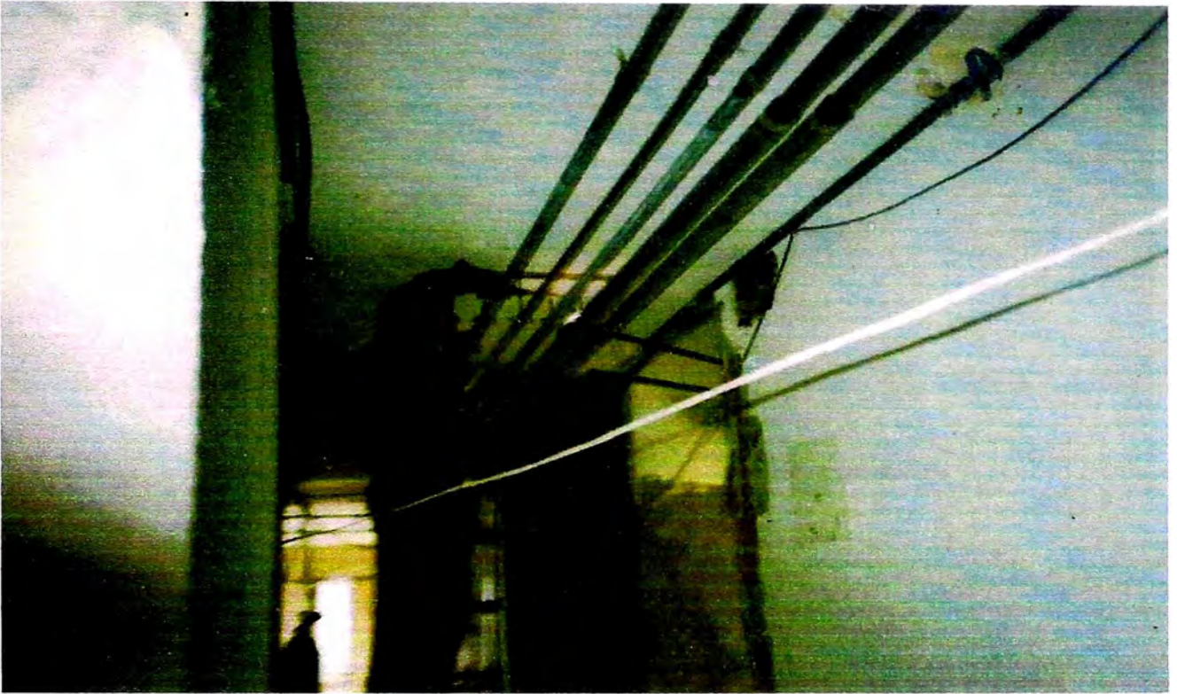
F7.- SOLDADO A LA LÍNEA PRINCIPAL LAS TUBERÍAS
