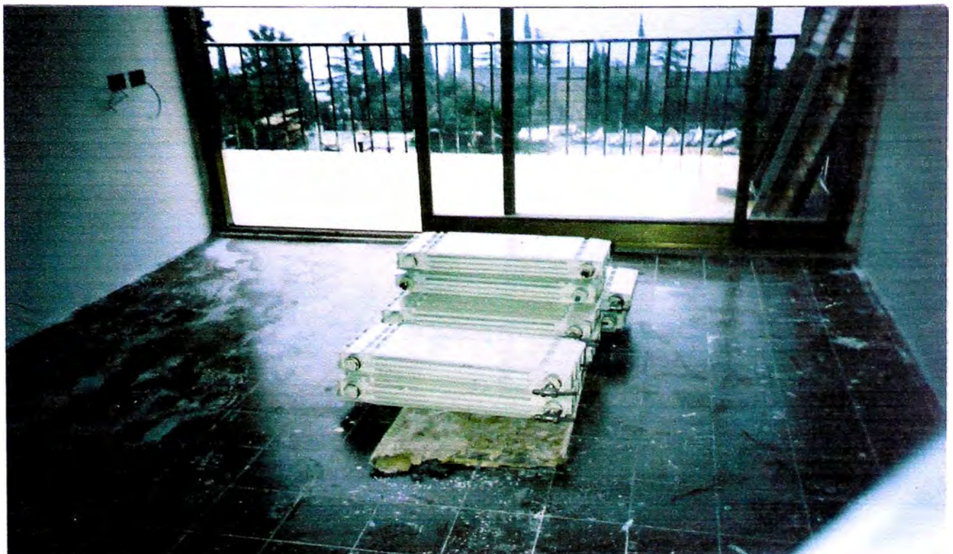
F2. Habitación con ventana calculada e intercambiador de calor
