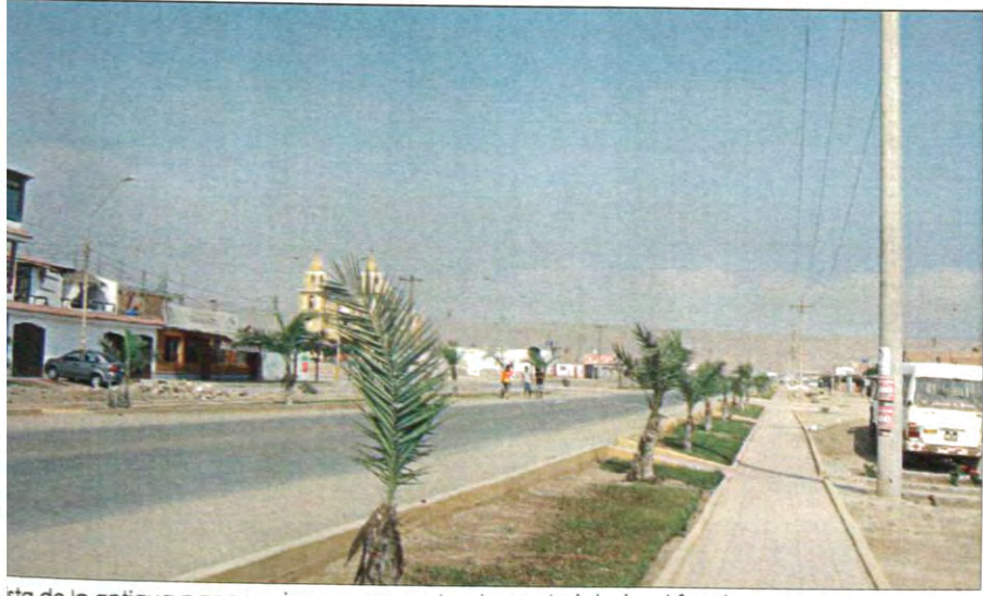
Vista de la antigua panamericana sur con la plaza y la iglesia al fondo.
