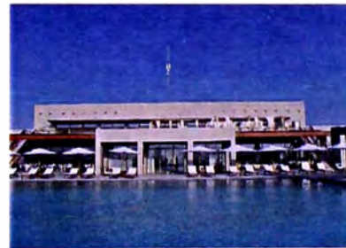
Vista de la piscina y el volumen al ingreso
