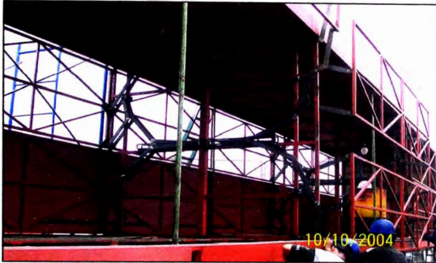
Fig. 4.11 Ensamblaje de mamparones
