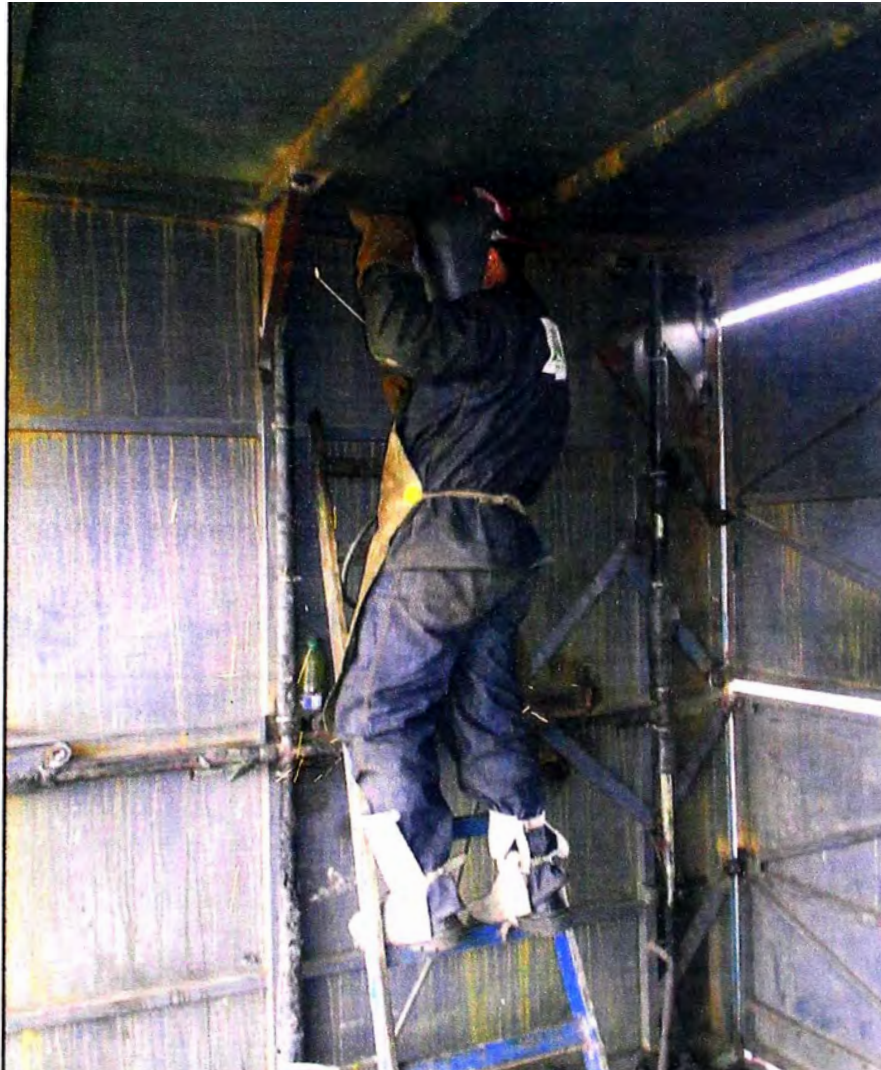
Fig. 4.10 Reforzamiento de estructura
