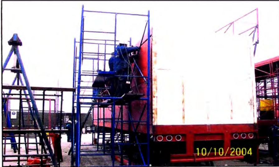
Fig. 4.15 Forrado de techo lateral.
