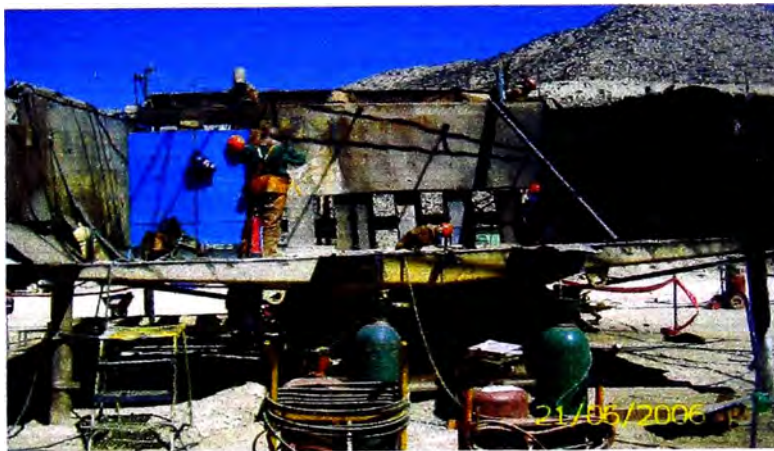
Fig. 7.7 Retiro de toda la plancha base de pecho o frontal de tolva
