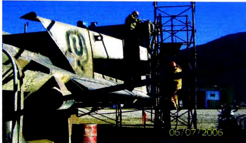
Fig. 7.15 Retro de plancha base de laterales y retiro de canal lateral superior
