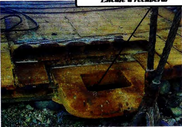
Fig. 7.26 Lanchkipper u orificio para barretón
