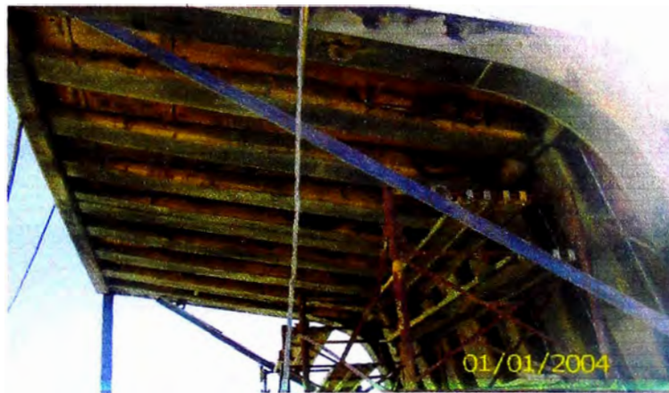
Fig. 7.6 Instalación de nueva plancha base en Canopy
