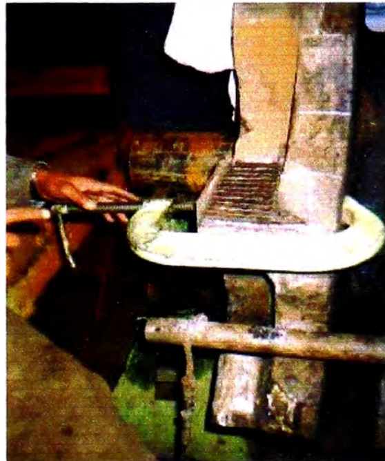
Fig. 7.62 Soldadura de recargue de los dientes, la plancha de cobre es usada para ayudar a dar forma
