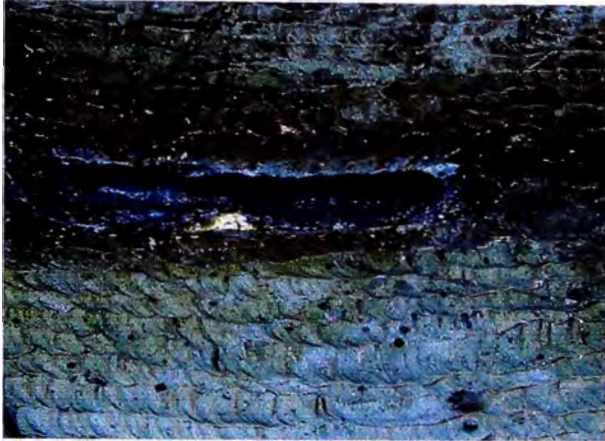
Fig 7.69. Biselado de la fisura con CHANFFERTRODF
