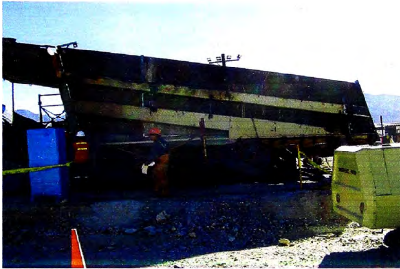
Fig. 7.16 Instalación de nueva plancha base en laterales
