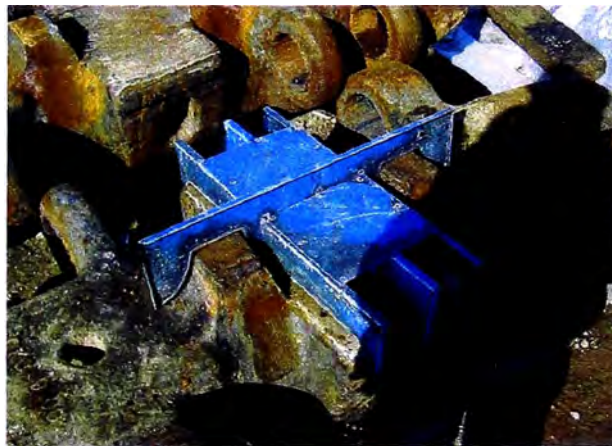
Fig 7.75 Verificación de las medidas finales después de haber rellenado con TeroMatec OA3205.
