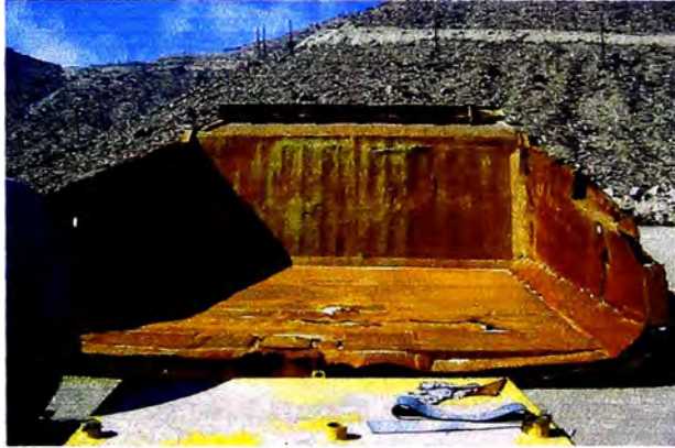
Fig. 7.1 laterales y piso de tolva pecho totalmente deteriorados
