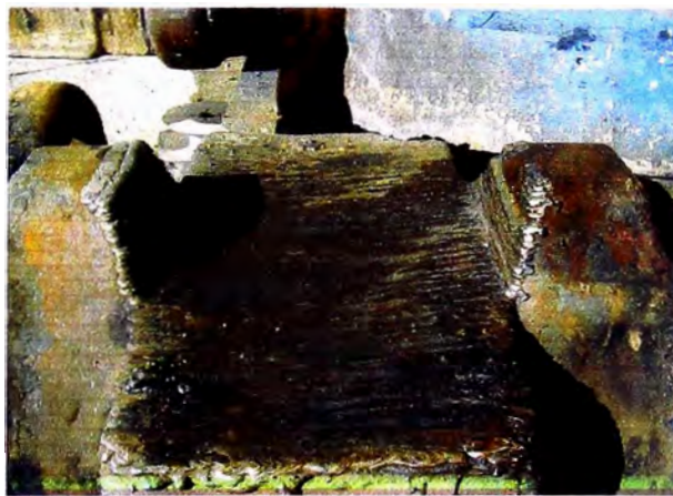
Fig. 7.73. Aspecto del enmantequillado de la zona de rodadura con alambre TeroMatec OA690.
