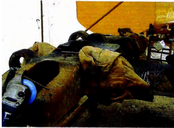
Fig.7.72. Protección total de la zapata para evitar la Pérdida de calor durante el soldeo.
