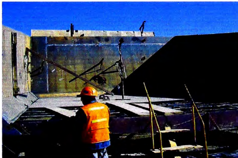
Fig. 7.12 Instalación de planchas bases de piso en material ASTM A514°B
