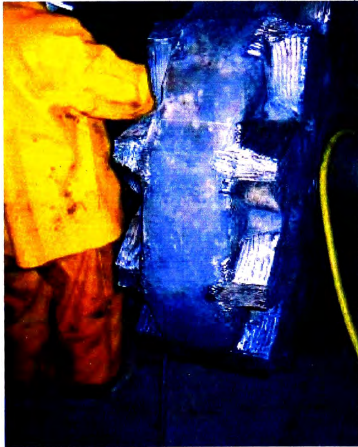
Fig. 7.61 Enmantequillado o soldadura de refuerzo aplicado a todos los dientes del tumbler
