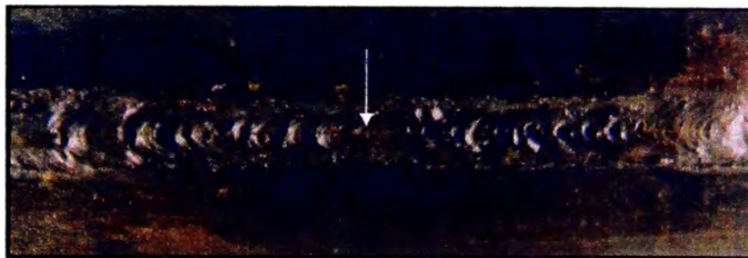
Fig. 101. Fisura Longitudinal la cual ha propagado a lo largo de la soldadura entre poros de una porosidad alineada
