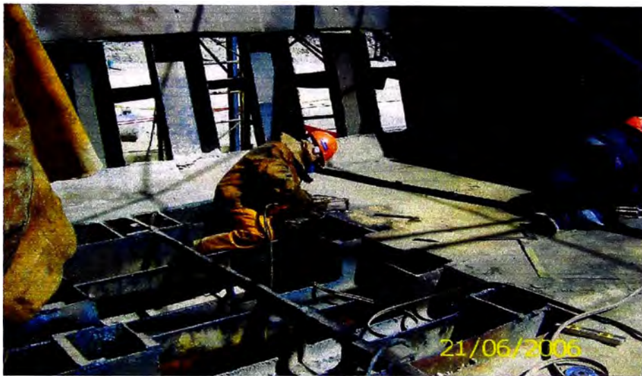
Fig. 7.9 Retiro de plancha base del piso de tolva
