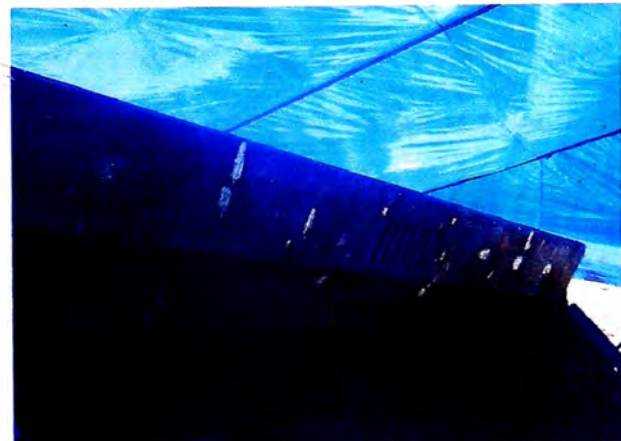
Fig. 7.59. Plancha antidesgaste para labio superior
