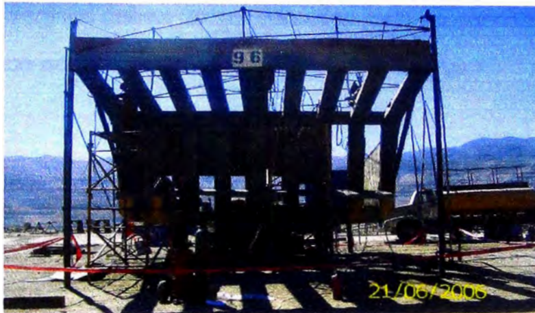
Fig. 7.5 Retiro de toda la plancha base de la visera o canopy
