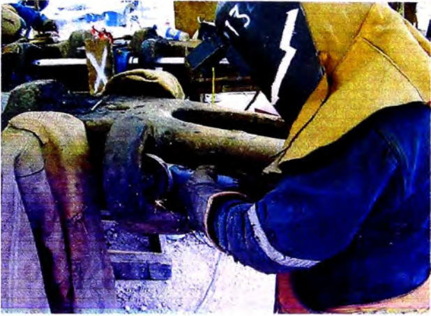
Fig 7.65. Operación de esmerilado del material fatigado
