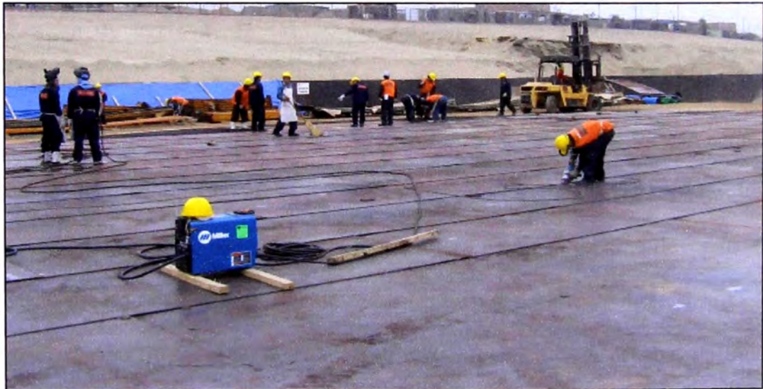
Fig. 3.6 Armado de fondo.
