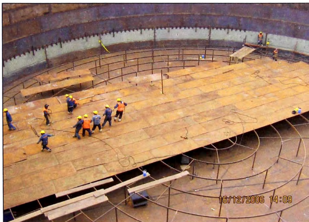
Fig. 3.10 Obra falsa del techo flotante.
