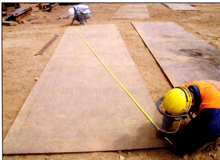
Fig. 3.1 Control dimensional de planchas.
