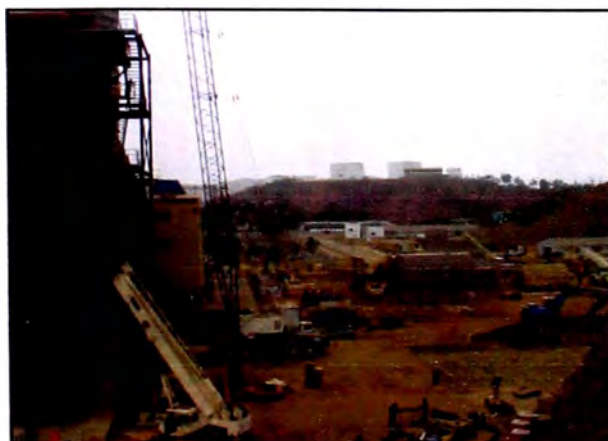
Foto 3: Obras civiles y de montaje 3
