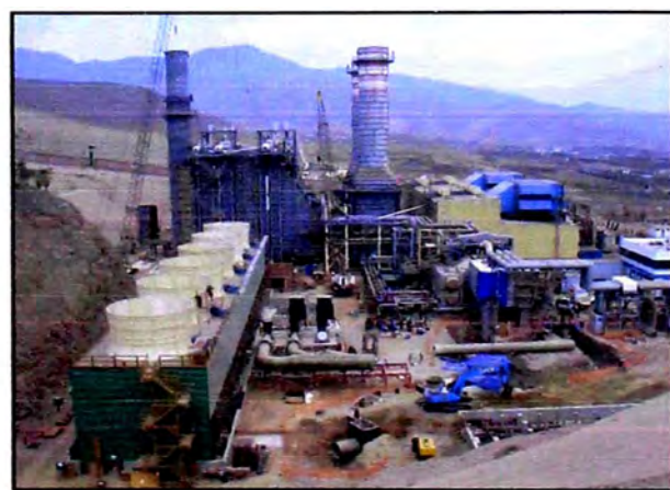
Foto 10: Obras civiles y de montaje 8
