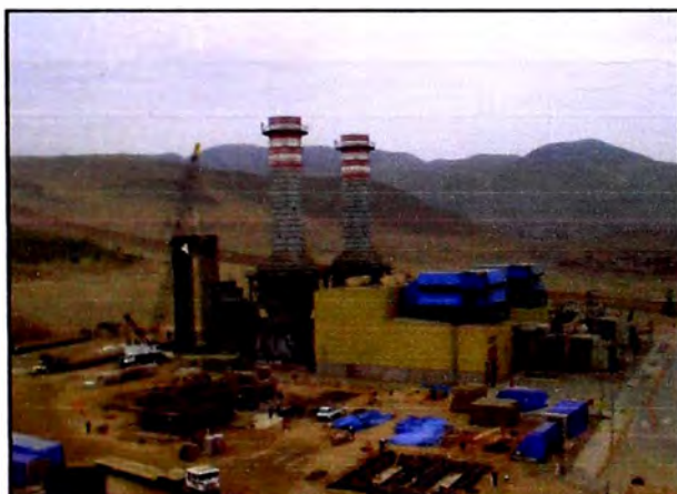
Foto 1: Obras civiles y de montaje 1
