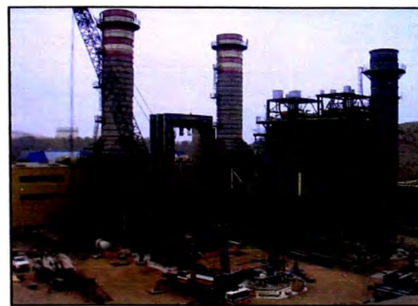
Foto 9: Montaje de HRSG 1 y 2
