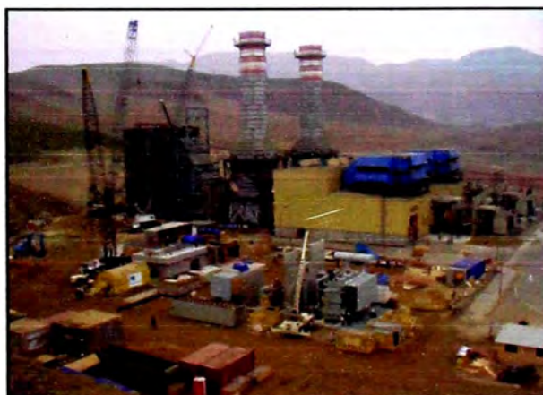
Foto 4: Obras civiles y de montaje 4
