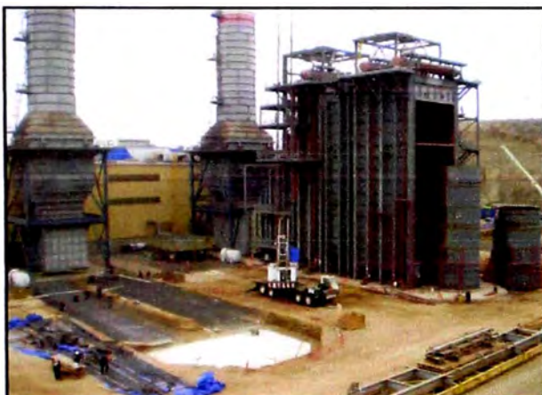
Foto 5: Montaje HRSG1 y cimentación HRSG2
