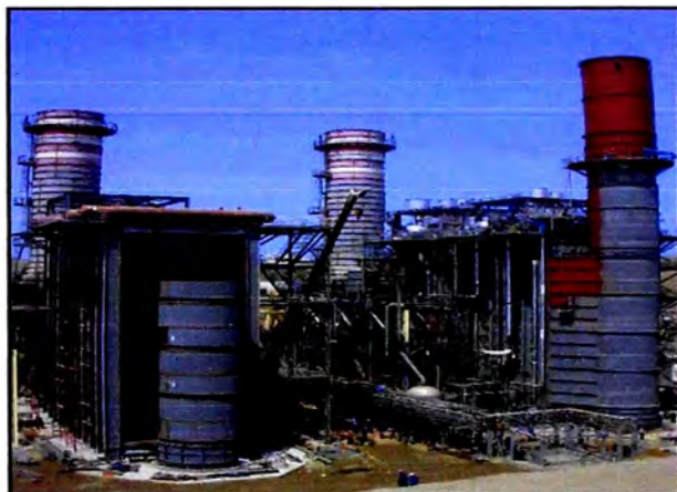
Foto 12: Montaje de HRSG 1 y 2
