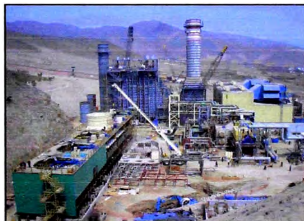
Foto 8: Obras civiles y de montaje 7
