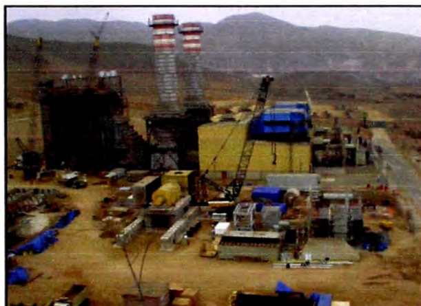
Foto 6: Obras civiles y de montaje 5
