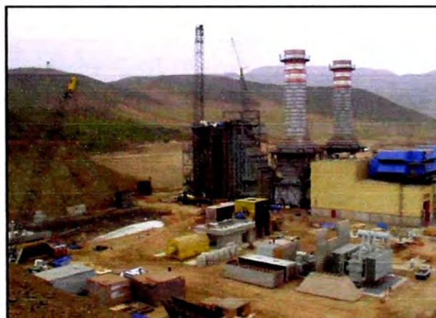
Foto 2: Obras civiles y de montaje 2
