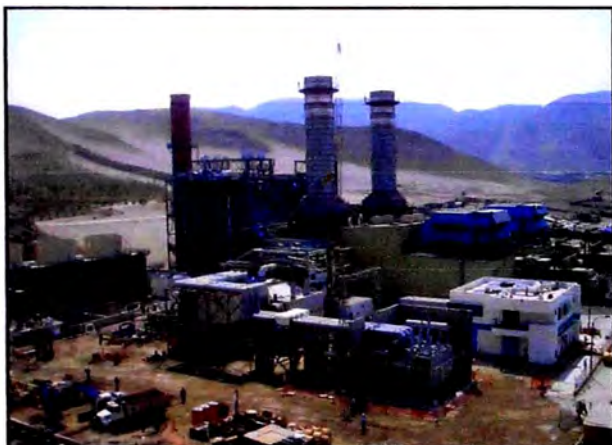
Foto 11: Obras civiles y de montaje 9
