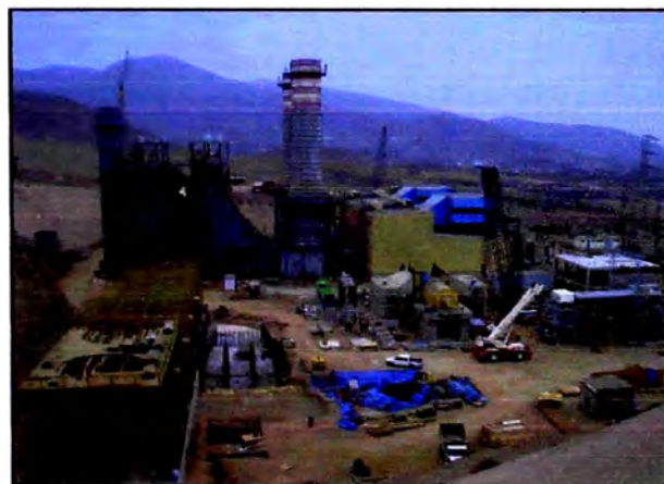
Foto 7: Obras civiles y de montaje 6
