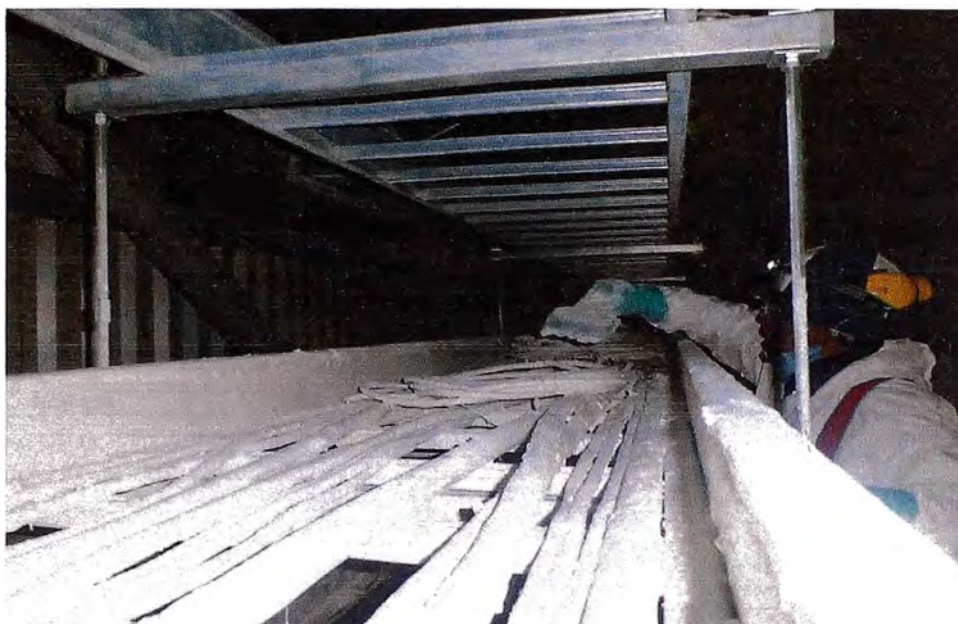
Figura N° 3.6.-Aplicación con brocha de Pintura ignifuga.
