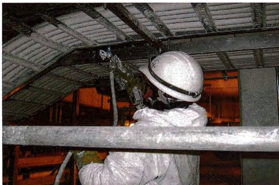
Figura N° 3.7.-Aplicación con pistola de Pintura ignifuga.
