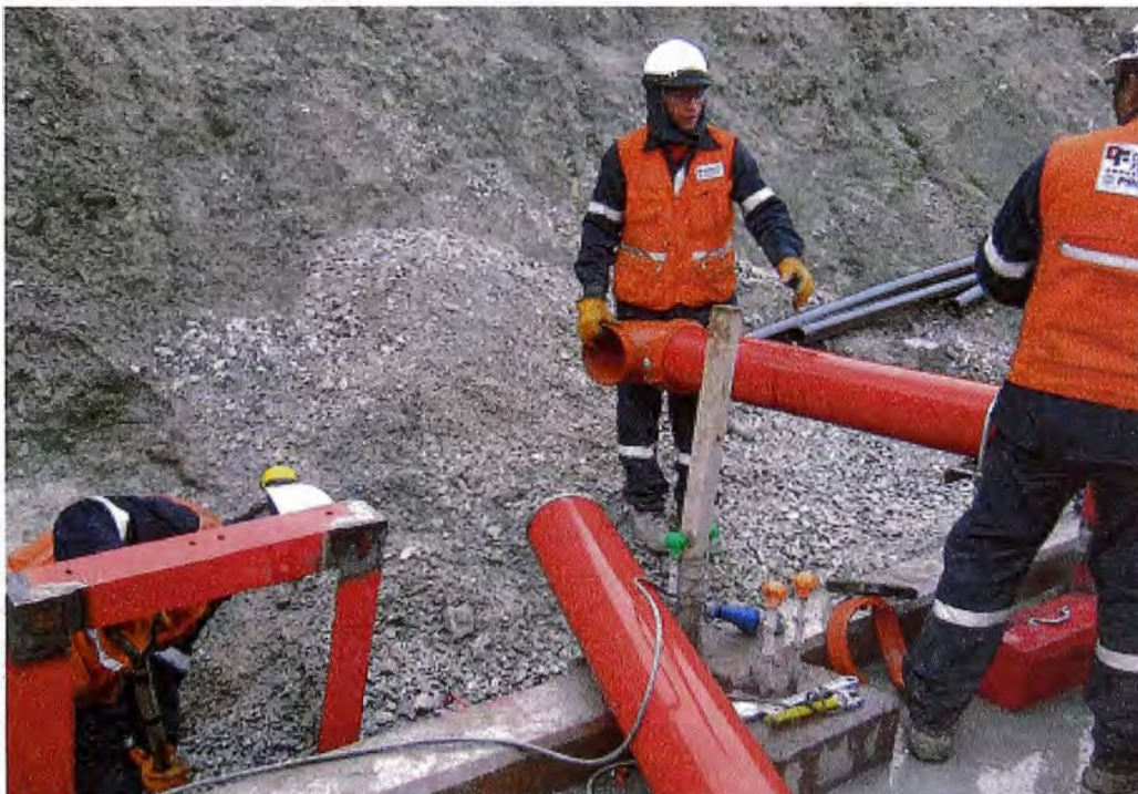
Figura N° 3.14.-235-CC14-P-IDT-003-Skid de Bomba –instalación de Tubería roja de 8”.
