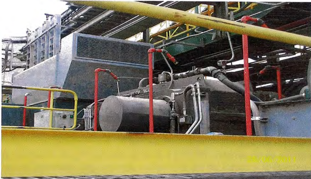
Figura N°1.11.-Instalacion de Sistema de Spray en Área 220-Motor C.
