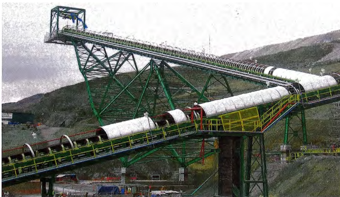
Figura N°1.12.-Instalación de Tubería roja en Área 235 –Faja 624.
