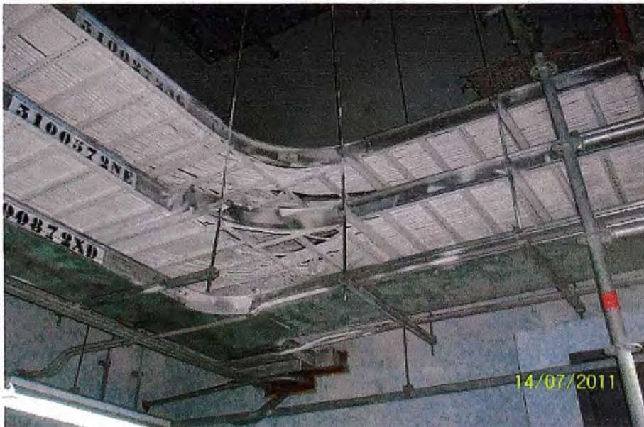
Figura N° 3.5.-Bandejas de Cable Térmico.
