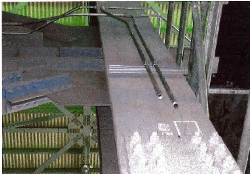
Figura N°1.10.-Instalacion de Tubería Conduit en Área 310-Sag N°2.
