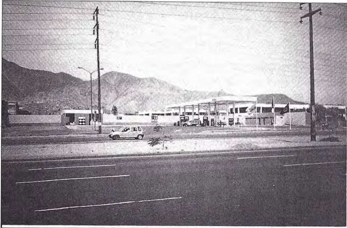
Figura N° 5.33 VISTA PANORAMICA TERMINADA Y FUNCIONANDO LA ESTACIÓN DE SERVICIOS SUPER MOBIL
