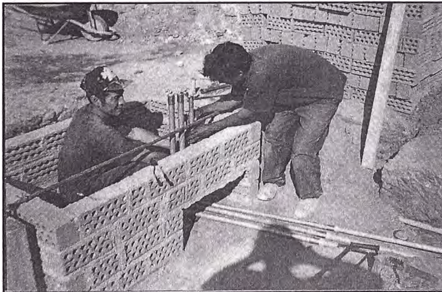
Figura Nº 5.29 La tuberías eléctricas llegan a la caja de albañilería con tubería galvanizada condulec es donde se ubicara el dispensador de combustible.
