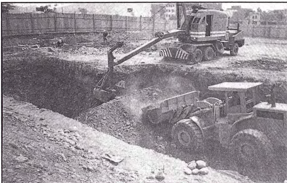
Figura N° 5.11 En esta toma las maquinas: retroexcavadora y el cargador frontal realizando la excavación masiva en la zona de tanques.
