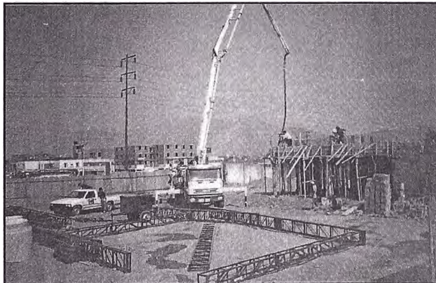
Figura N° 5.27 Se preparan la estructura del techo Canopy para luego izarlas sobre las columnas
