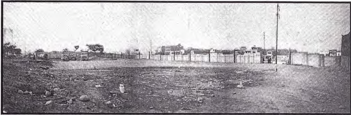
Figura N° 5.8 En esta vista se observa que los cortes masivos se llegaron hasta los niveles deseados para luego replantear los niveles y trazar las zonas donde se realizaran las excavaciones de zanjas de las diferentes zonas. Se observa que se están retirando las rejas metálicas y se han colocado el cerco provisional de obra.
