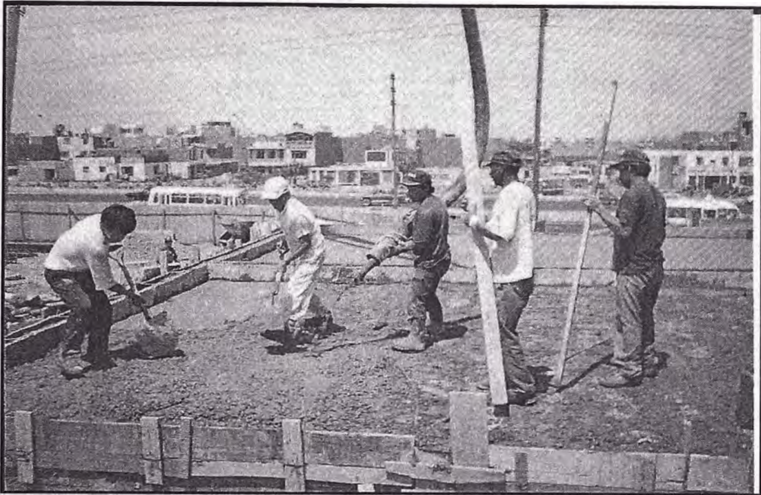
Figura N° 5.15 En la etapa final se comienza en llenar la losa de 5 cm y hacer el regleado para su acabado final.
