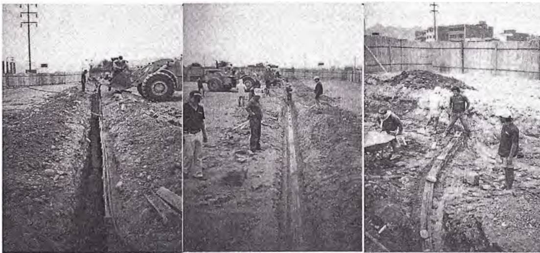
Figura N° 5.2. Reparación del cable eléctrico
