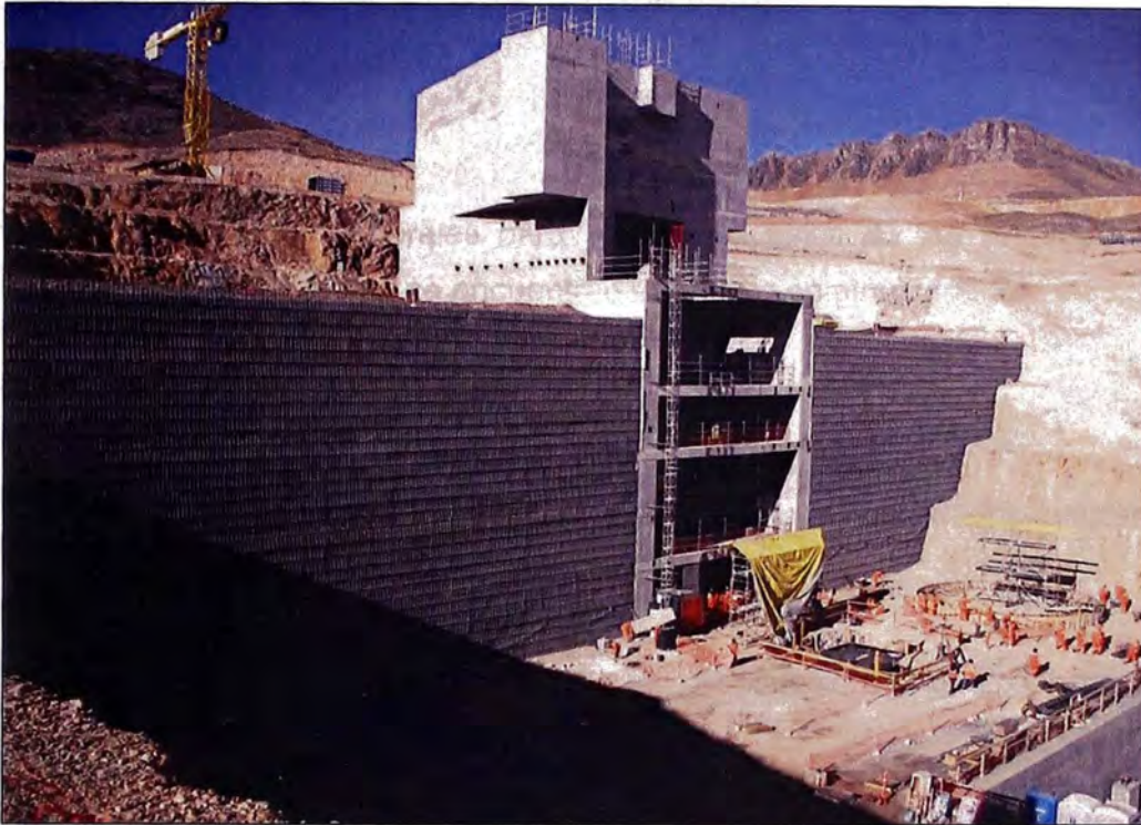
Figura N° 2.03 Imagen de la chancadora primaria
