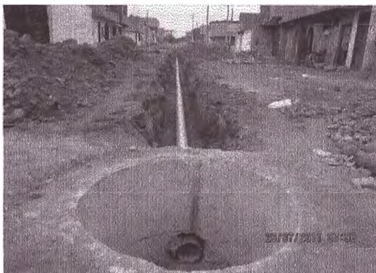
Fotografía 2: Instalación de red de alcantarillado
