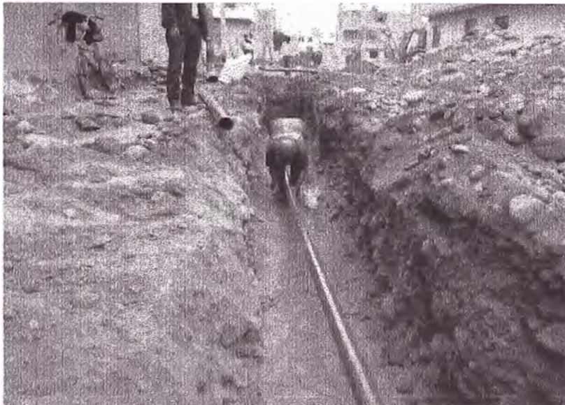
Fotografía 5: Instalación de red de agua potable
