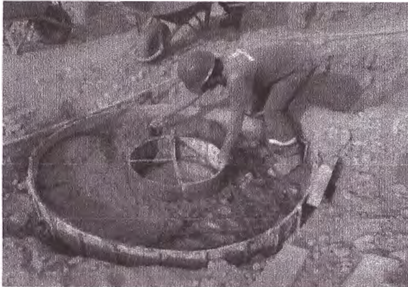
Fotografía 4: Construcción de buzones
