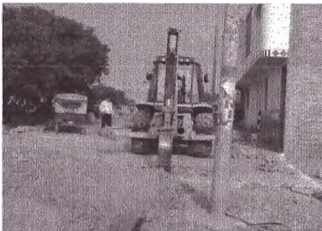
Fotografía 1: Excavación de zanjas con retroexcavadora
