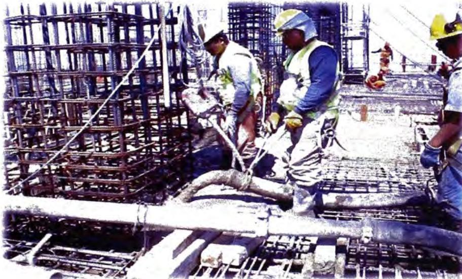
Figura 10: Vaciado de concreto premezclado en elementos horizontales
