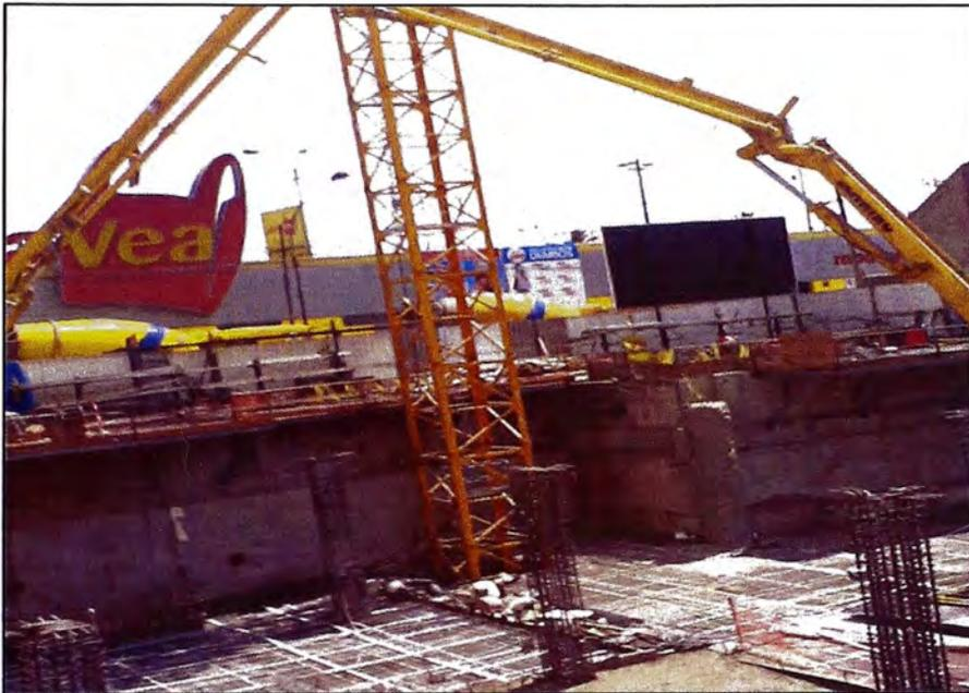
Figura 38: Vaciado de concreto en sótanos con pluma Autotrepante
