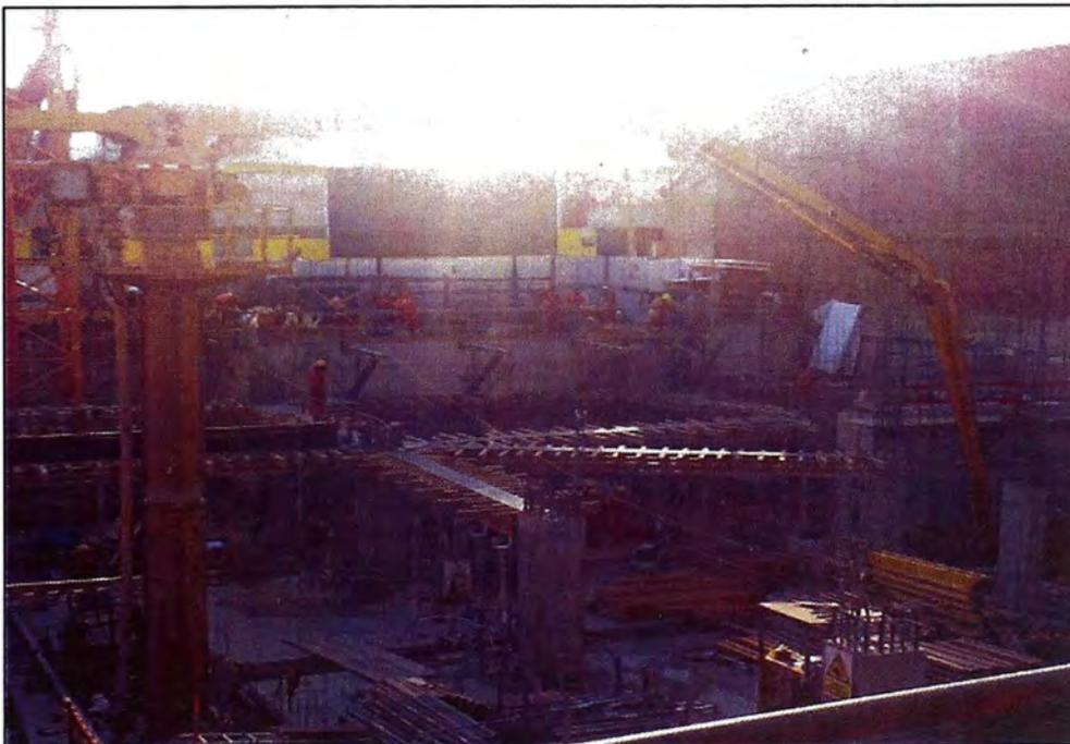
*Figura 60: Vaciado de concreto premezclado en zonas complicadas*
