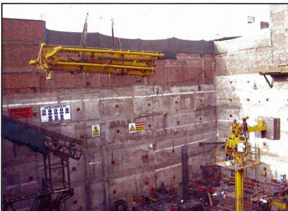
*Figura 52: Instalación e pluma de 3100kg con accesorios en peso aproximado de 400kg (considerando un peso por el concreto aproximadamente entre 500 a 900kg dependiendo de la longitud de la tubería)*
