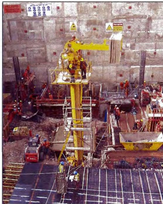
*Figura 50: Colocación de 2 contrapesos – vista lateral*
