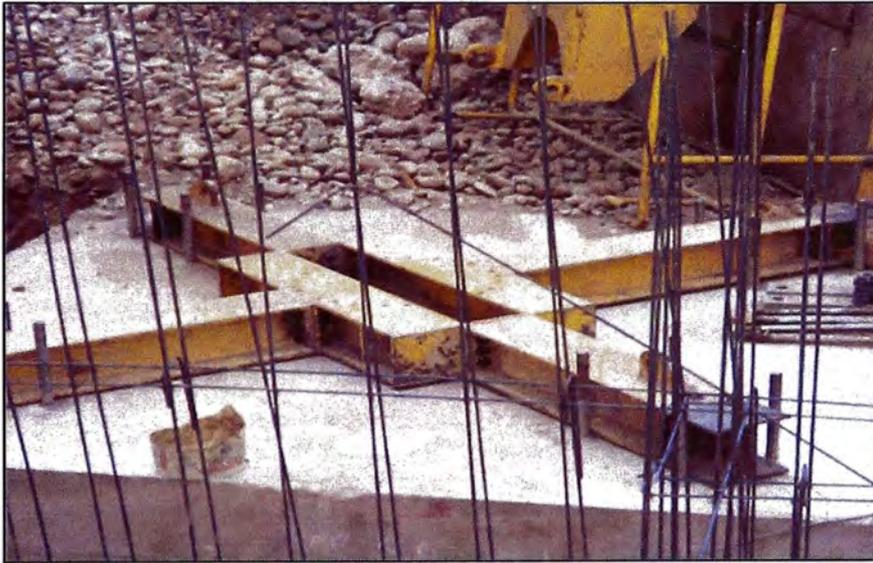
*Figura 47: Colocación de soporte en forma de cruz*
