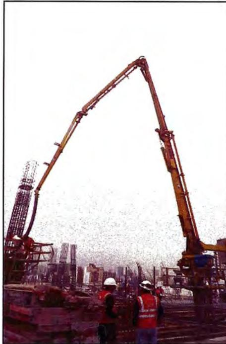
*Figura 63: Vaciado vertical con pluma trepadora*
