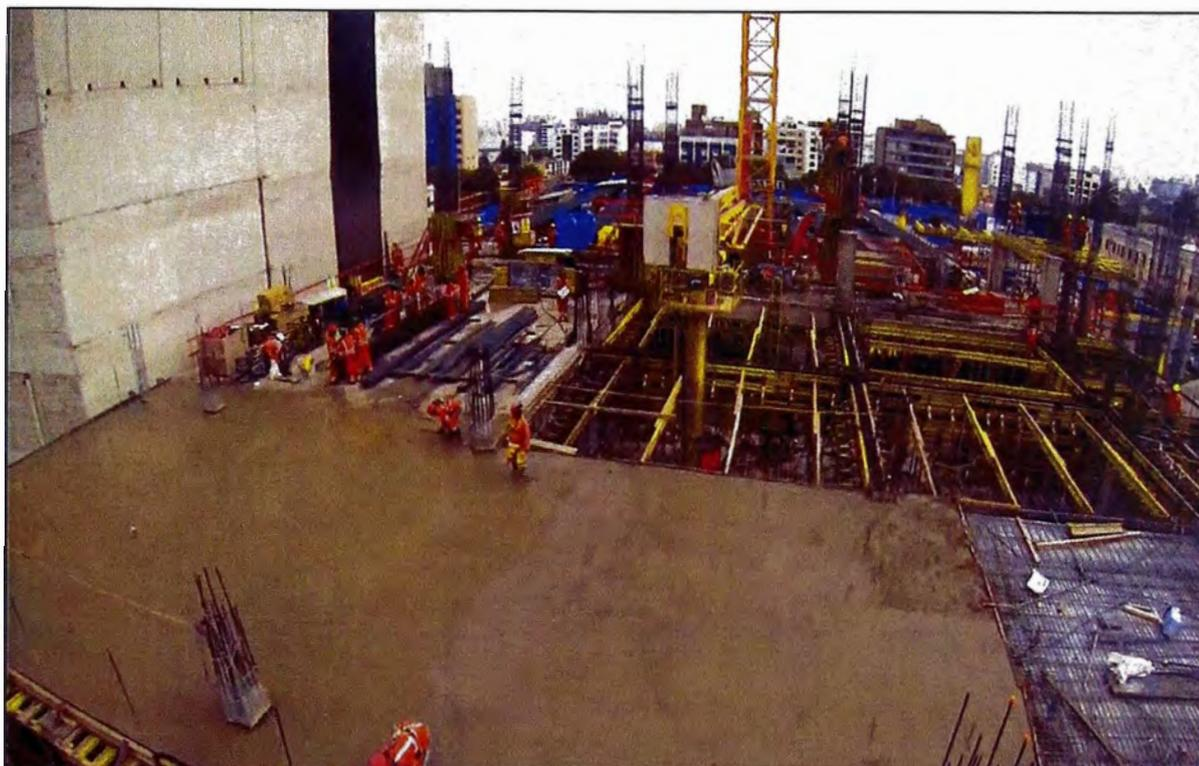
*Figura 44: Vaciado de torre con pluma Autotrepante*
