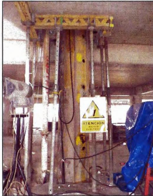
Figura 57: Tipo de apuntalamiento para soportar y distribuir las cargas del brazo a lo largo de toda la edificación
