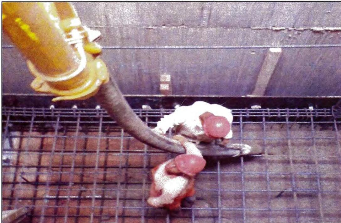
*Figura 62: Vaciado de concreto premezclado con apoyo de personal de obra*
