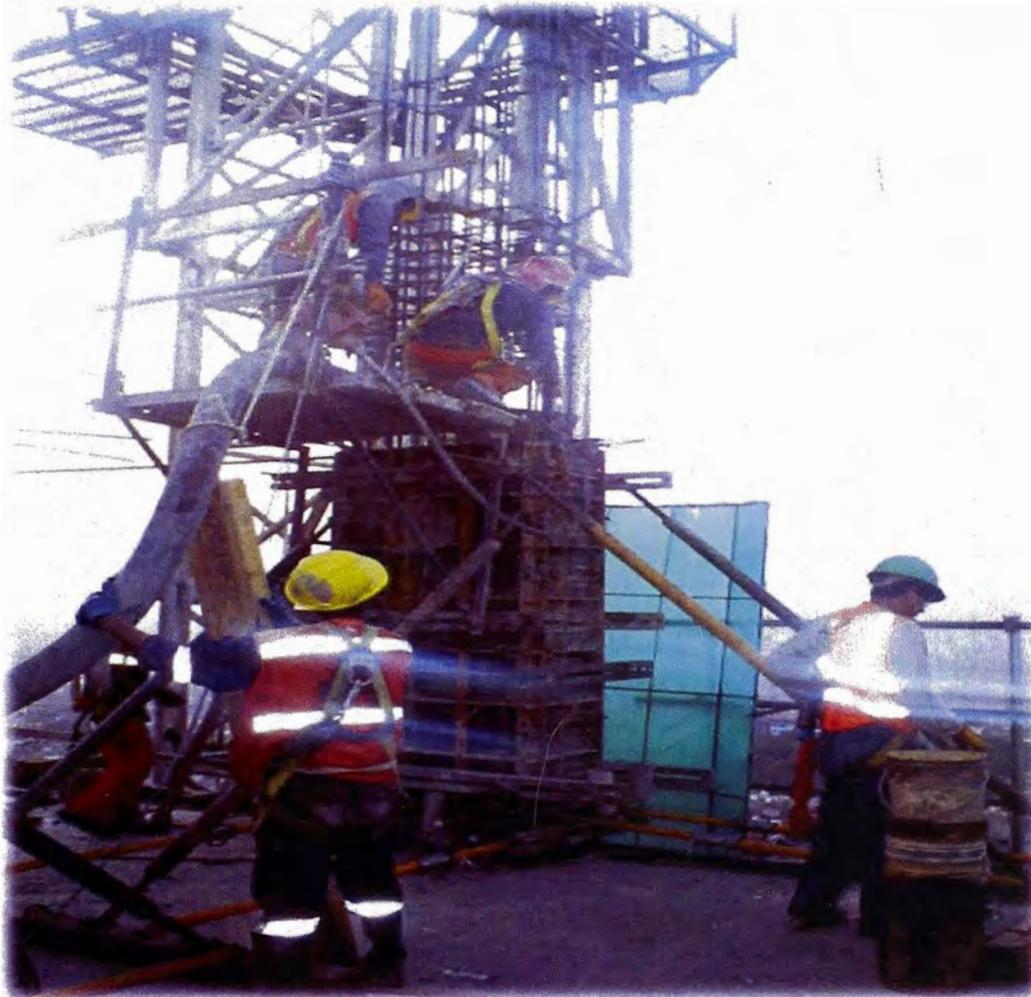
*Figura 11: Vaciado de concreto premezclado en elementos verticales*
