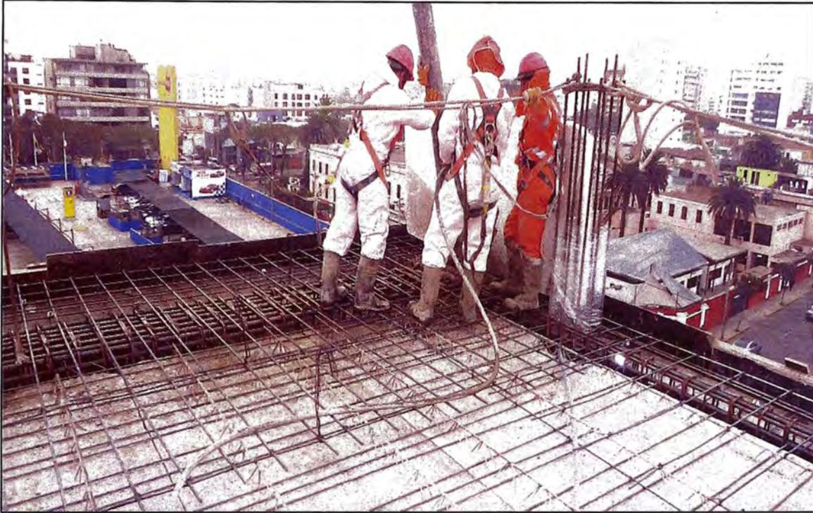
*Figura 65: Vaciado de concreto premezclado en vigas*
