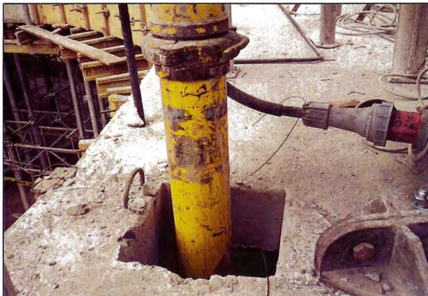
*Figura 56: Llenado de concreto para ducto de pluma trepadora*
