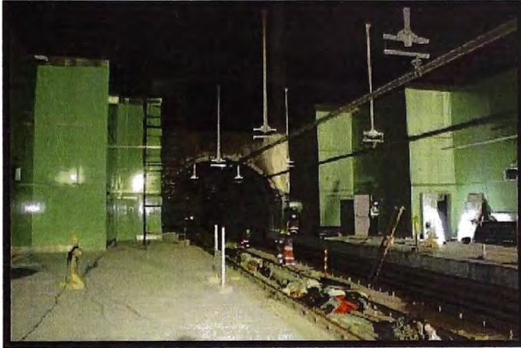
Figura 4.18: Acabados Arquitectónicos de la Estación.
