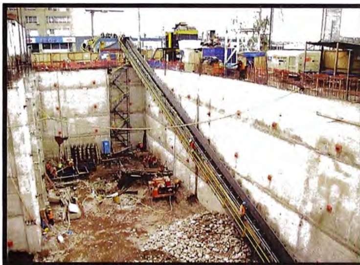
Figura 2.12: Muros Anclados como sostenimiento de excavación.
