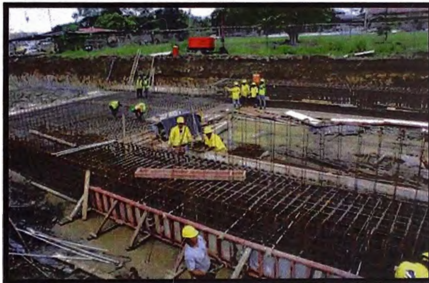
Figura 4.12: Arado del Acero de refuerzo de la Losa de Cobertura.
