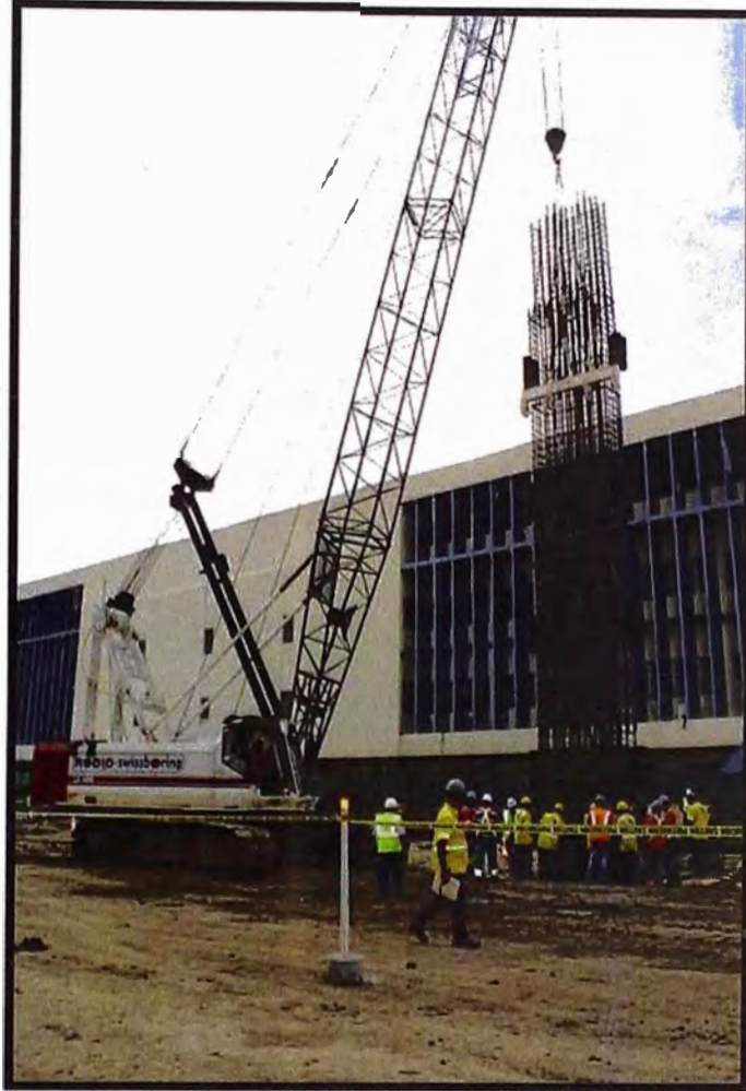
Figura 4.7: Izaje de la armadura de refuerzo de los muros pantalla.
