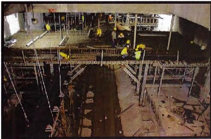
Figura 4.17: Construcción de la Losa de Mezanine.
