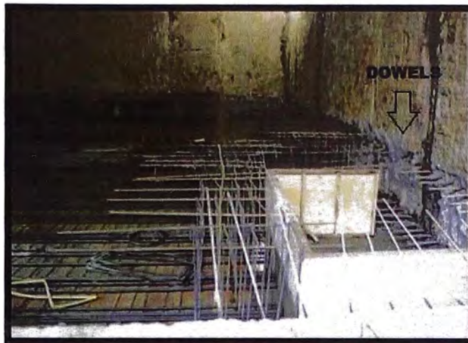
Figura 4.14: Armado de Acero para el refuerzo de la losa de Vestíbulo y dowels en el muro pantalla.
