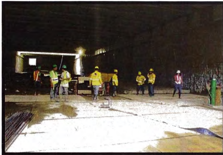
Figura 3.6: Encofrado de la losa de Vestíbulo (Tableros fenólicos).
