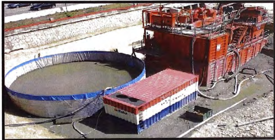
Figura 4.3: Planta de Lodos bentoníticos
