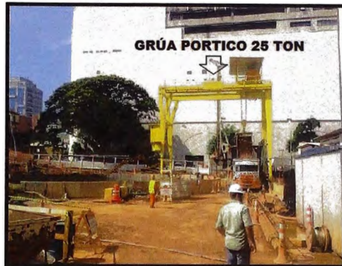
Figura 4.13: Grúa Pórtico para la excavación de la estación.
