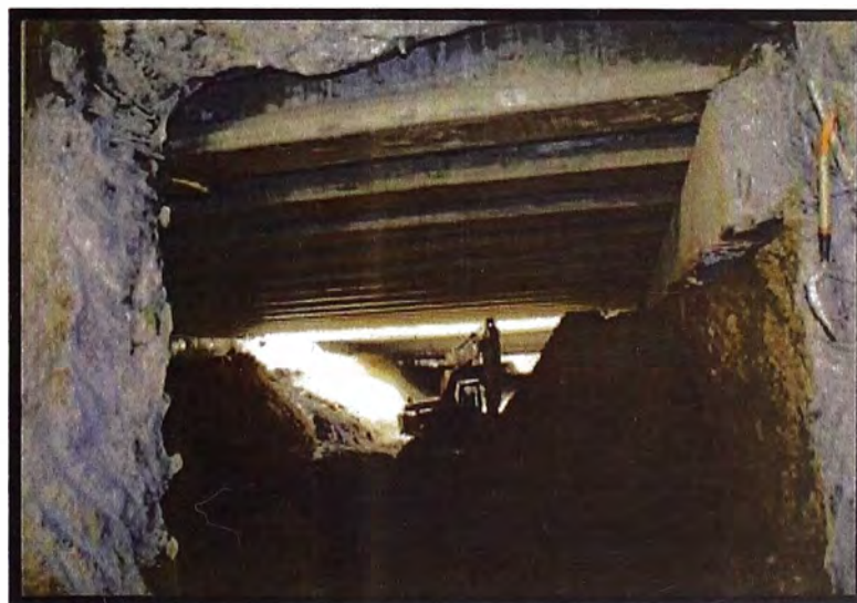
Figura 3.5: Excavación de la losa de Vestíbulo con excavadora.
