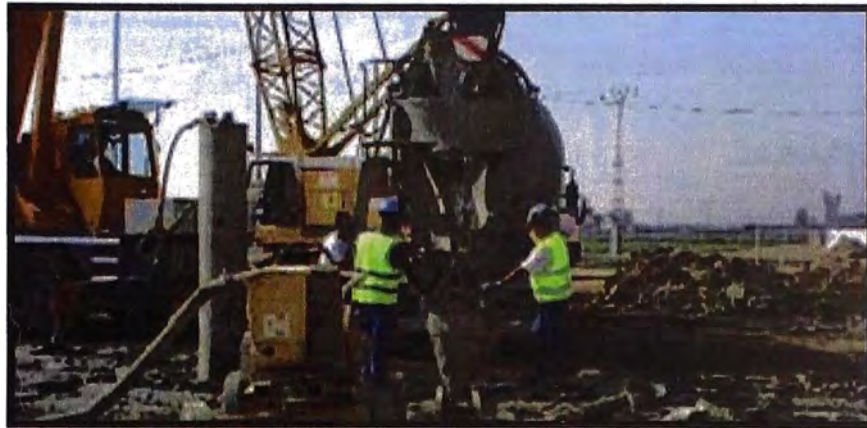
Figura 4.9: Proceso de Vaciado de Concreto para los muros pantalla.
