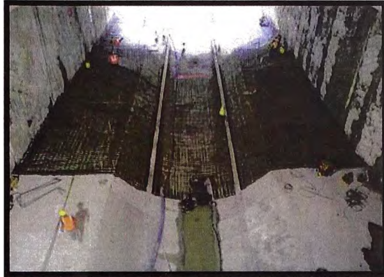
Figura 3.7: Construcción de la losa de fondo (armado de Acero de refuerzo y vaciado de concreto).
