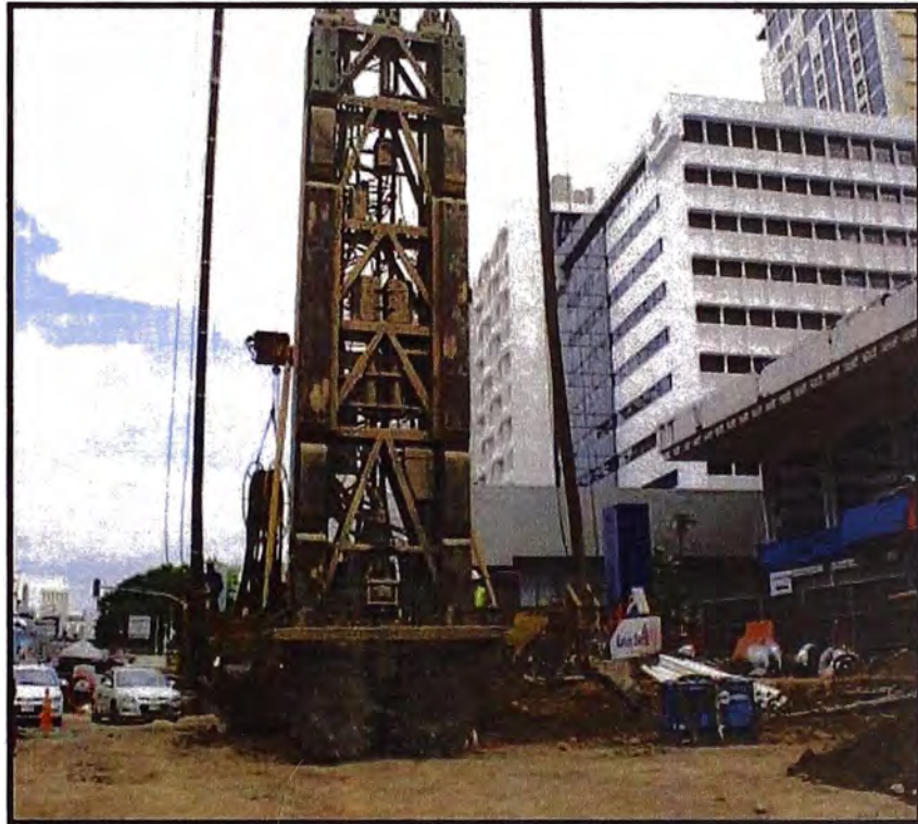
Figura 4.6: Equipo Hidrofresa, usado para la excavación de muros pantallas.
