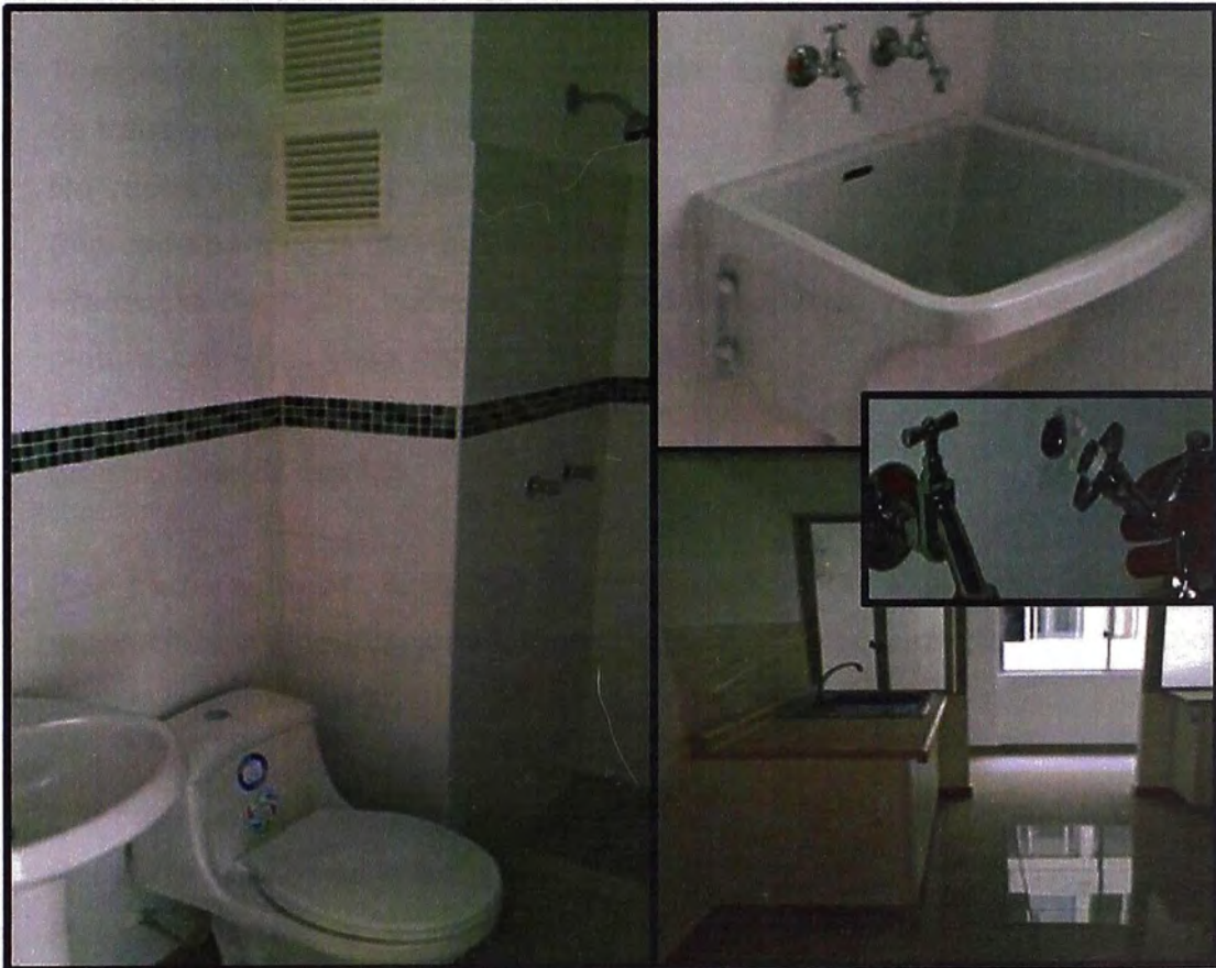
Figura N° 22.- Colocación de griferías y aparatos sanitarios
