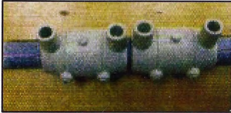
Figura N°32.- Colocación de coplas
