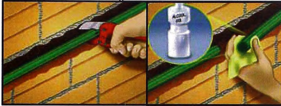
Figura N°34.- Corte y limpieza de tubería
