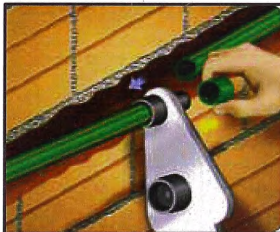
Figura N°35.- Primera fusión tubería – copla
