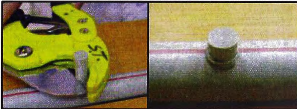
Figura N°28.- Corte de excedente de tarugo
