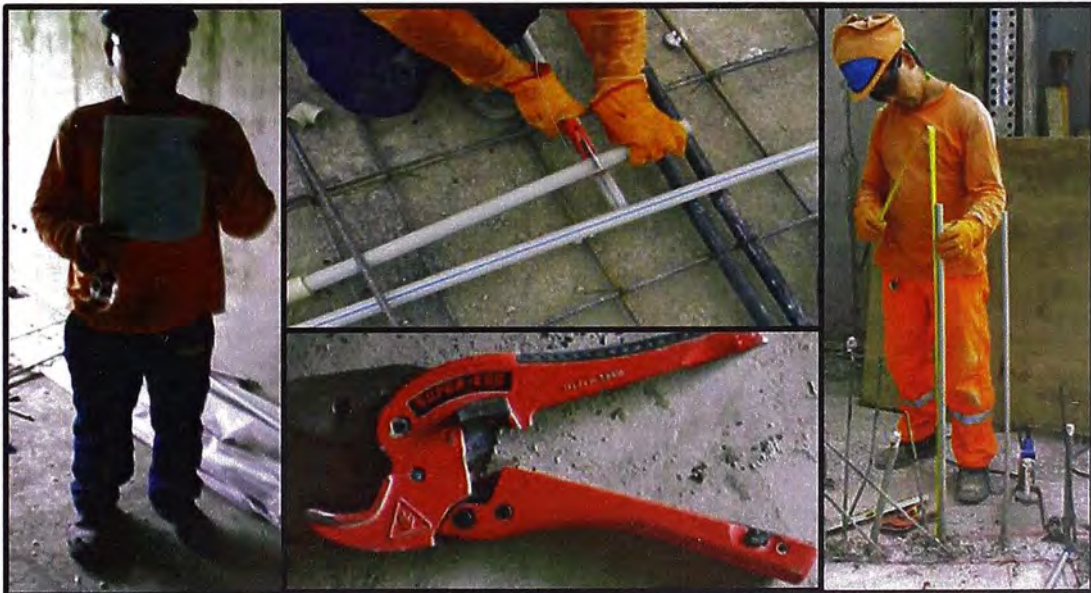
Figura N° 4.- Corte de tubería
