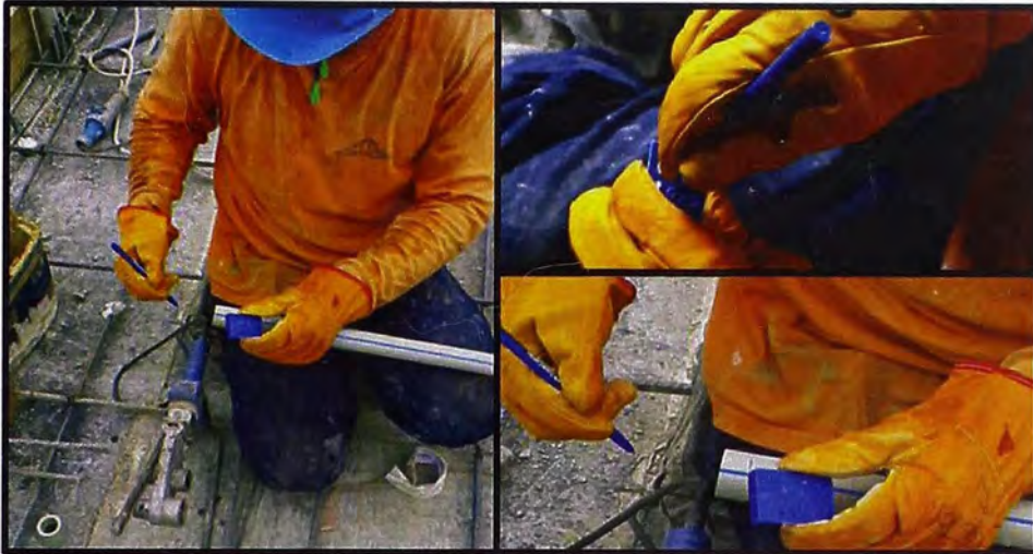
Figura N°5.- Marcación de tuberías
