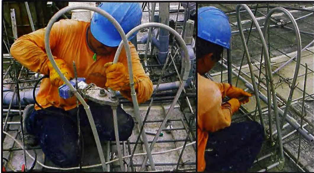
Figura N°14.- Cerrando circuitos para prueba hidráulica
