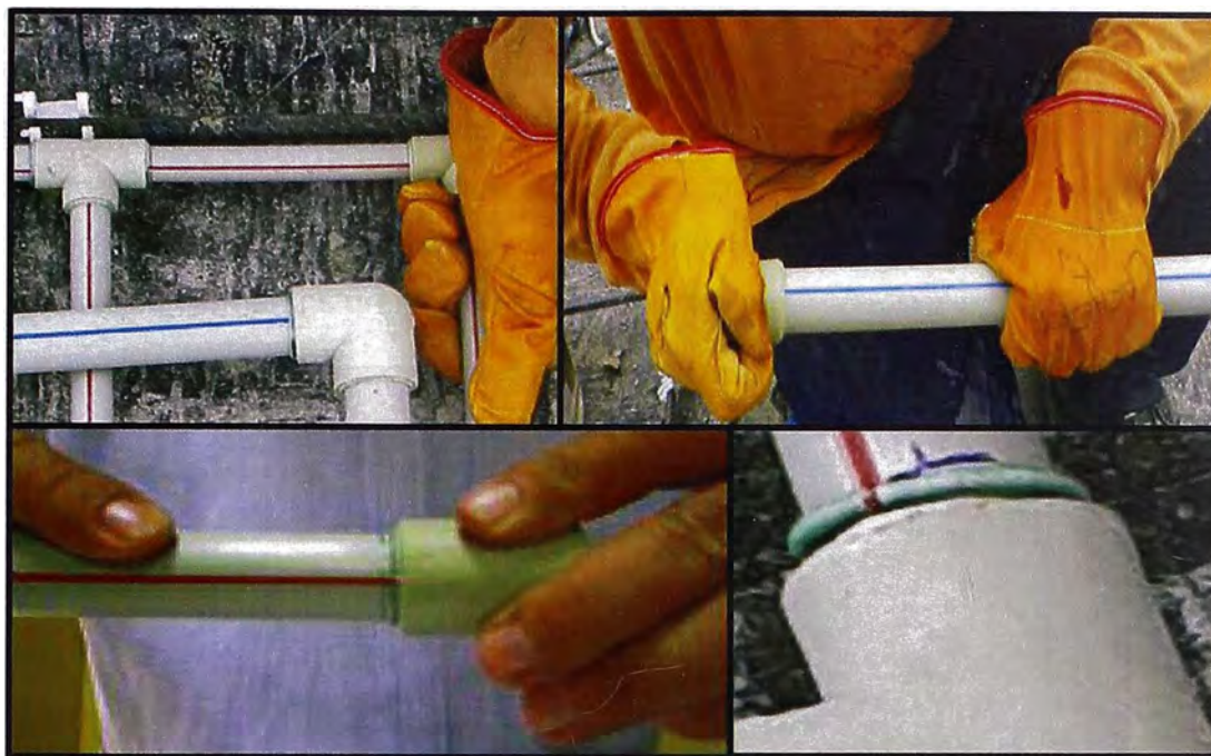
Figura N°9.- Fusión de tubería y accesorio
