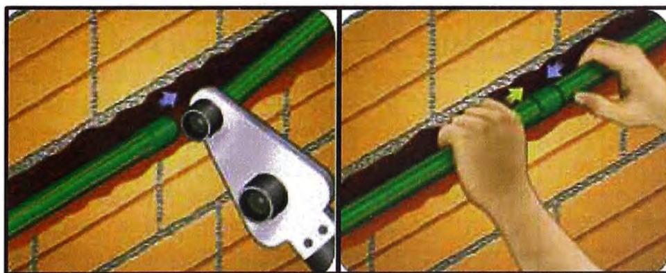
Figura N°37.- Segunda fusión copla – tubería
