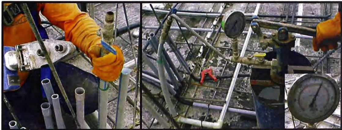
Figura N°16.- Prueba de presión hidráulica en el proyecto Florencia
