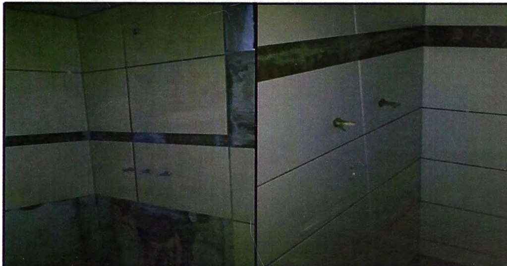
Figura N° 20.- Protección con maskigtape de vástagos
