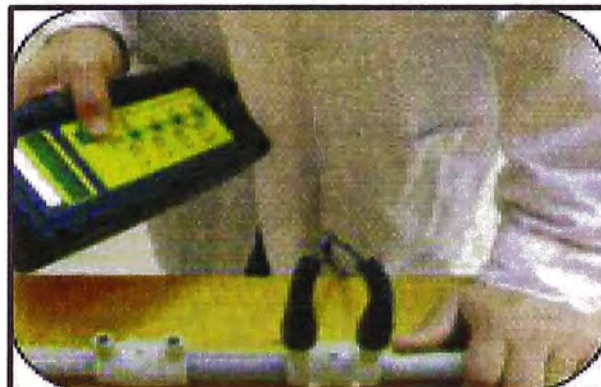
Figura N°33.- Electrofusión de las coplas y la tubería de PPR
