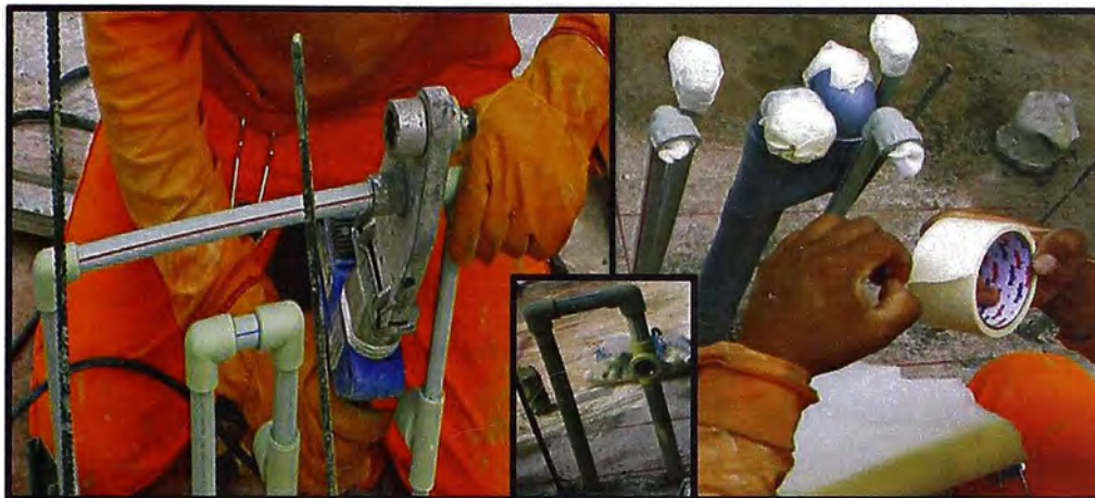
Figura N°17.- Fusión de tuberías y accesorios que van por el muro
