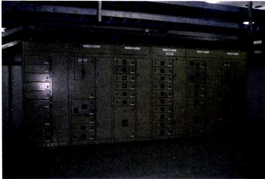
Figura 4.4 – Vista de tableros de Centro de Control de Motores
