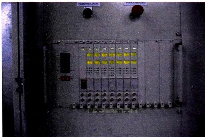
Figura 4.7 – Vista del equipo de monitoreo de vibraciones
