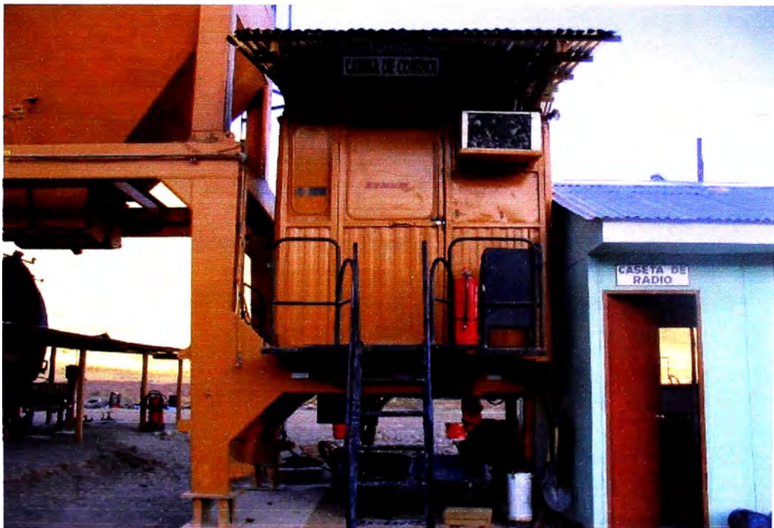
Fig. 2.2.1 Cabina de control.
