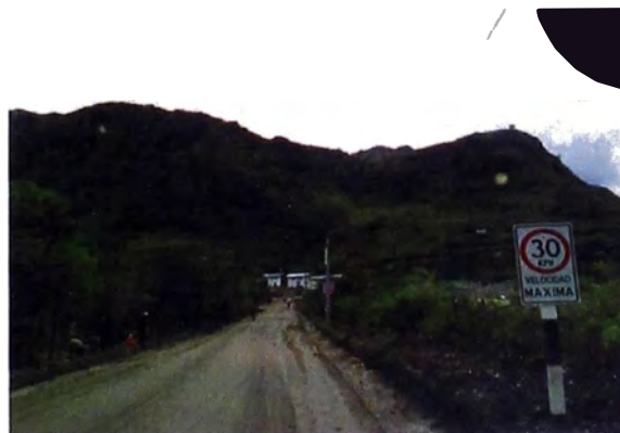
Puente Salida Cochabamba, condición actual
