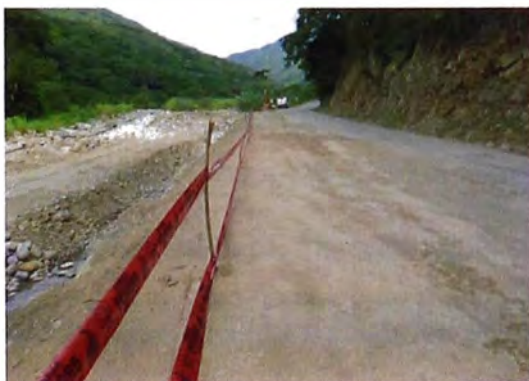
Construcción de muro km 84
