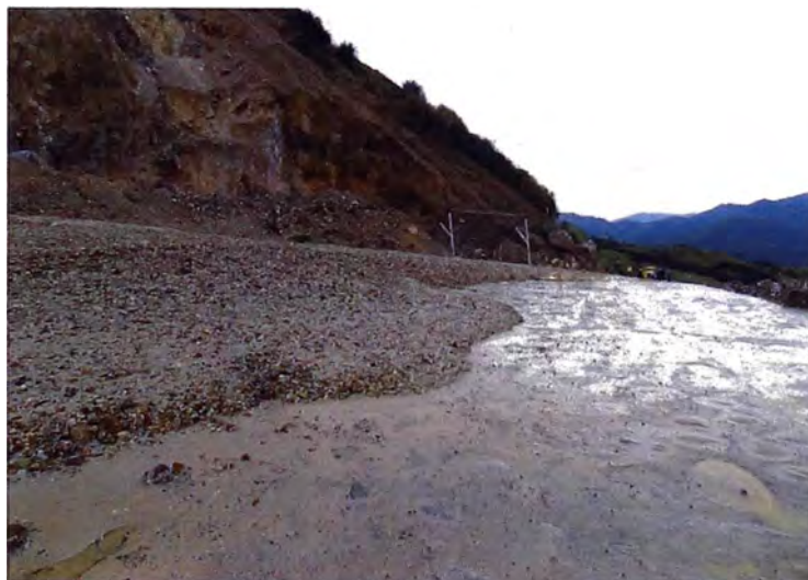
Obstrucción del tránsito en la carretera
