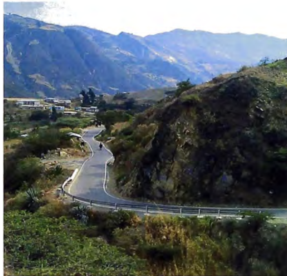
Condiciones Geométricas actuales de la vía
