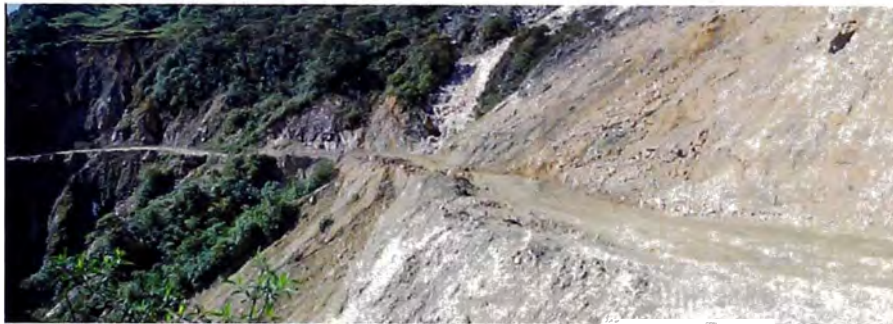
Panorámica de la zona crítica condición anterior
