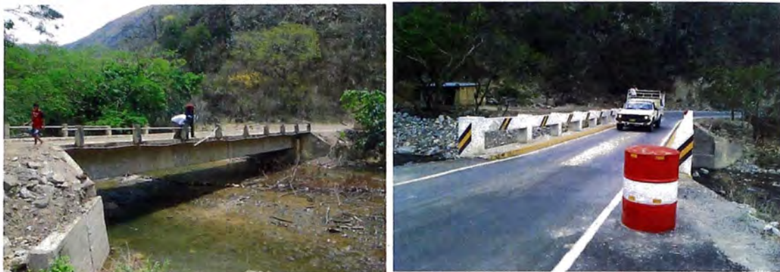
Puente Juntas, condición anterior y actual
