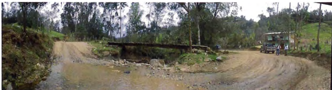
Progresiva 42+773.51 badén existente 2010
