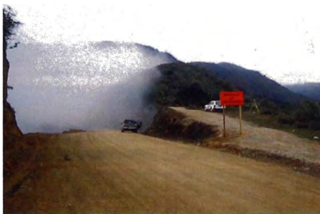
Zona crítica, con neblina permanente y desvío, antes de extendido la cama impermeabilizante Slurry
