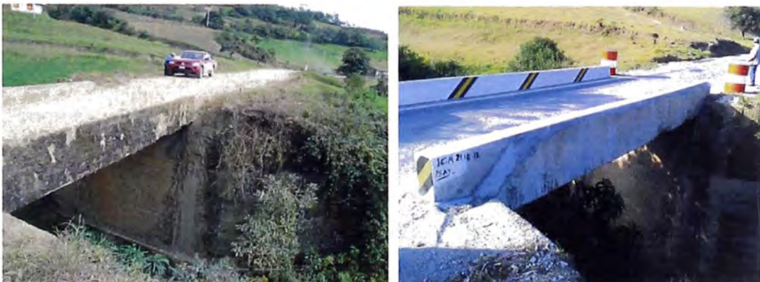
Pontón de concreto armado condición anterior y actual
