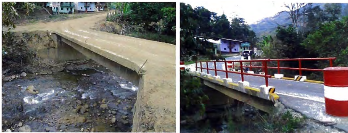
Puente Limas Prog 68+059.65 Condición anterior y actual
