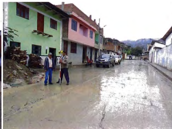
Inicio de tramo Prog 0+000 (Nov 2012)
