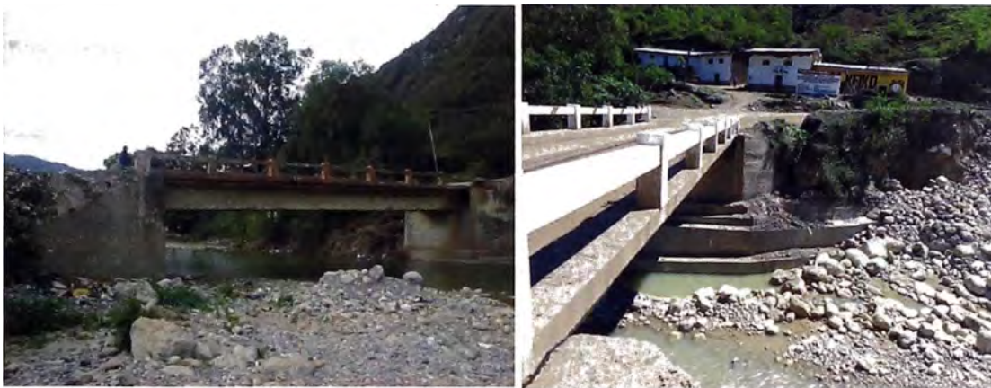
Puente Cutervino Prog: 0+260 condición anterior y condición actual
