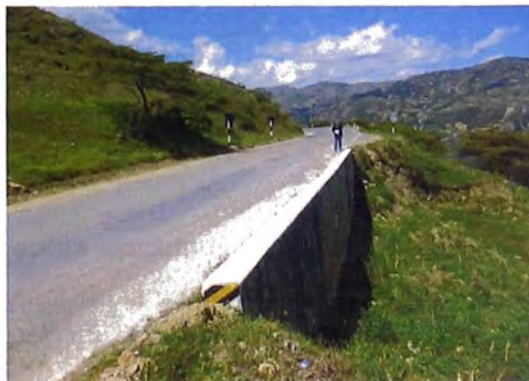
Muro de concreto nuevo km 20
