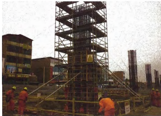
Foto 07: Encofrado de columna, primera etapa de la columna
