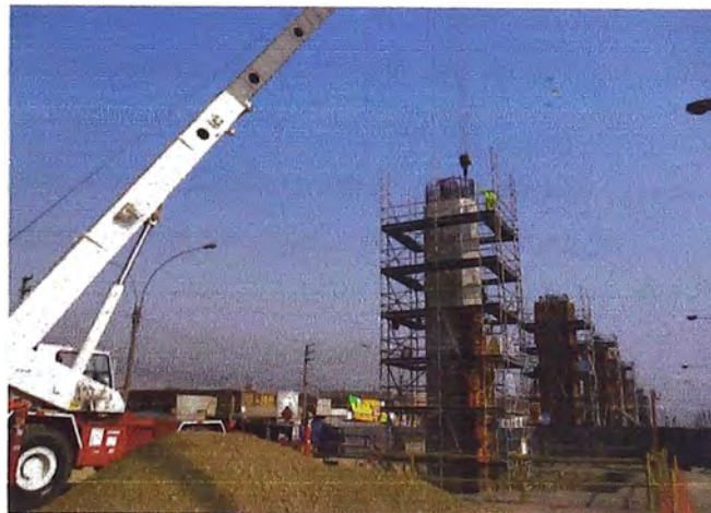
Foto 09: Desencofrado de columna
