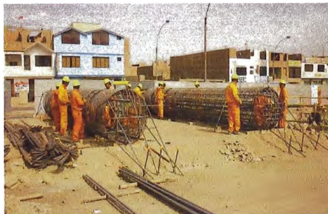
Foto 05: Pre-armado de acero de columna a nivel de terreno
