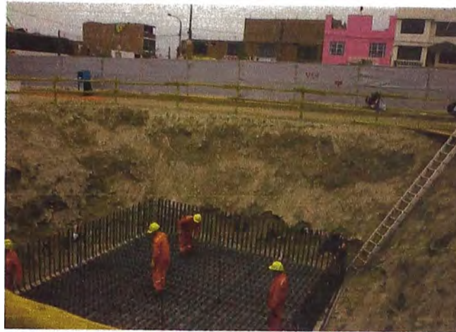
Foto 03: Habilitación de acero para la zapata
