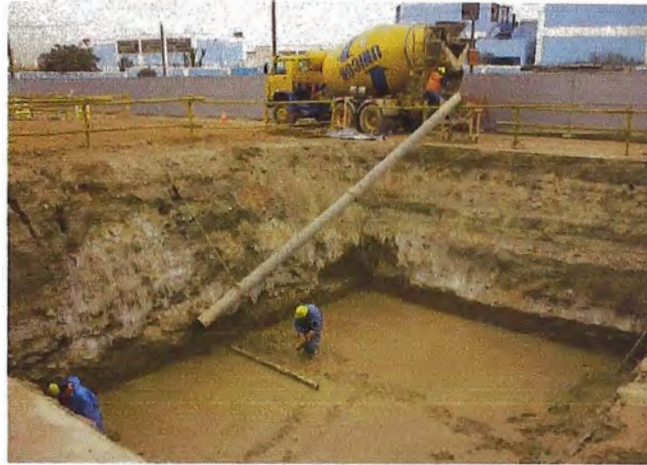
Foto 02: Solado para zapata
