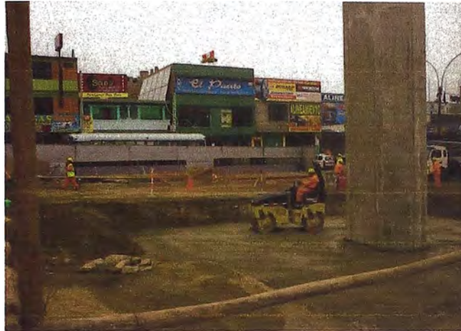
Foto 10: Relleno y compactación de la zapata
