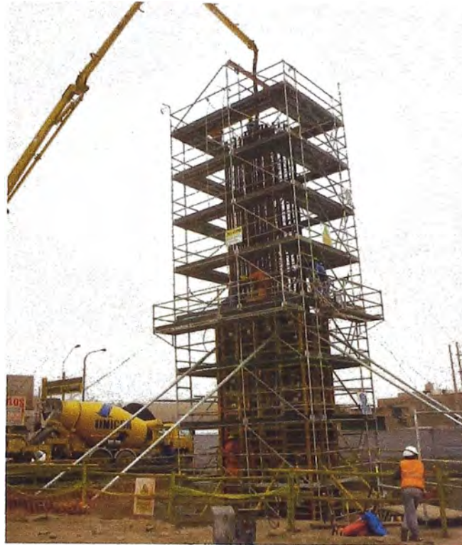
Foto 08: Concreto de columna
