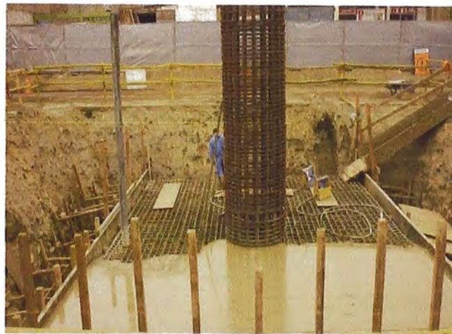
Foto 04: Concreto de zapata
