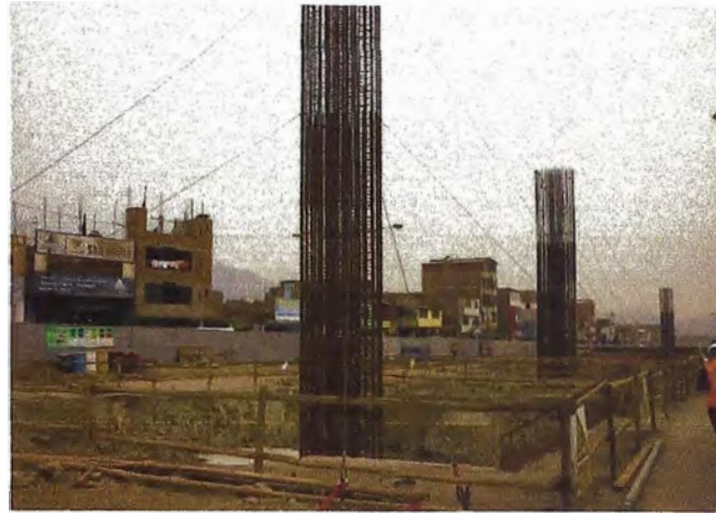
Foto 06: Acero de columna en posición vertical, sostenidos al terreno por tensores
