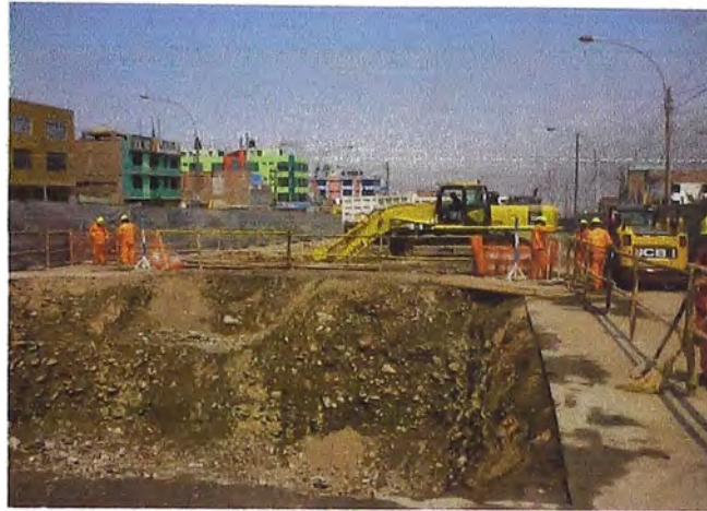
Foto 01: Excavación de zapata con equipo
