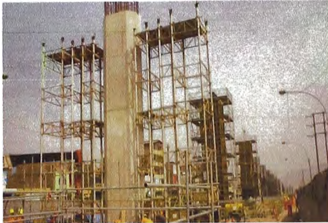
Foto 11: Alzaprimados o apuntalamiento para encofrado de cabezal
