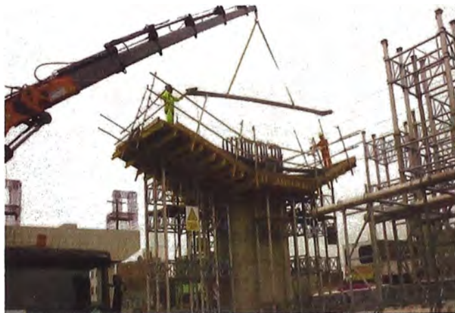
Foto 12: Colocación de acero para cabezal
