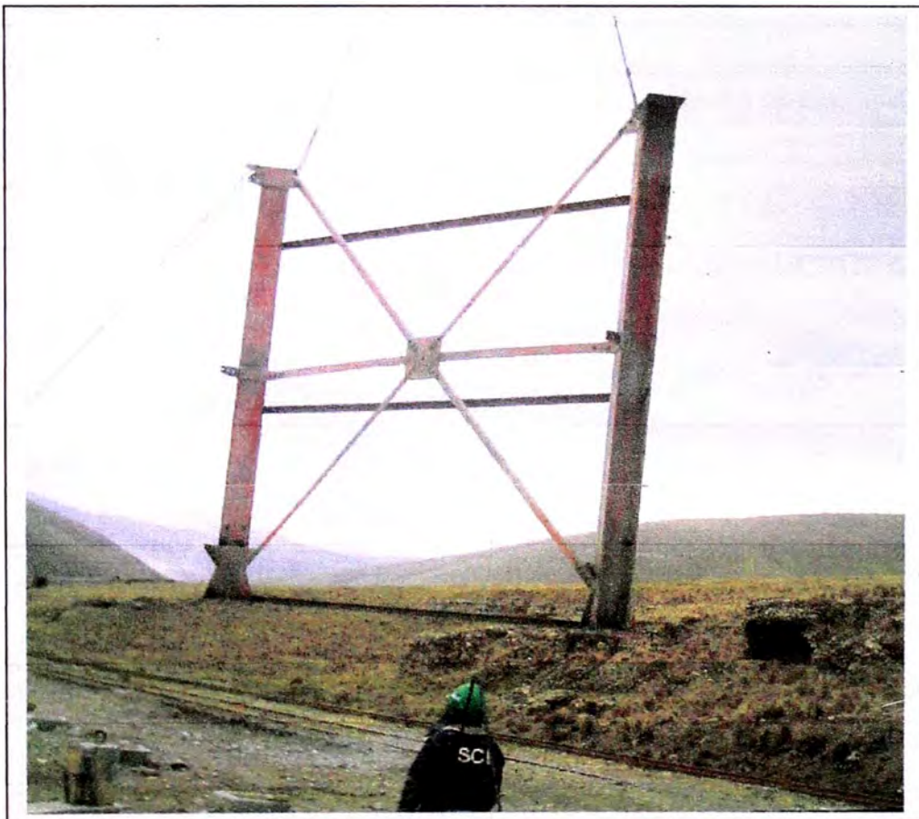
Figura 4.18: Retiro de pórtico
