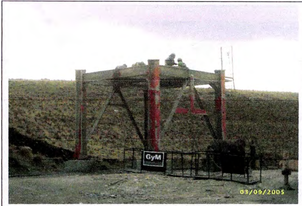
Figura 4.19: Retiro de pernos de amarre entre vigas, columnas y arriostres
