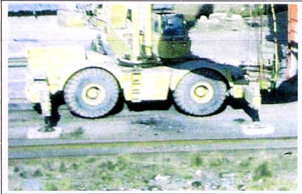
Figura 4.4: Instalación de tacos de madera en patas hidráulicas
