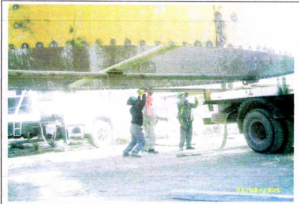
Figura 4.20: Se instalaron cruceetas en los anillos para evitar deformación al momento de ser trasladado
