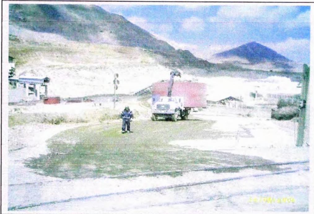
Figura 5.15: Reubicación de anillo desde zona de pintado al lugar de montaje
