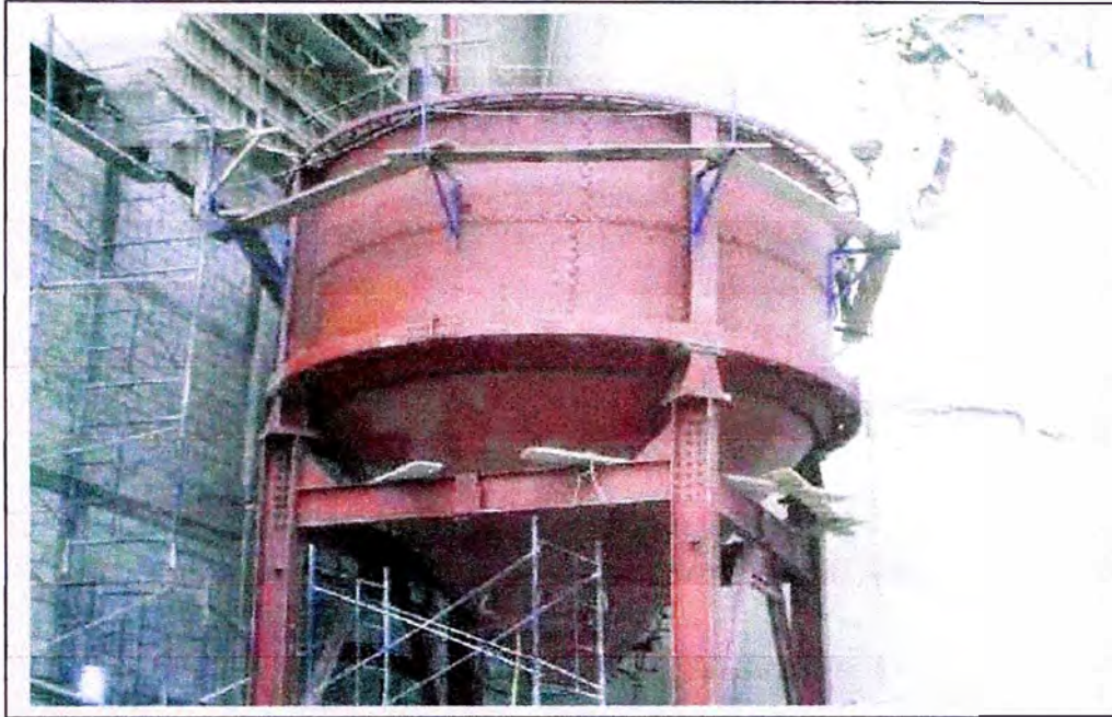
Figura 5.8: Vista de plataforma temporal instalada en la superficie del anillo
