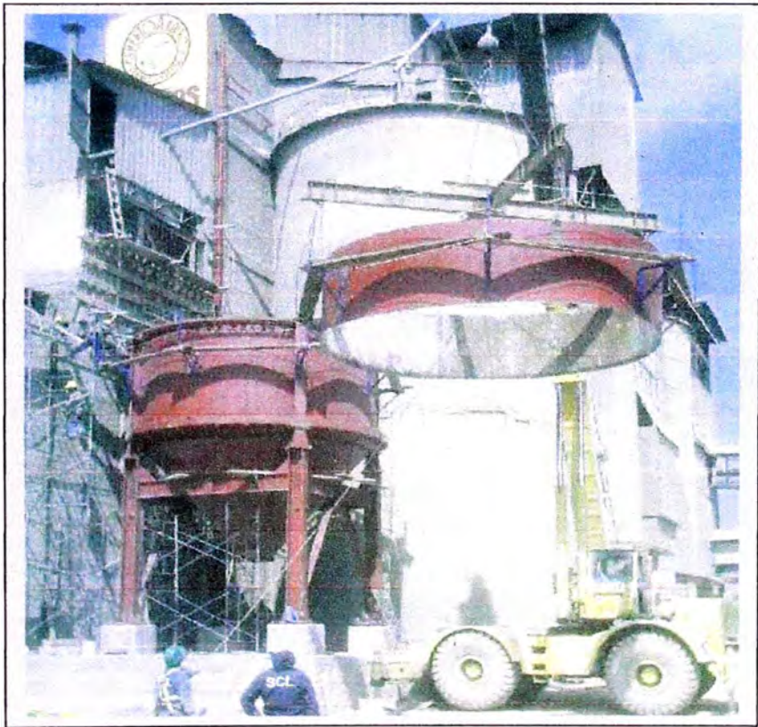
Figura 5.11: Izaje de anillo posición 7
