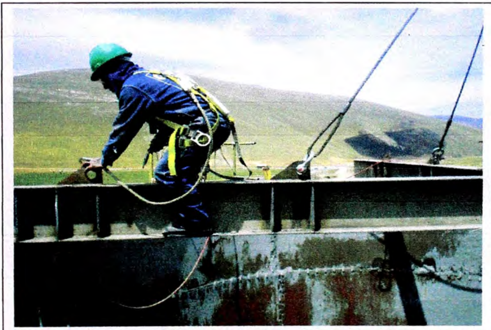
Figura 4.12: Operario retirándose luego de haber fijado el bastidor con el anillo posición 4
