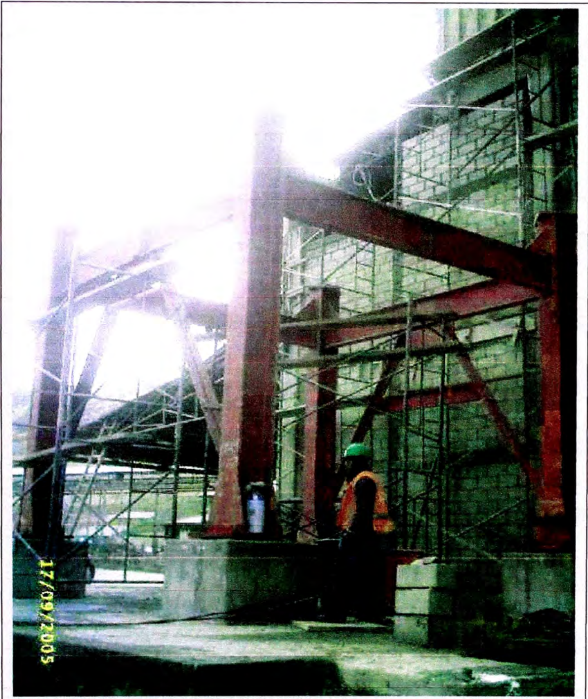
Figura 5.3: Estructura instalada listo para chequeo de alineamiento y nivelación
