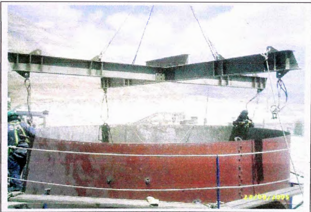
Figura 5.16: Fijación de estrobo en asas entre bastidor y anillo posición 6
