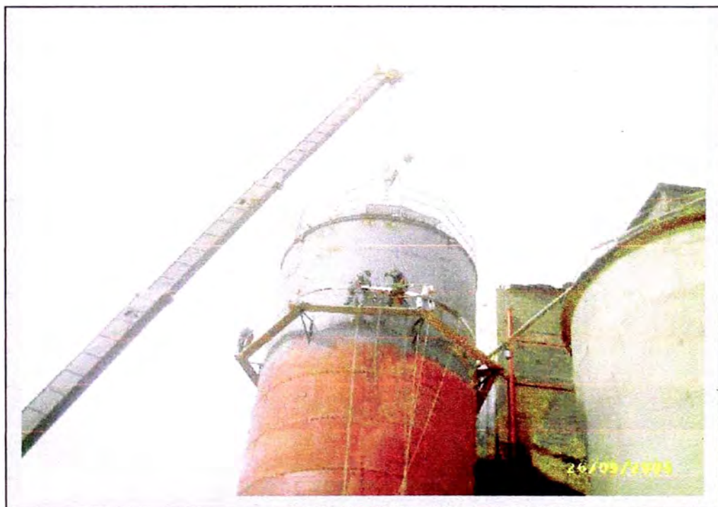
Figura 5.23: Instalación de pernos de amarre entre anillos
