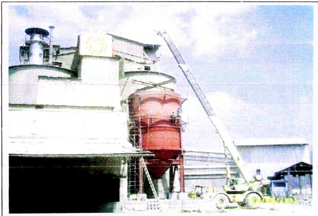
Figura 5.18: Posicionamiento de anillo posición 6
