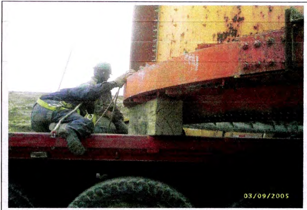
Figura 4.25: Nivelación de carga colocando tacos de madera
