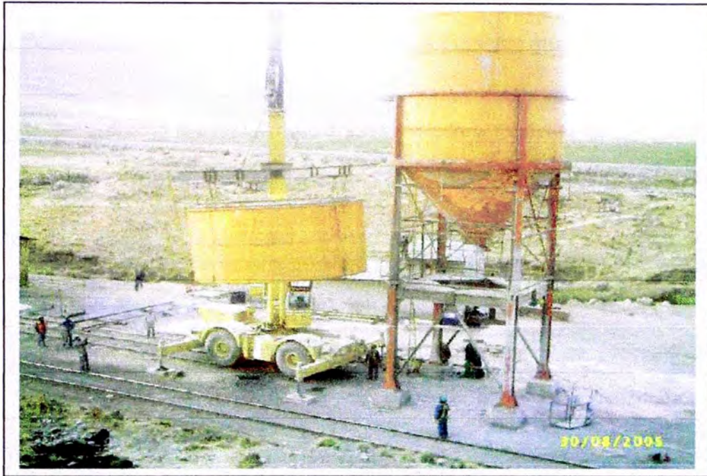
Figura 4.16: Descenso lentamente del anillo posición 4
