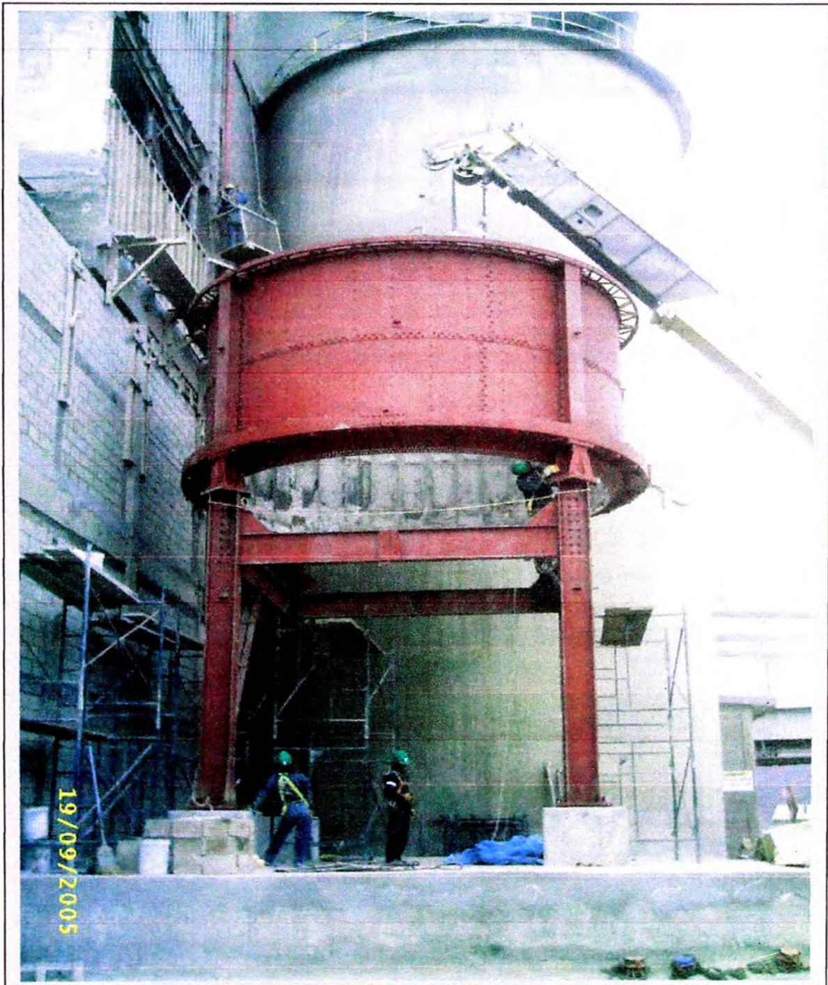
Figura 5.4: Montaje de anillo posición 8
