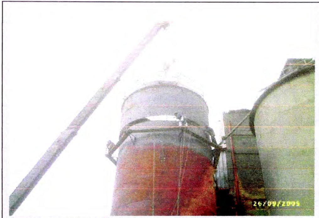
Figura 5.22: Posicionamiento de anillo
