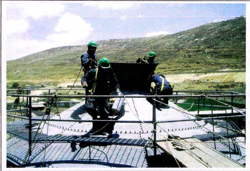
Figura 5.26: Instalación y fijación de transición de filtro (elemento posición 1)
