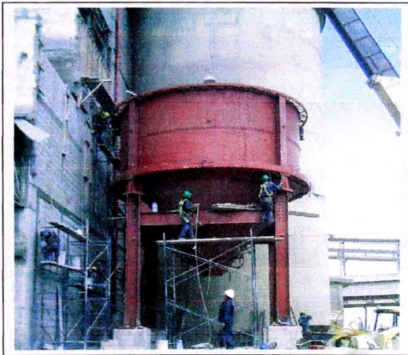
Figura 5.5: Montaje de elemento posición 9
