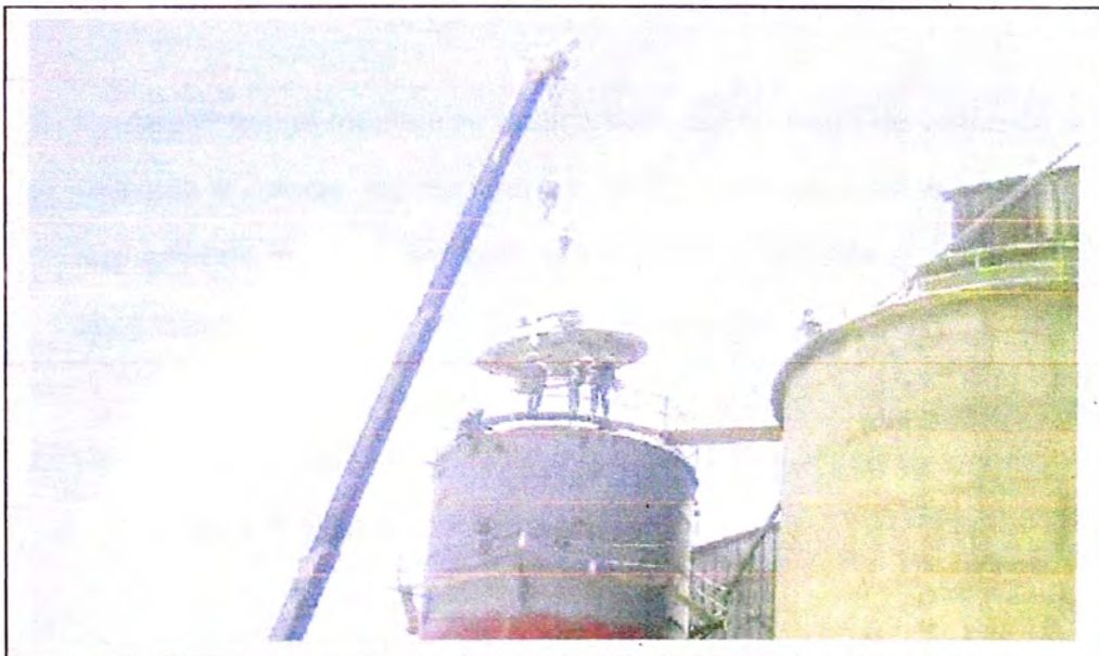
Figura 5.25: Montaje de cono elemento posición 2
