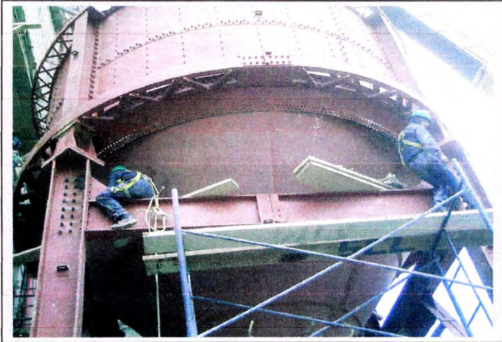
Figura 5.6: Operarios ubicados para guiar la carga y ponerlo en sus puntos de referencia
