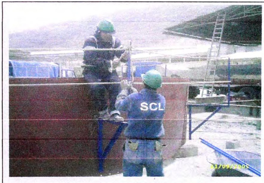
Figura 5.9: Instalación de plataforma temporal
