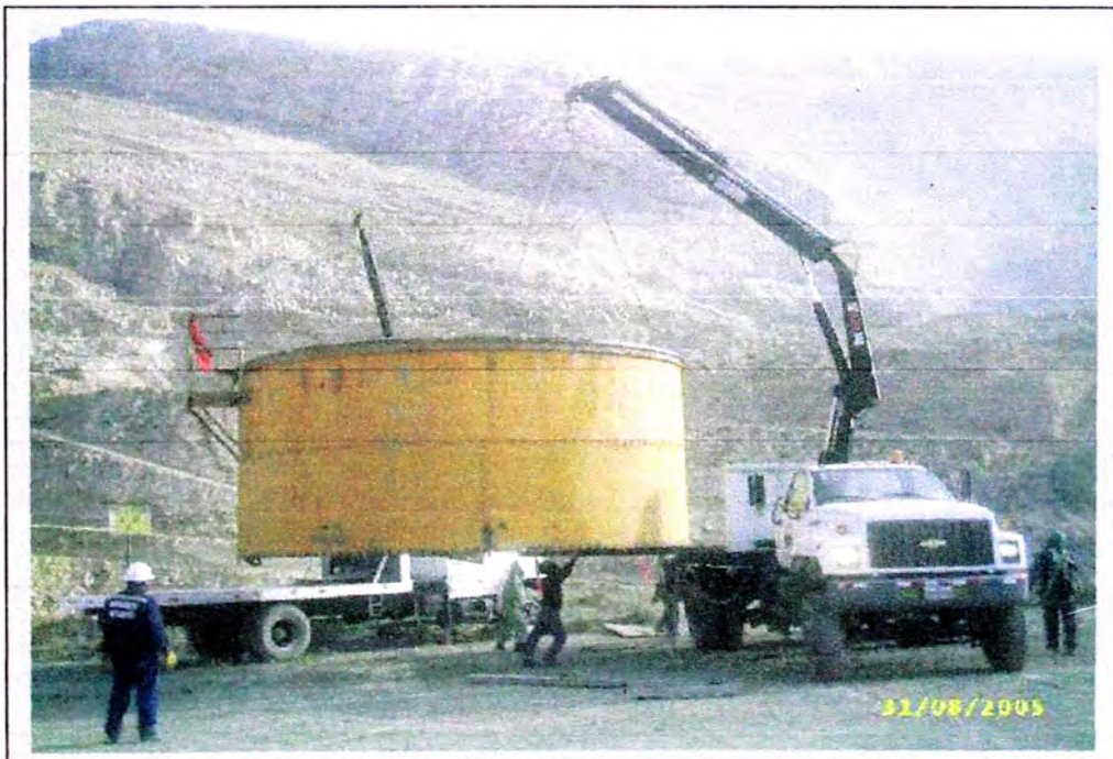
Figura 4.21: Carguio de anillo posición 4 sobre plataforma de camión hiab
