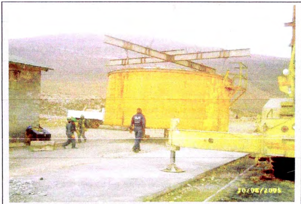
Figura 4.17: Anillo posición 4 siendo colocado en el nivel cero sobre tacos de madera
