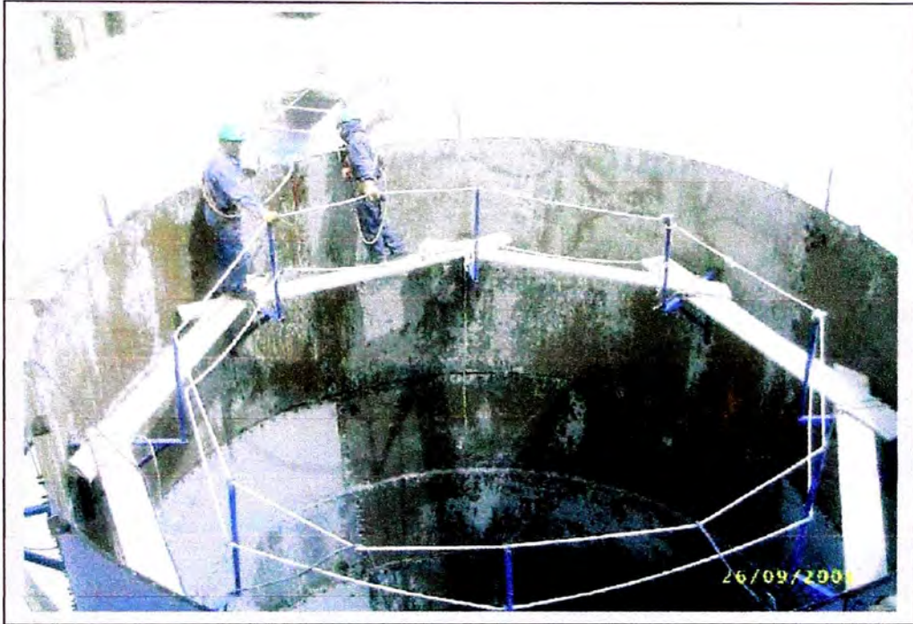
Figura 5.17: Instalación de plataforma temporal en el interior del anillo
