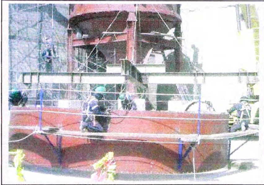
Figura 5.10: Fijación de estrobos entre el anillo y bastidor
