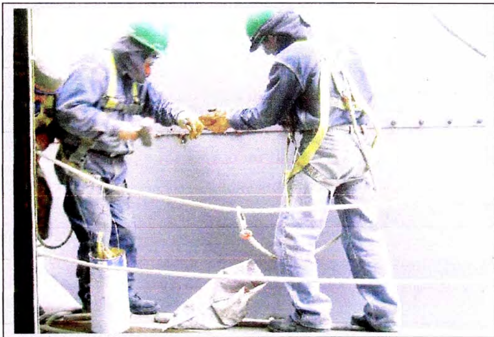
Figura 5.14: Instalación de pernos en el traslape de dos anillos
