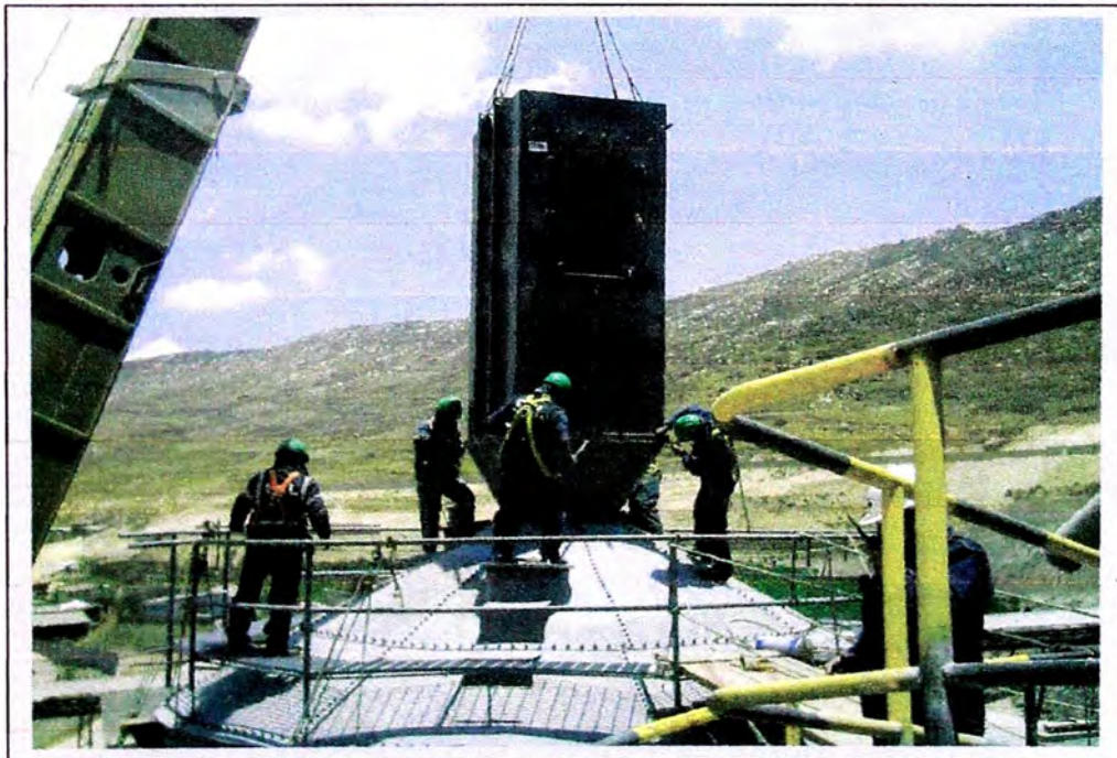
Figura 5.27: Posicionamiento y fijación de filtro
