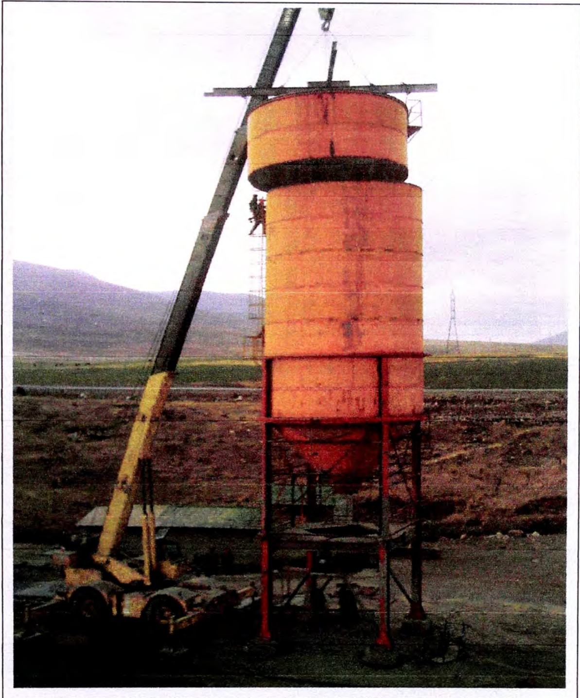
Figura 4.15: Retiro del anillo posición 4 luego de haber hecho presión con la gata de 30 ton
