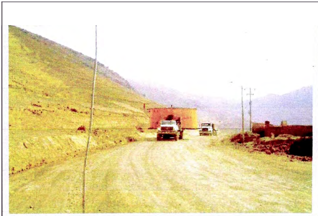
Figura 4.23: Traslado de anillo posición 4 hacia la planta
