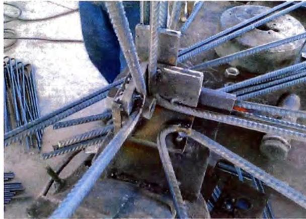
Figura N° 1.06.- Placa de unión y anclajes
