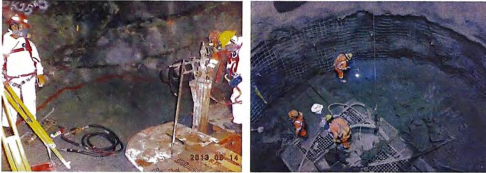
**Figura N°5.35.- Imágenes del Pique-Excavación de ensanche**
