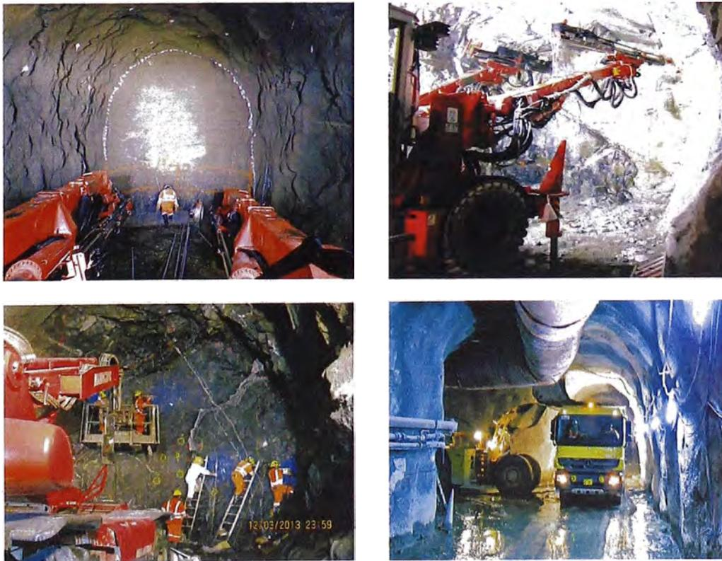
Figura N°5.29.- Imágenes del Túnel de Conducción-Excavación
