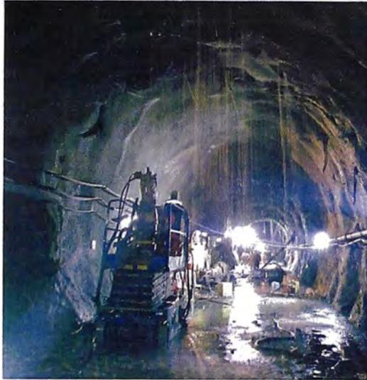
**Foto N°01: Túnel de Conducción- Zona de Filtración de Agua**
