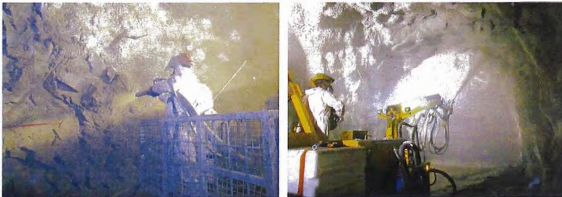
**Figura N°5.30.- Imágenes del Túnel de Conducción-Shotcrete**
