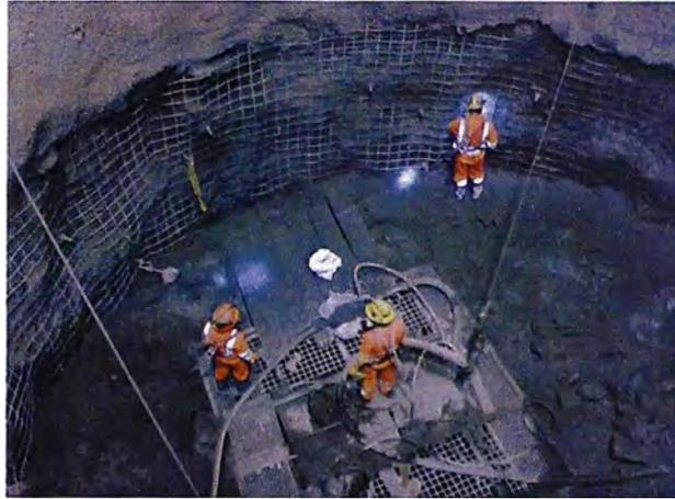
**Foto N°07: Chimenea de Equilibrio – Excavación de Ensanche**
