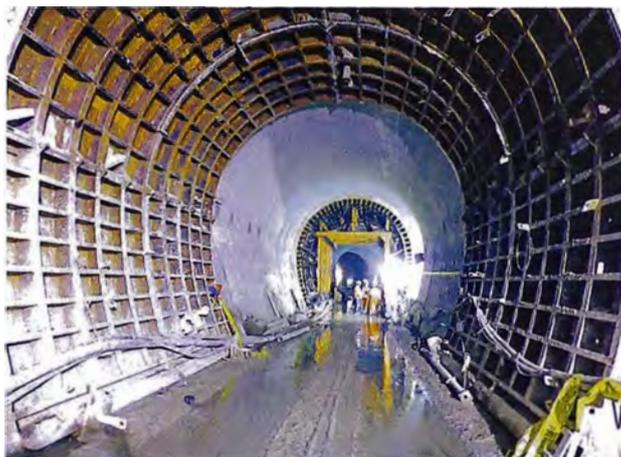
**Foto N°04: Túnel de Conducción- Zona de Revestimiento de Concreto**
