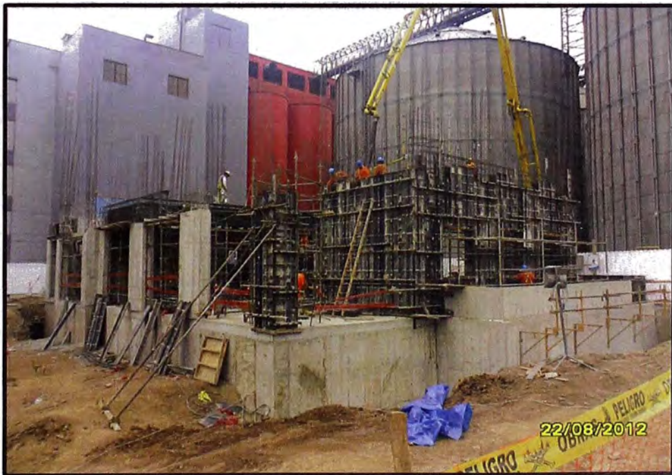
FOTO 4. VACIADO DE CONCRETO EN PLACAS Y COLUMNAS
