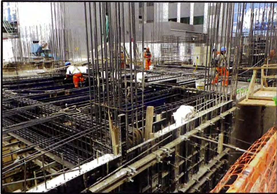
FOTO 3. ENCOFRADO DE PLACA EJE-C
