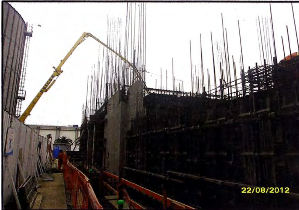
FOTO 8. ENCOFRADO DE PLACAS EN EJE C
