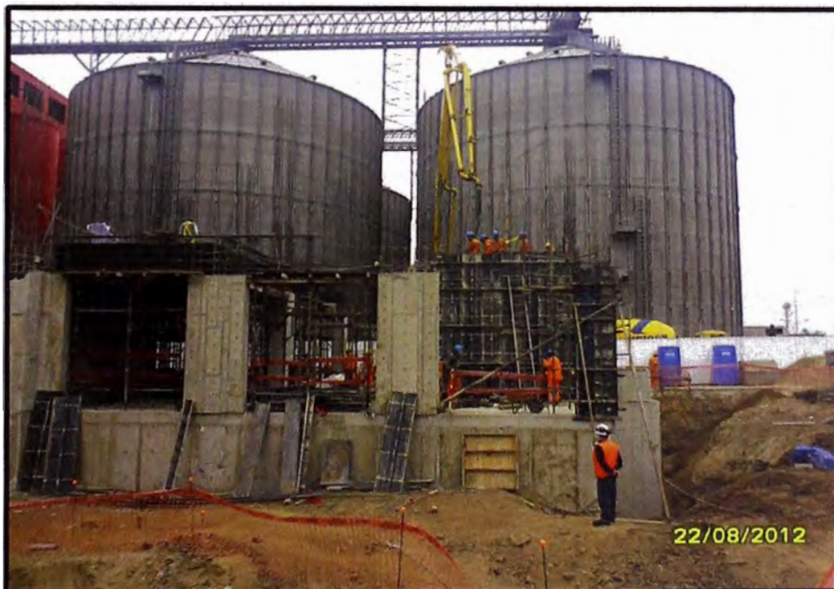
FOTO 7. VISTA LATERAL DEL VACIADO DE CONCRETO EN ELEMENTOS VERTICALES
