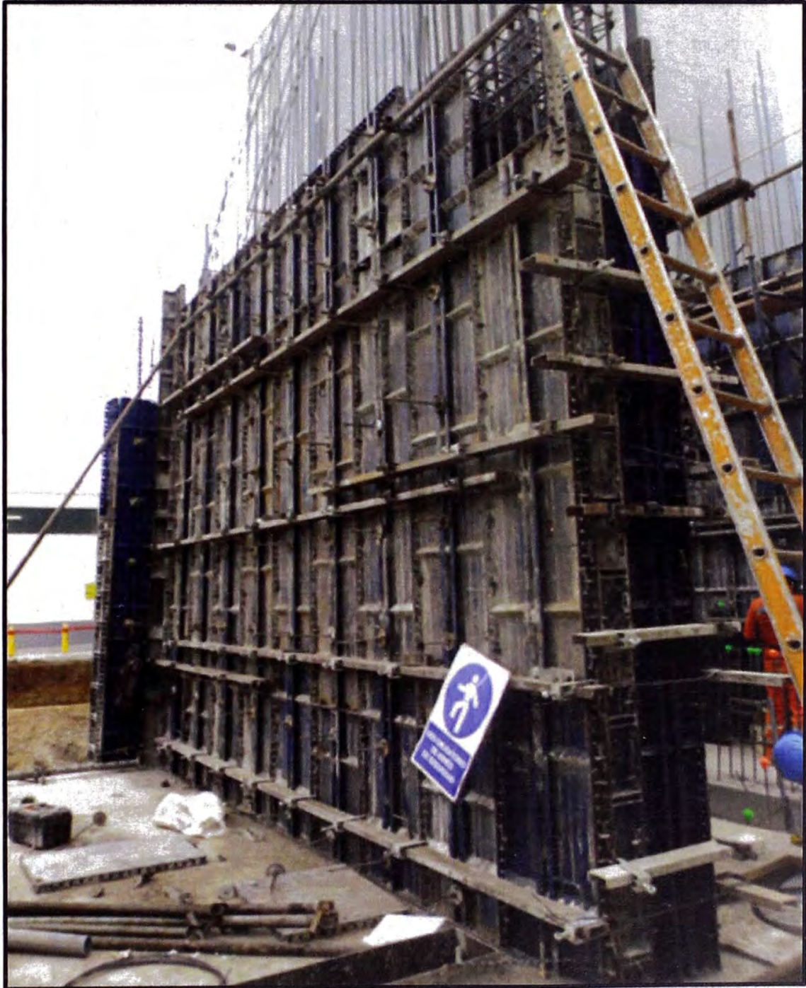
FOTO 2. ENCOFRADO DE PLACA EJE 8
