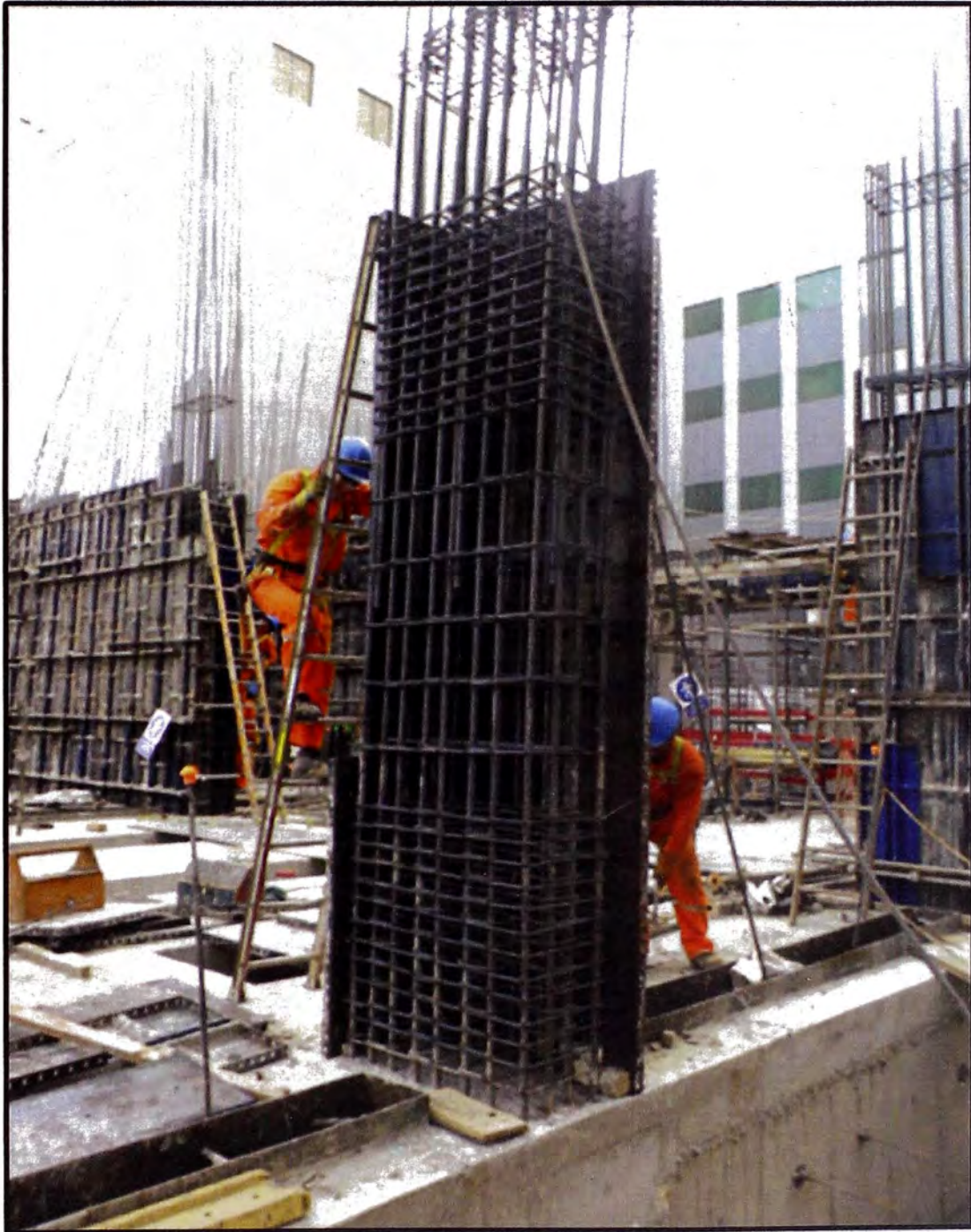
FOTO 1. ENCOFRADO DE COLUMNA EJES 9-C
