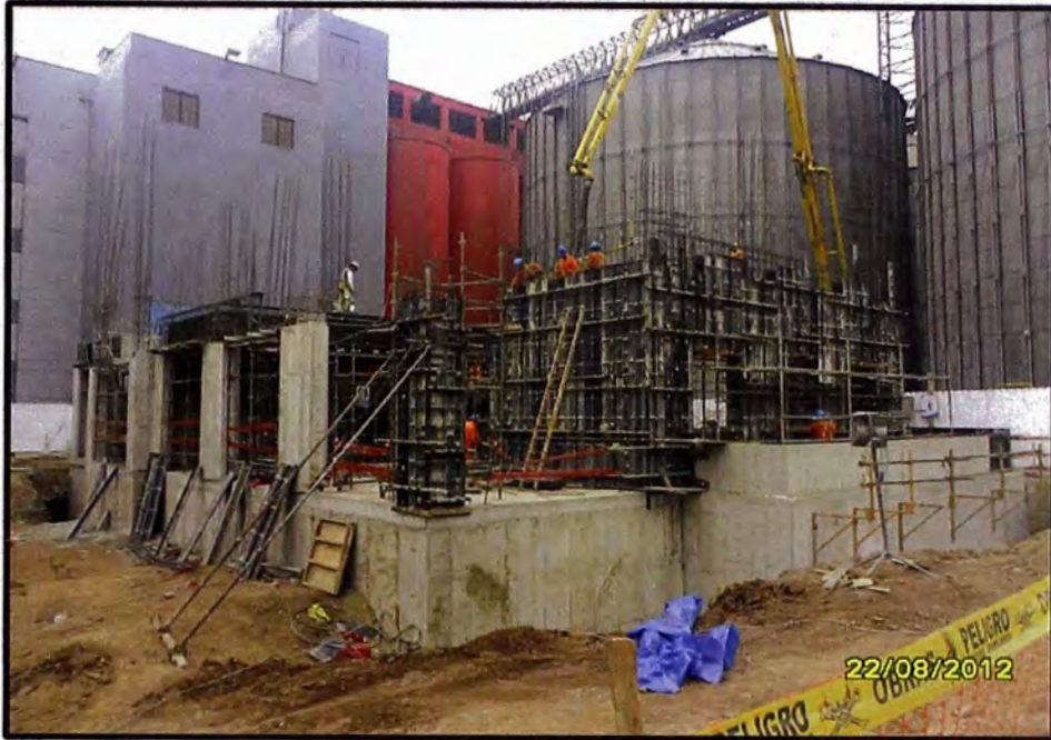
FOTO 6. VACIADO DE CONCRETO EN PLACAS
