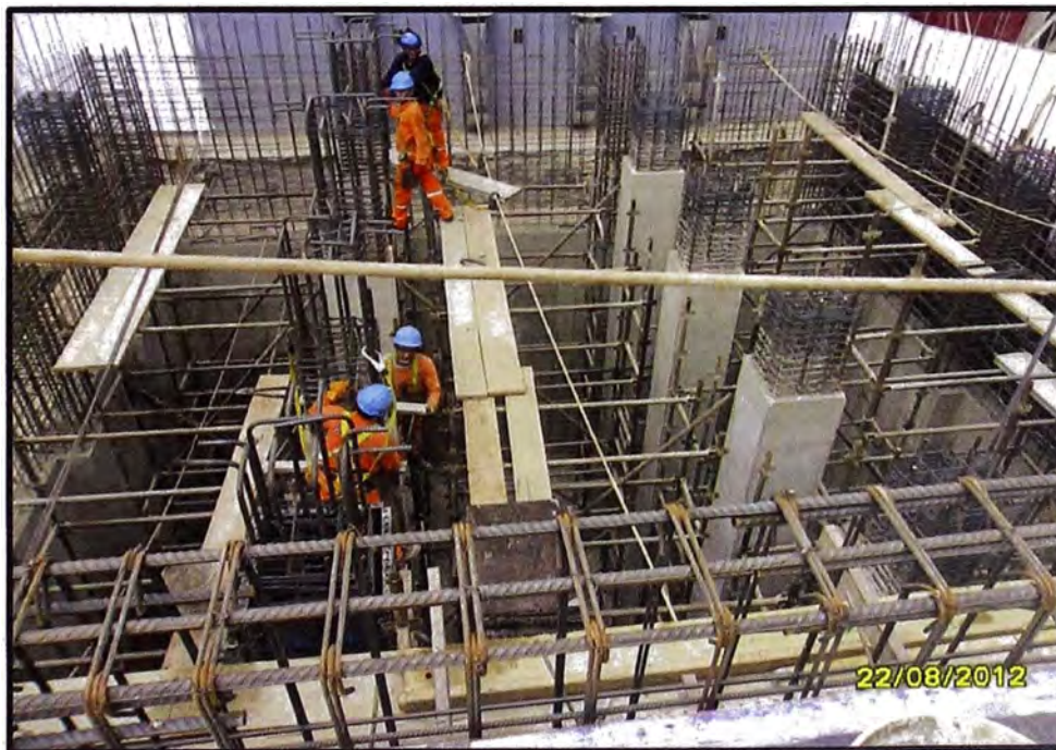
FOTO 9. HABILITACIÓN DEL ACERO EN ZONA DE SILOS
