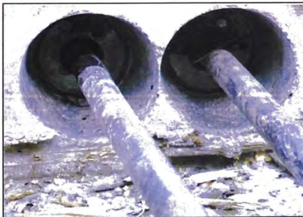
Figura N°18.- Eliminación del encofrado y del tapón de plástico.
