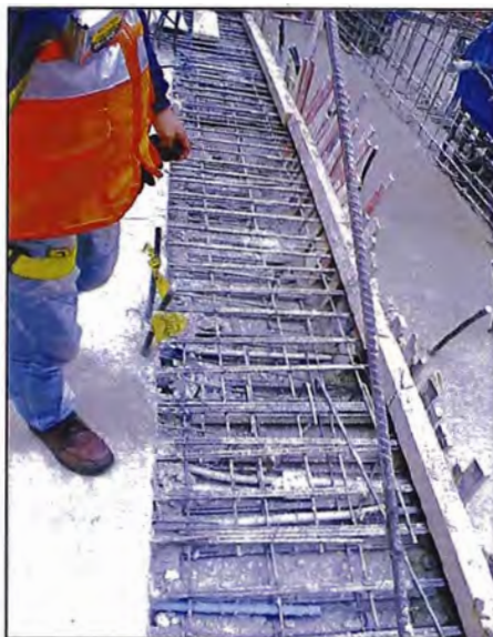
Figura N°14.- Vista de una junta de vaciado
