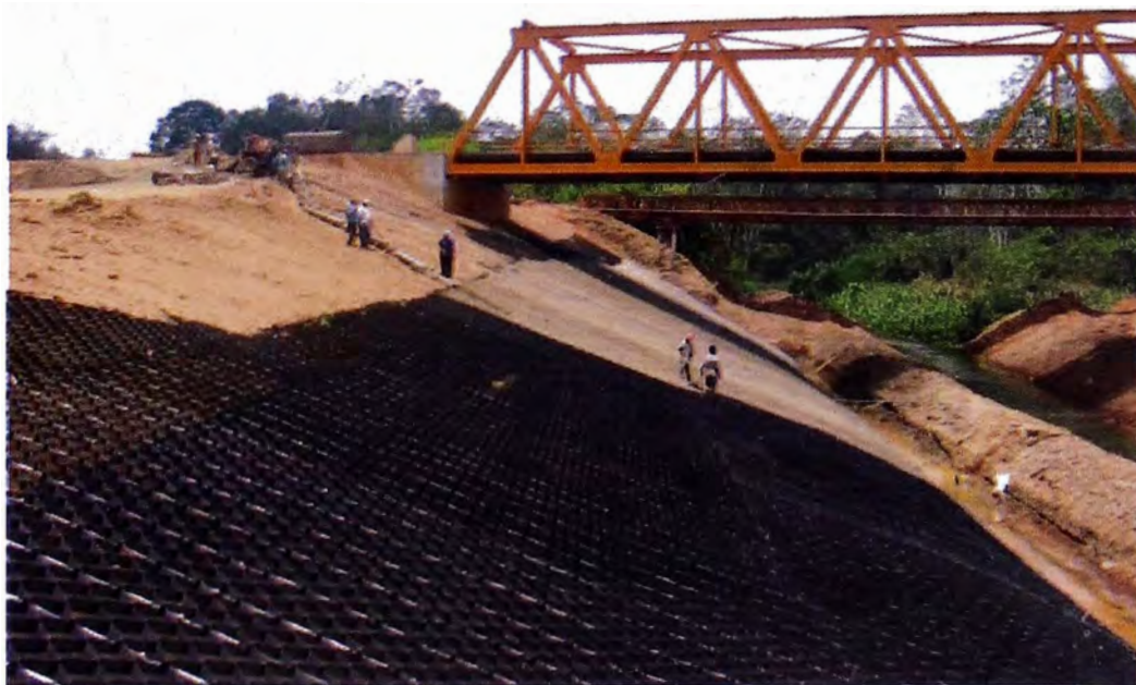
Figura N° 64. Instalación del Sistema Geoweb (Margen Izquierdo).
