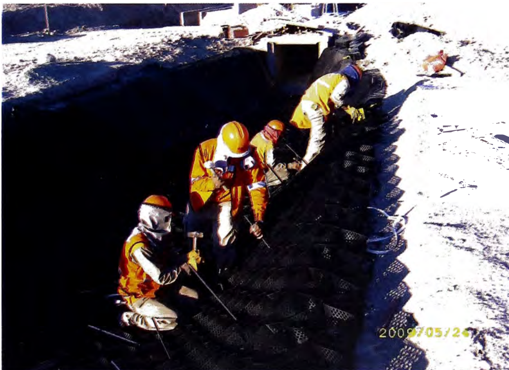
Figura N° 46. Anclaje del Sistema Geoweb a las Paredes del Canal.
