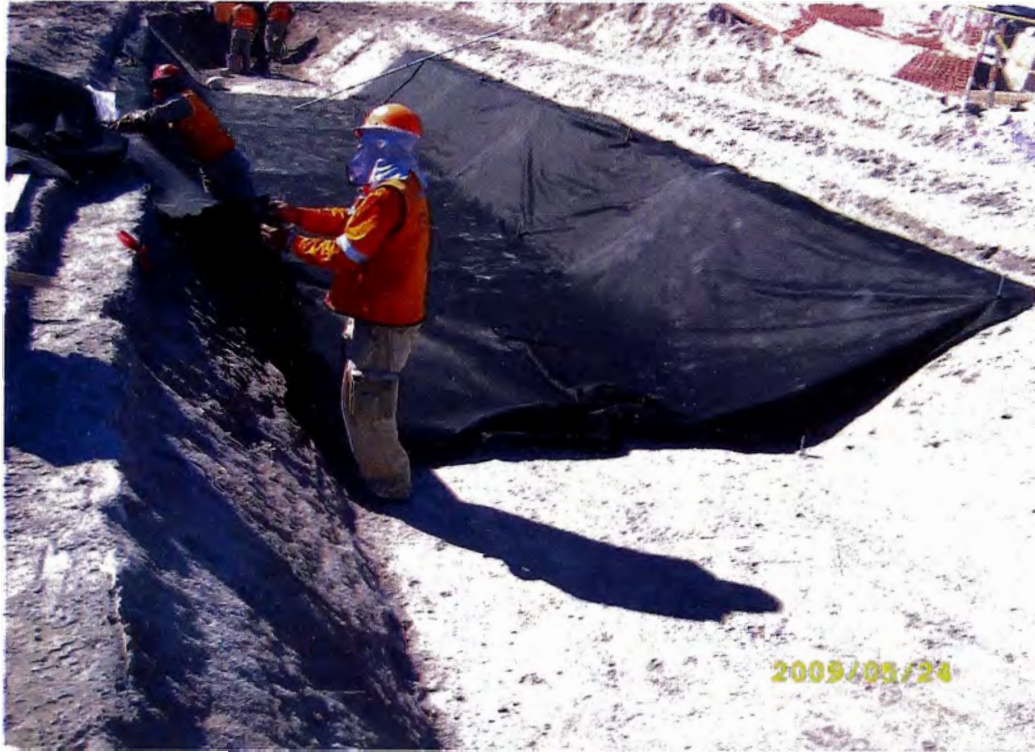
Figura N° 43. Instalación del Geotextil No Tejido.
