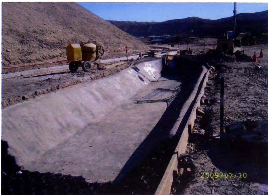
Figura N° 48. Fraguado del Concreto en la Losa Flexible.
