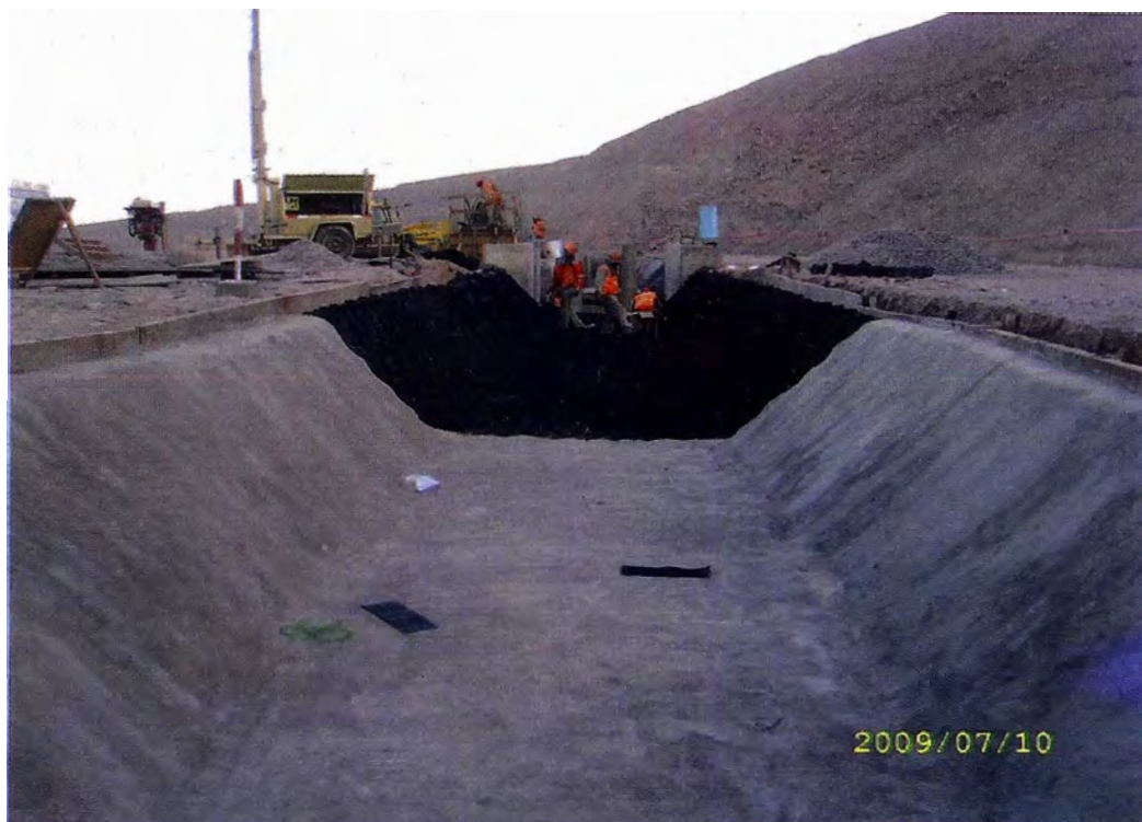
Figura N° 49. Vista Sistema Geoweb Instalado.
