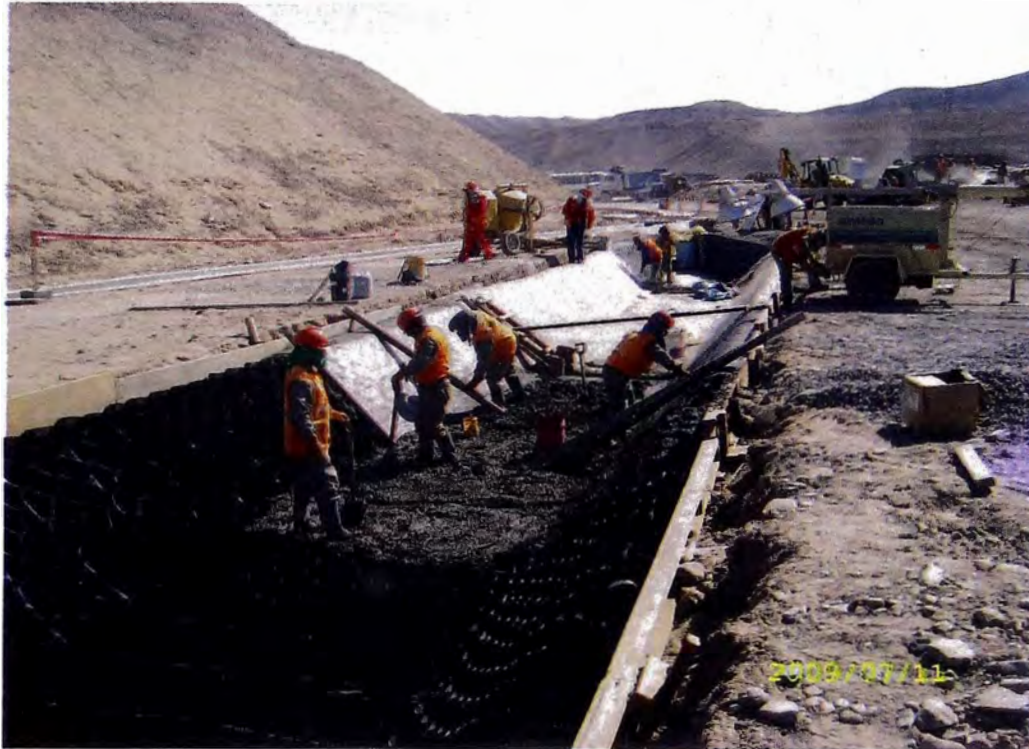
Figura N° 47. Vaciado del Concreto.
