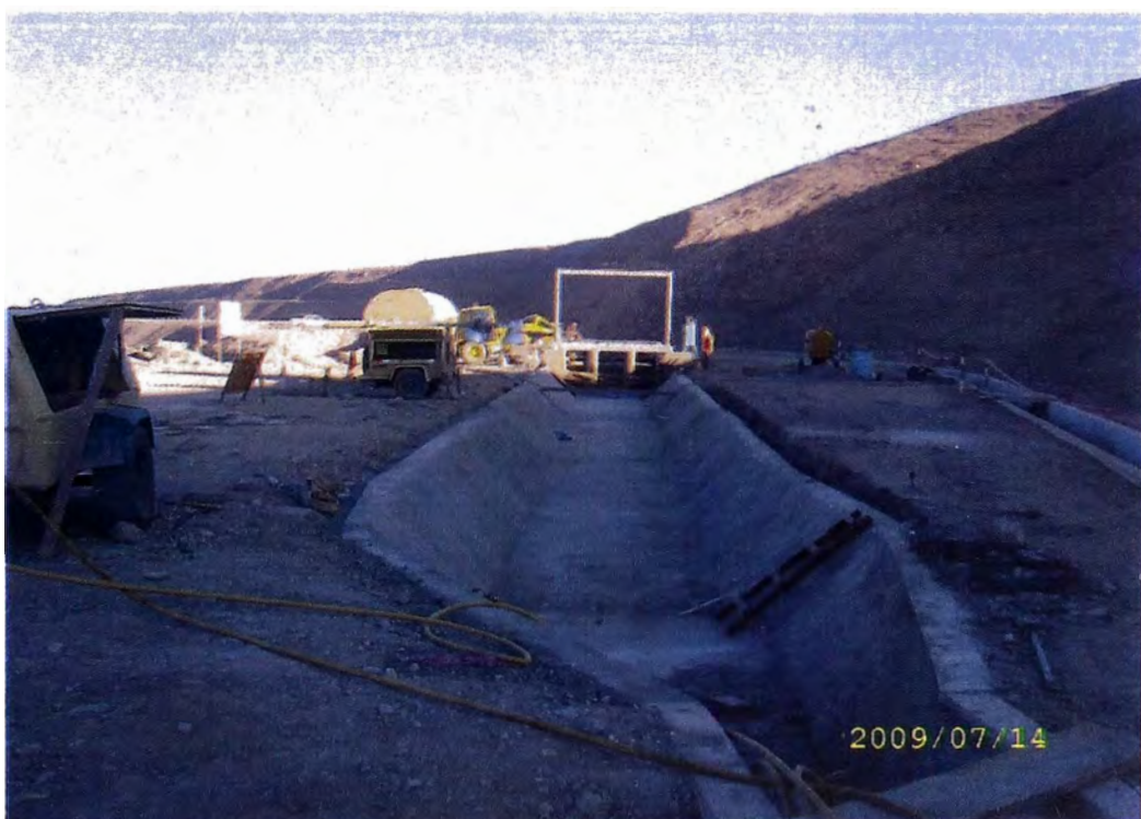
Figura N° 50. Canal Losa Flexible (Sistema Geoweb) Terminado 1.
