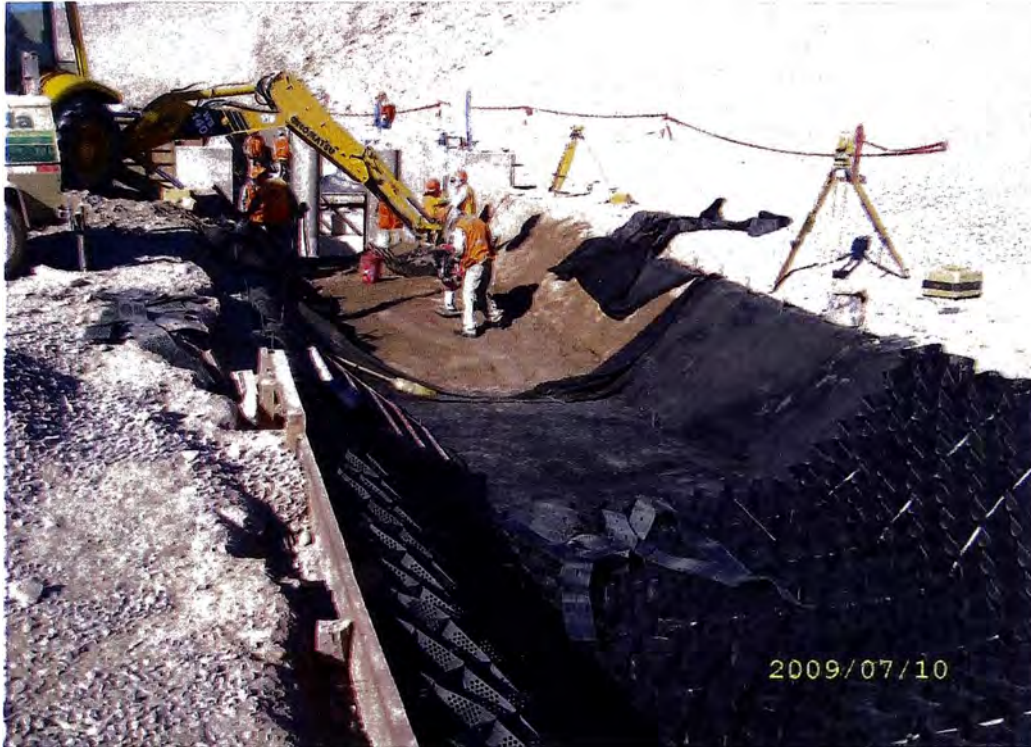
Figura N° 45. Perfilado de las Paredes del Canal
