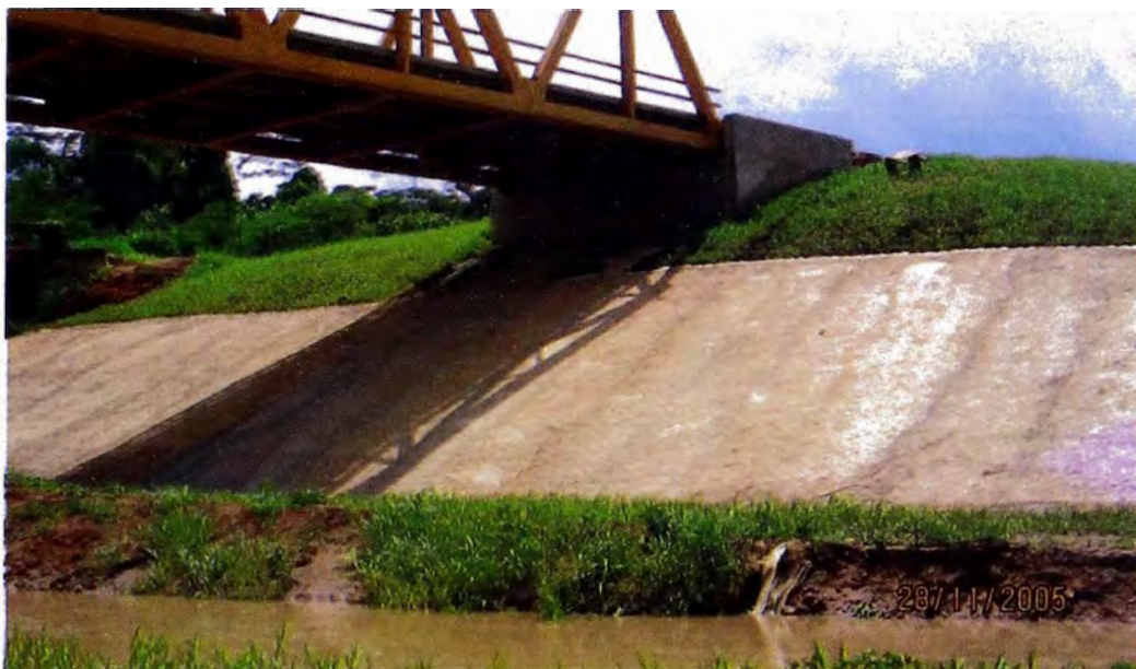
Figura N° 65. Suelo Cemento hasta el Tirante de Agua máximo.
