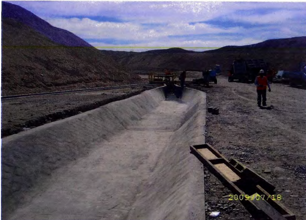
Figura N° 51. Canal Losa Flexible (Sistema Geoweb) Terminado 2.
