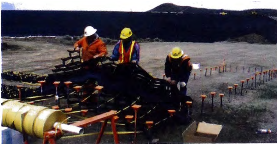
Figura N° 10. Instalación de los Tendones
