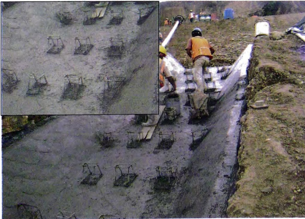
Figura N° 56. Instalación de los Dados Disipadores de Energía.
