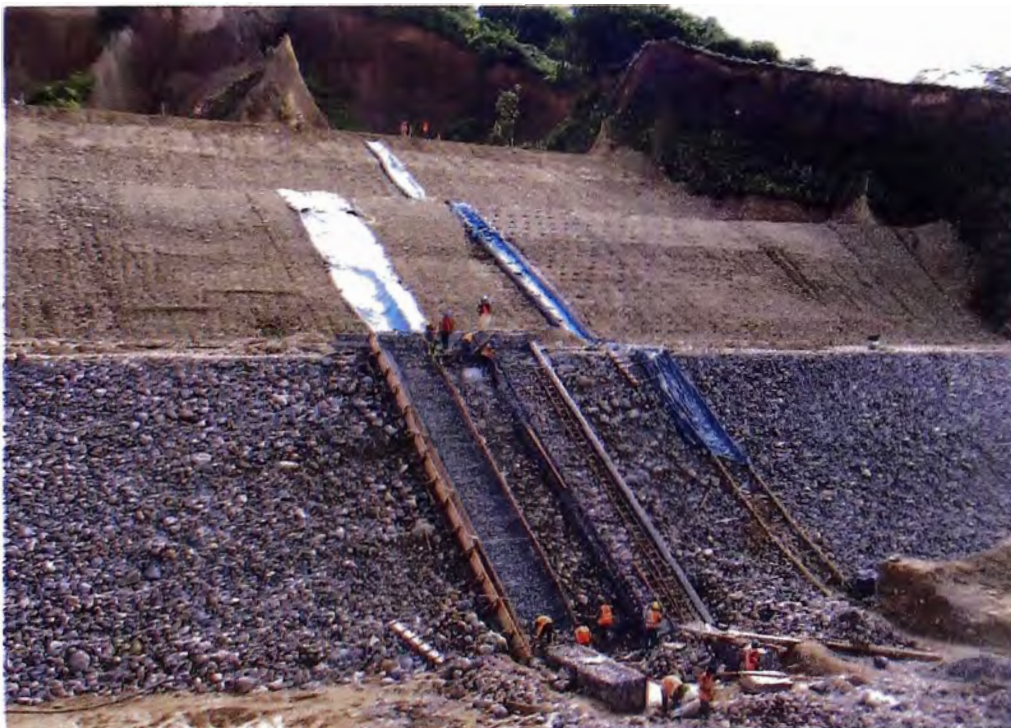
Figura N° 54. Perfilado del Canal - Rápida.
