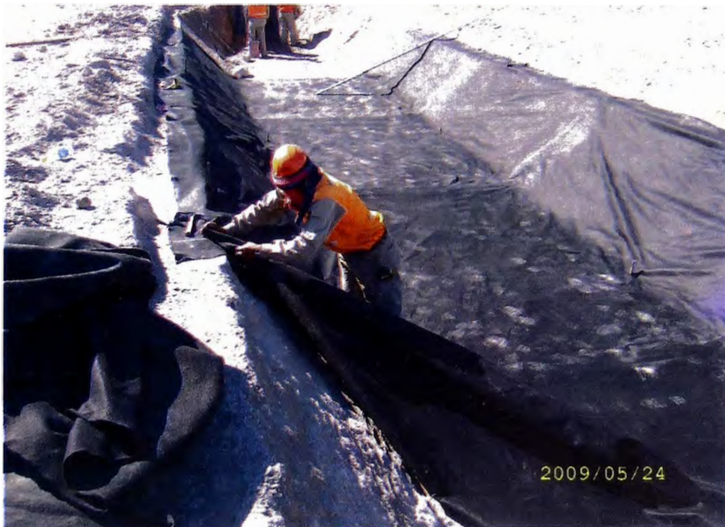
Figura N° 44. Traslape del Geotextil No Tejido.
