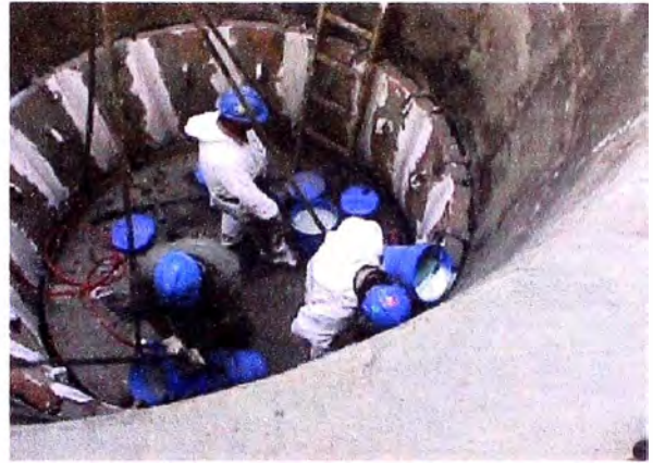
INSTALACION DE CONCAVOS
