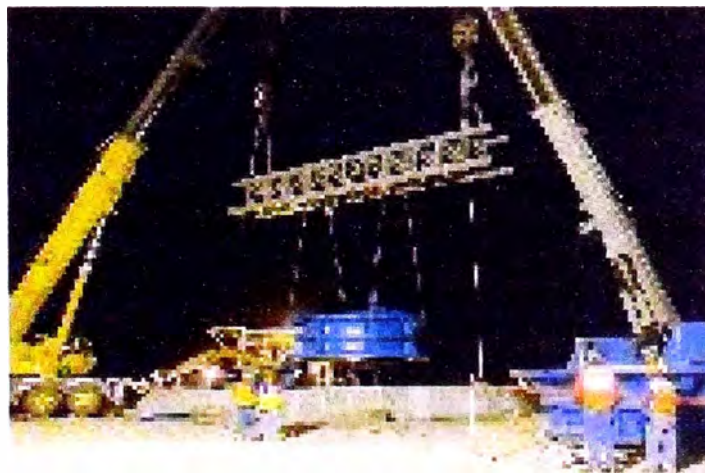
Figura No. 3-3: Maniobra de montaje de cuerpo inferior bottom shell
