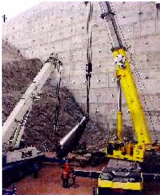
Figura No. 3-2: Maniobra de izaje de eje main shaft con 2 grúas de 200 ton.
