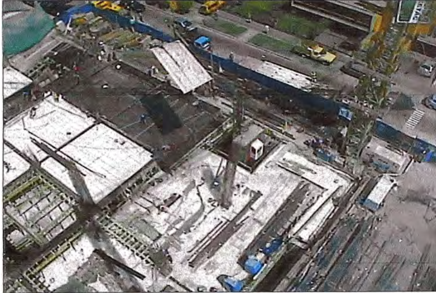
FIGURA N°30 Monitoreo de uso de Torre Grúa #1
