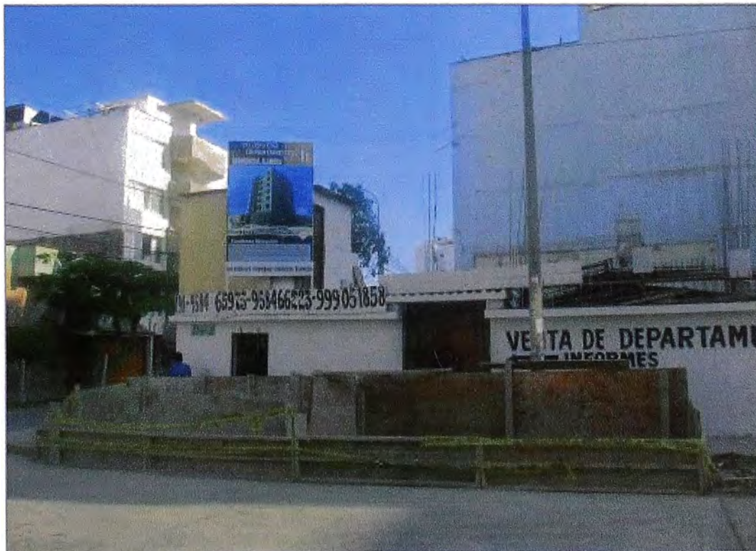
Figura 2.4: Vista de la obra
