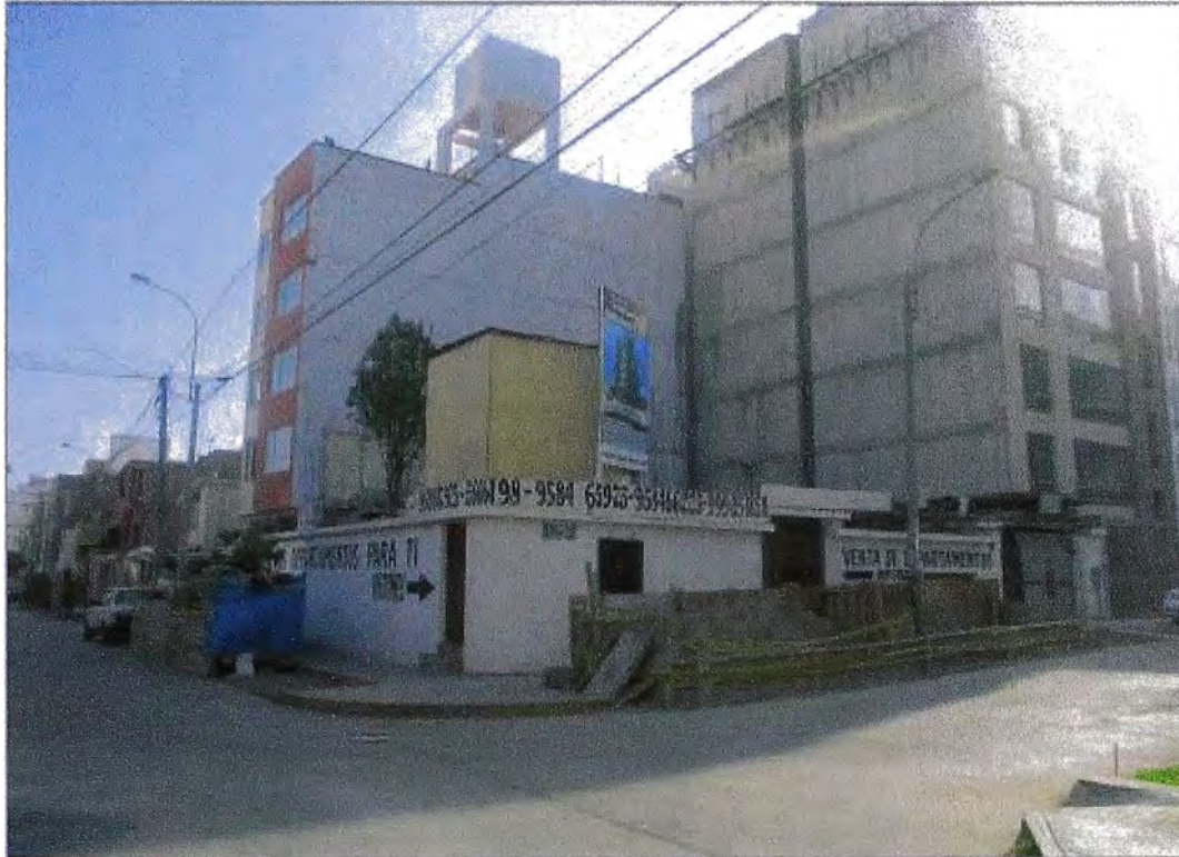
Figura 2.3: Vista exterior de la obra
