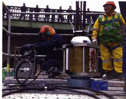
Figura 3.10: Celda de carga y gata hidráulica.
