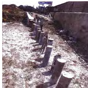
Figura 1.2: Micropilote con acero corrugado. Figura 1.3: Micropilote con tubería de acero.
