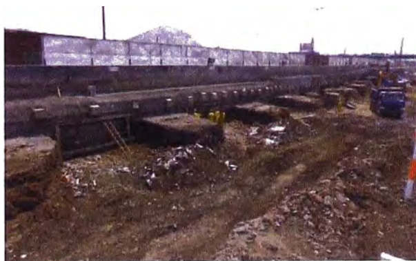
Figura 4.1: Vista general del tramo objeto de análisis.
