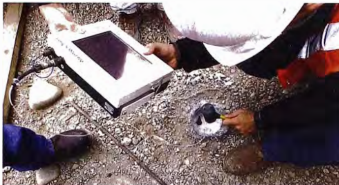
Figura 3.12: Toma de ensayo en Micropilote.
