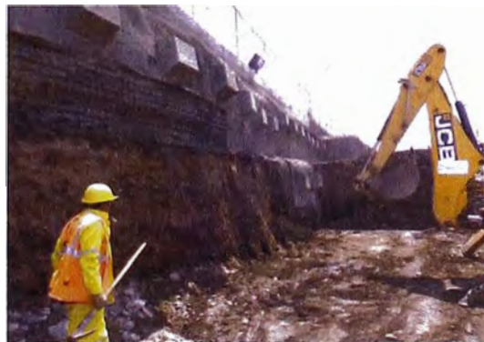
Figura 4.2: Detalle de la excavación con presencia de rellenos, con un espesor estimado alrededor de 6m. En la base de la excavación, aparecen las primeras capas de depósitos aluviales.
