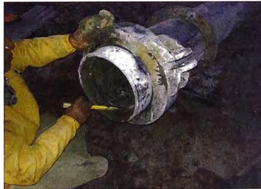
Figura 3.8: Zapata soldada a tubo
