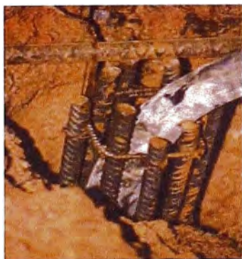
Figura 1.2: Micropilote con acero corrugado. Figura 1.3: Micropilote con tubería de acero.
