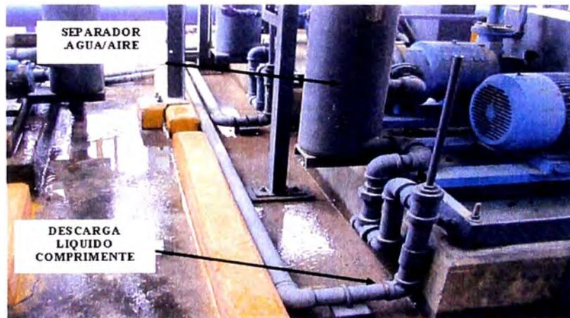
Figura 4.19 - Descarga del líquido comprimente (agua).
