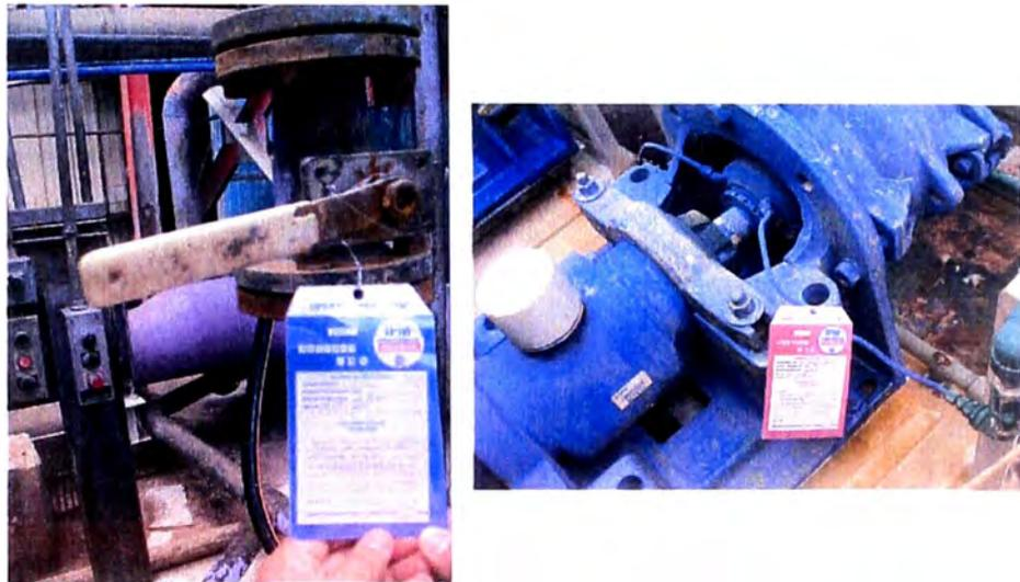
Figura 2.25 - Ejemplo de reporte de anomalías en equipos con tarjetas.
