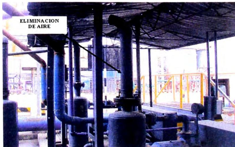
Figura 4.20 - Tubo de separación del aire (oxígeno) y líquido comprimente (agua).
