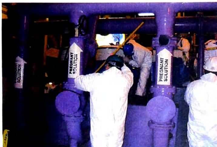
Figura 5.8 - Limpieza a las bombas de precipitado en Merrill Crowe.
