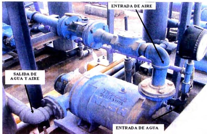
Figura 4.18 - Entrada de líquido comprimente (agua) y el aire (oxígeno).
