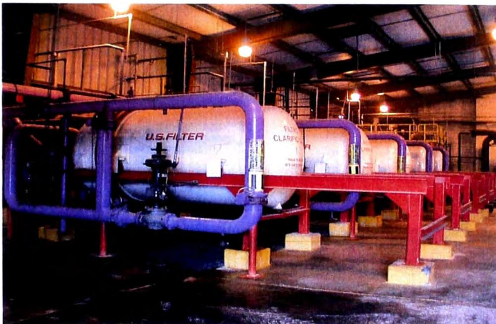
Figura 4.3 - Filtros clarificadores U.S. Filter, usados en Merrill Crowe de Minera Yanacocha.
