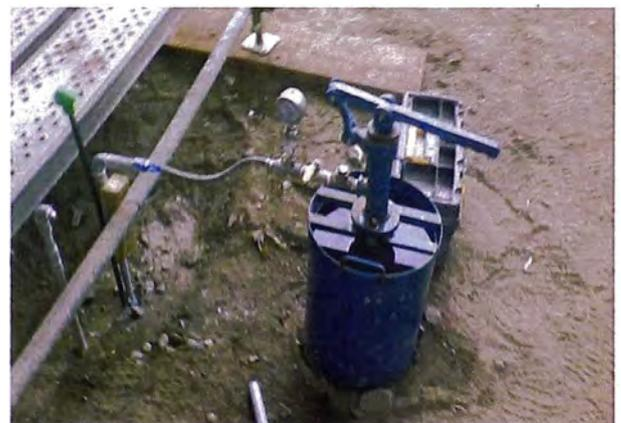
Vista: Control de concreto fresco (izquierda), Prueba de presión en sistema de agua (derecha).
