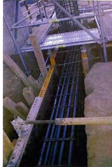
Vista: procesos de instalación tuberías para sistema eléctrico (banco de ductos).
