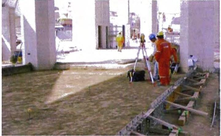
Vista: Trabajo topográficos de trazo y replanteo.
