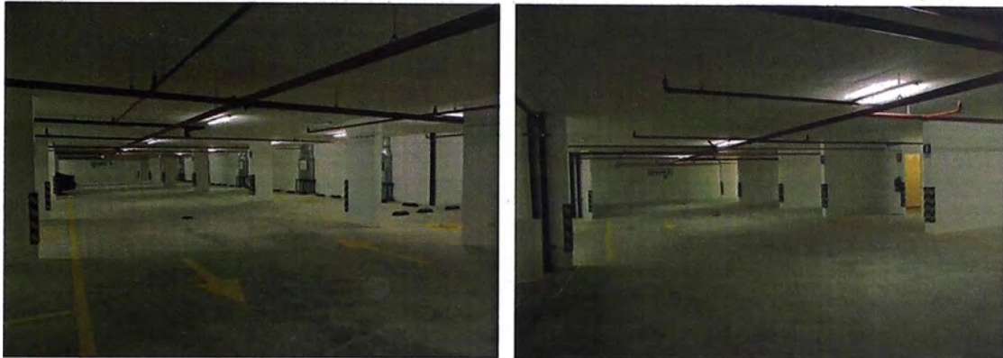
Figura N°2.7.- Imágenes de los sótanos terminados
