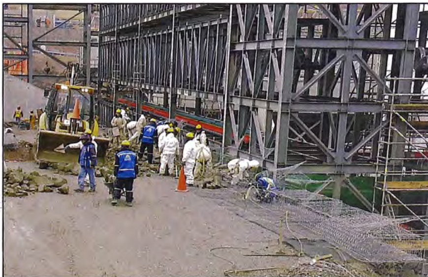
Figura 3.6 colocación de cajas
