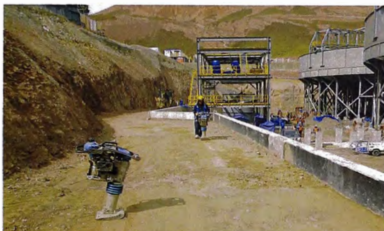
Figura 3.2: Compactación de terreno de fundación con Vibropisonador
