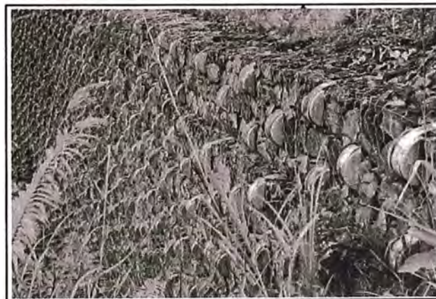
Figura 1.2 Suelo Reforzado en Sabah Malasia en 1979
