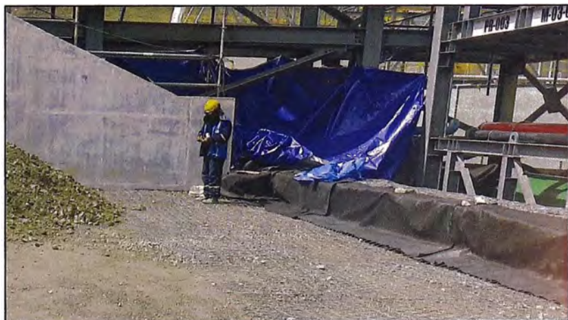
Figura 3.9 Instalación de Geotextil
