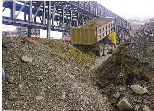
Figura 2.8 Agregado de relleno
