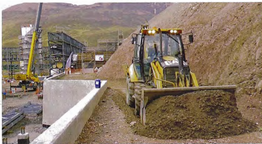
Figura 3.1: Nivelación de terreno de fundación
