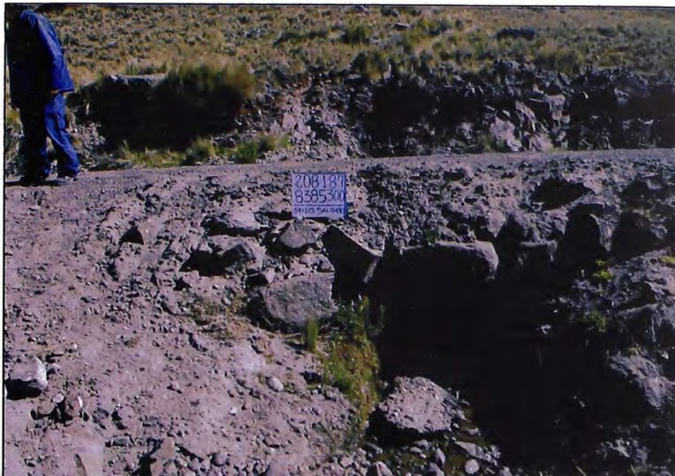
Anexo F-3.- Alcantarilla tipo tajea existente del tramo en estudio Fuente: Elaboración Propia
