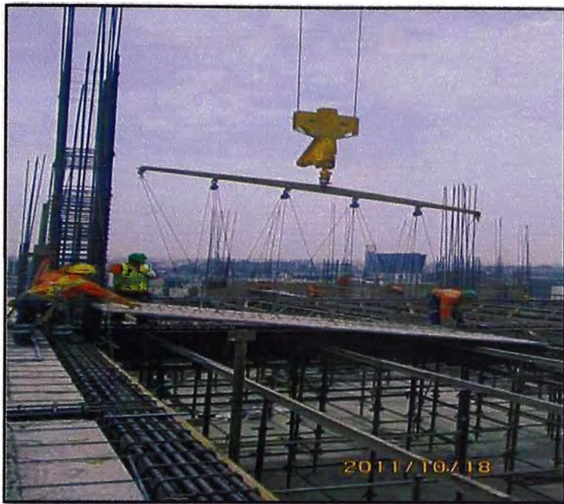
Figura 3.26: Colocación de la prelosa en forma inclinada, colocando primero el lado con las mechas sin doblar.
