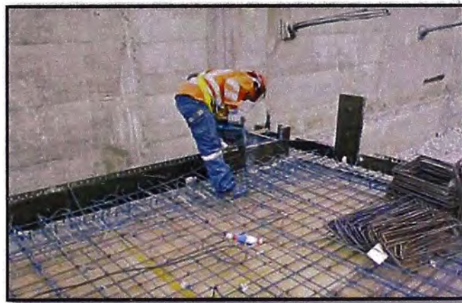
Figura 4.1: Encofrado de fondo de losa sistema convencional (planchas de fenólico).
