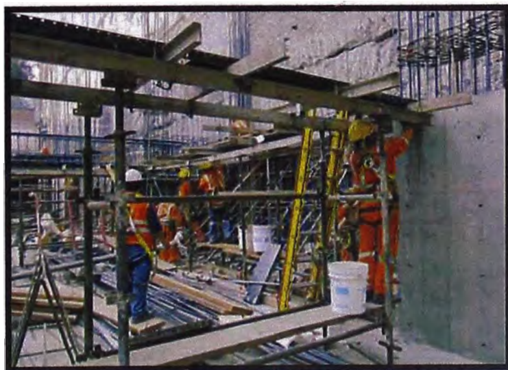
Figura 3.21: Colocación de Fondo de Vigas.
