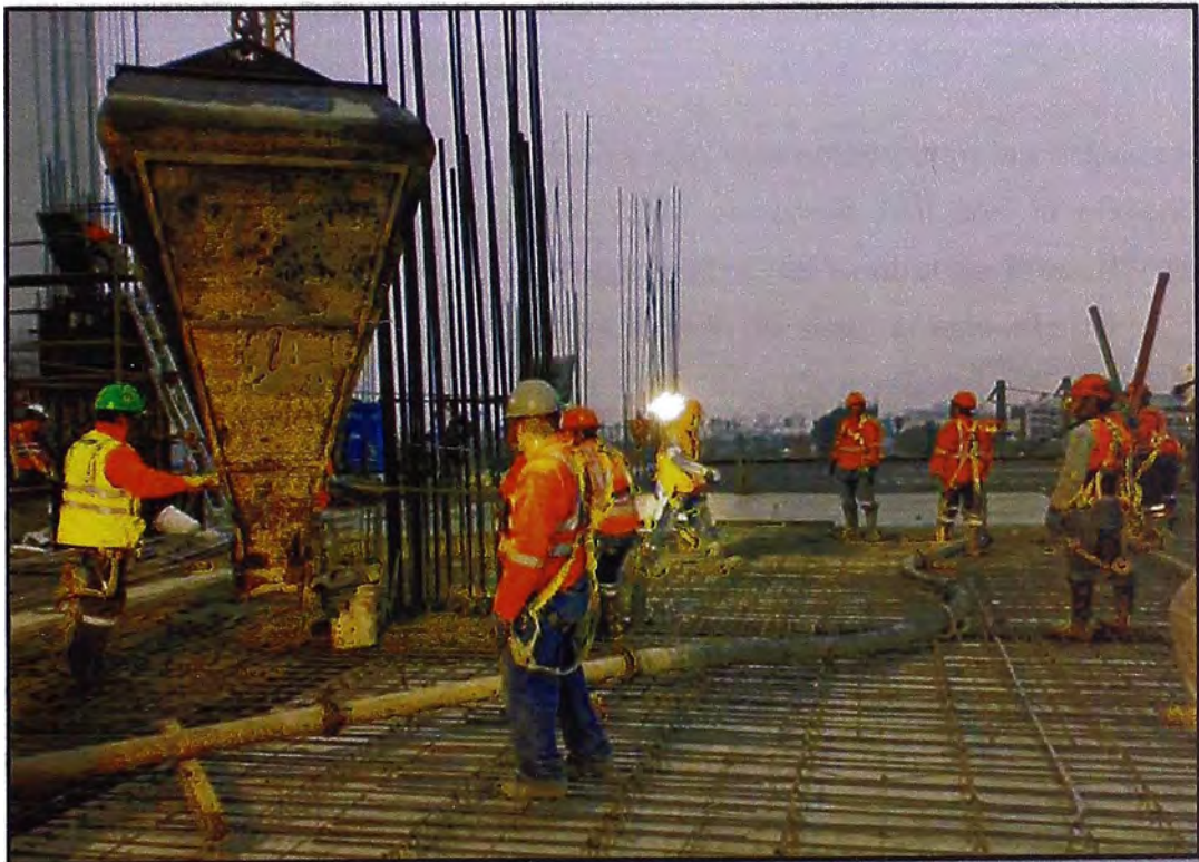
Figura 3.30: Concreto de Horizontales (núcleos, vigas y losas).
