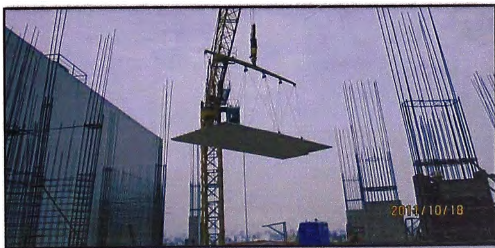
Figura 3.25: Traslado de la prelosa.
