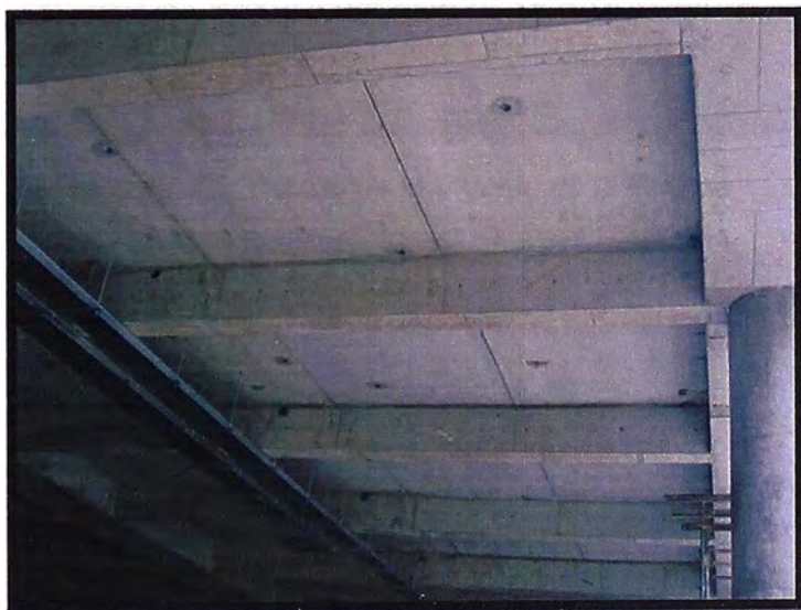
Figura 2.2: Acabado de la parte Inferior de la Prelosa
