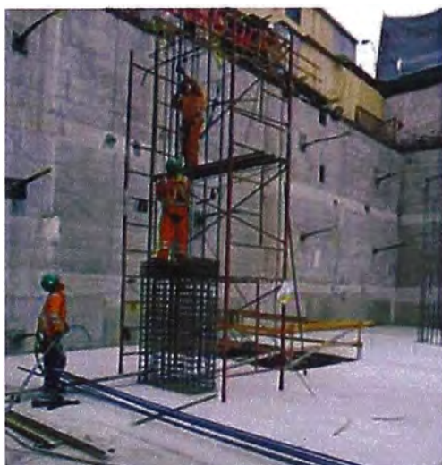
Figura 3.19: Acero de Verticales.
