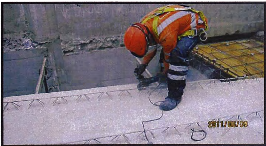
Figura 3.11: Corte de Prelosas que no contaba con destaje.
