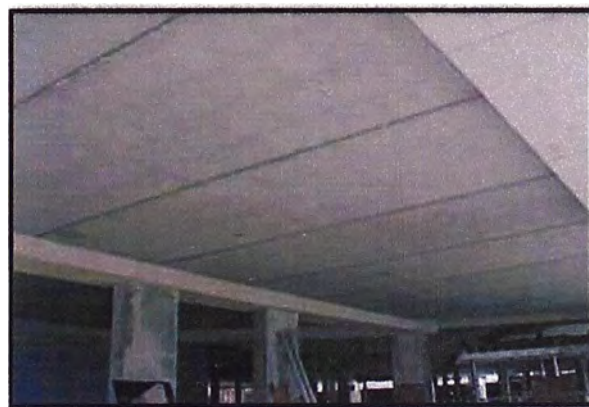
Figura 4.7: Acabado cara vista en techo de la prelosa.
