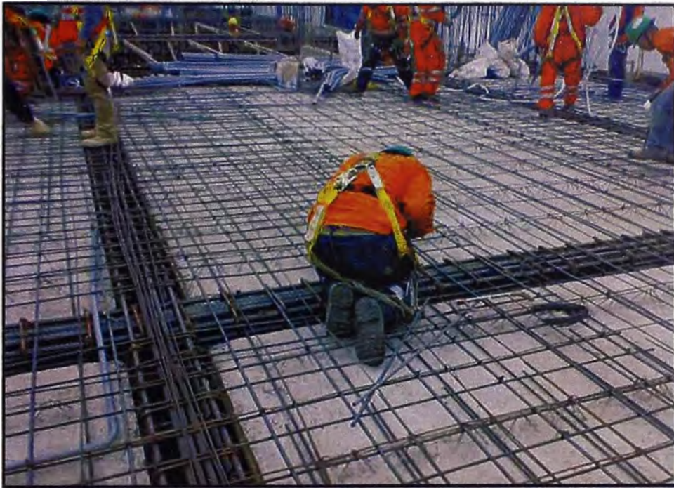
Figura 3.28: Colocación de Acero de Horizontales.
