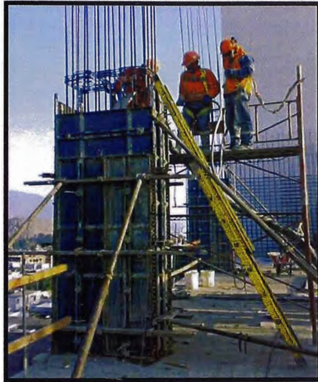
Figura 3.20: Encofrado y Vaciado de Verticales.
