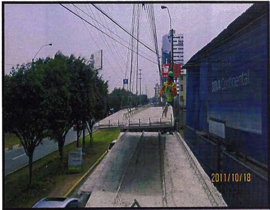
Figura 3.17: Revisión del enganche de la prelosa.
