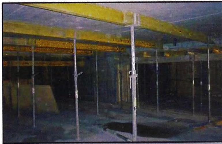
Figura 4.4: Encofrado de fondo de losa sistema prelosas.
