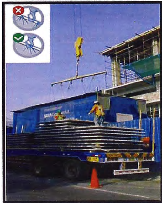
Figura 3.16: Colocación de Ganchos en los tralichos para el izaje.
