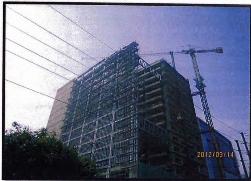
Figura 1.4: imagen de la estructura metálica del edificio Link Tower.
