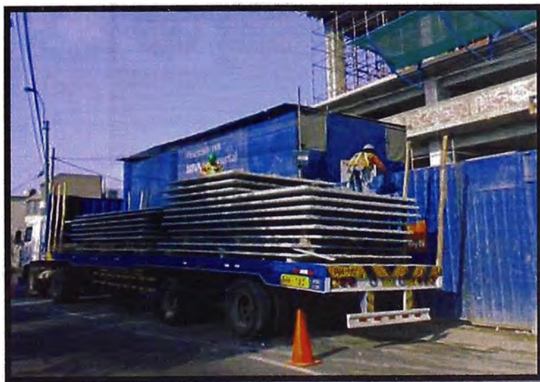
Figura 3.14: Verificación del orden correcto de las prelosas.
