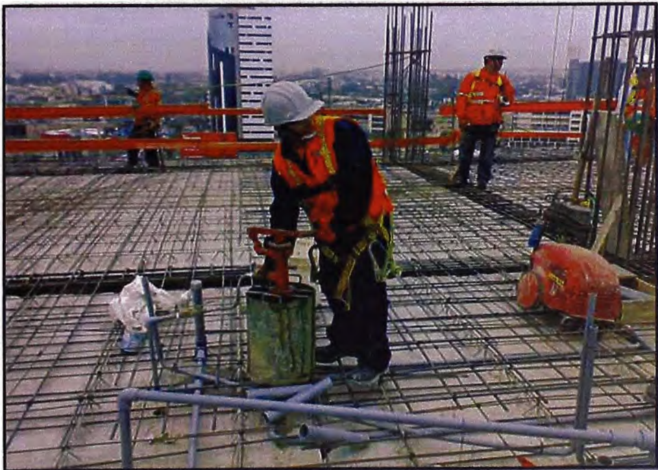
Figura 3.29: Colocación y pruebas de instalaciones Eléctricas y Sanitarias.
