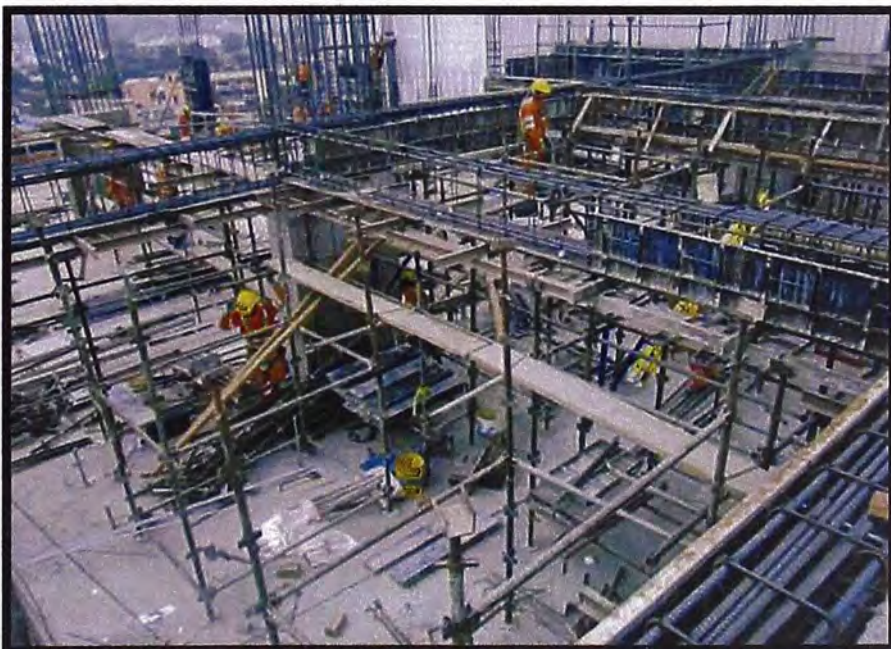
Figura 3.23: Colocación de Acero de Vigas.
