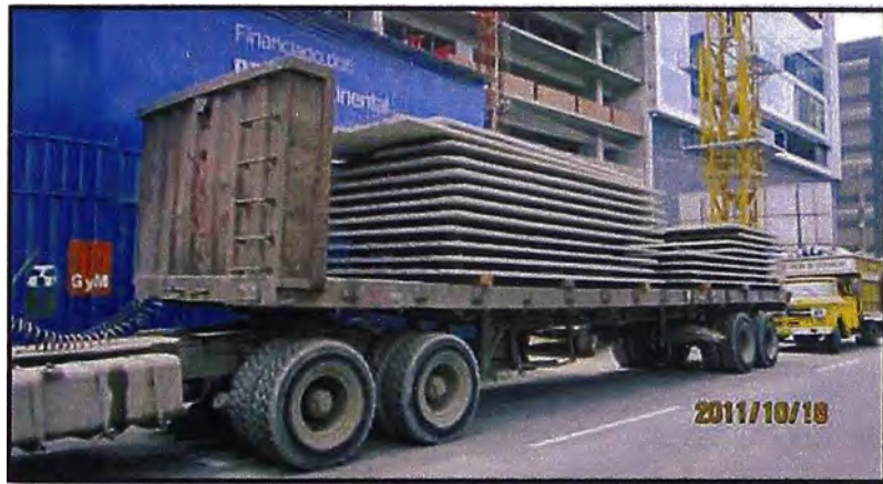
Figura 4.8: Almacenamiento ordenado en camión de prelasas.
