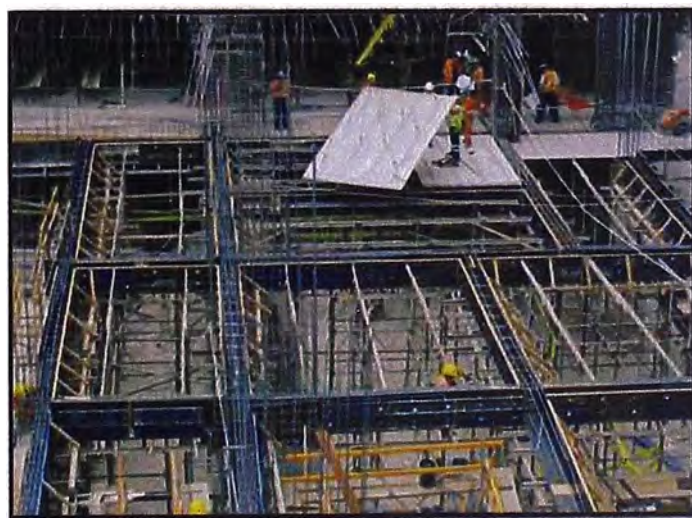
Figura 4.2: Encofrado de fondo de losa sistema prelasas.
