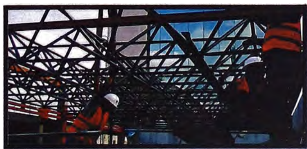
Figura 2.1: Estructura de una Tridilosa.
