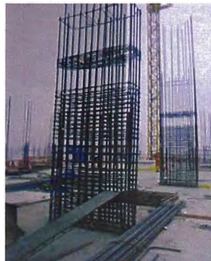
Figura 3.19: Acero de Verticales.
