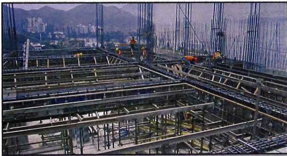
Figura 3.24: Apuntalamiento de prelosas.
