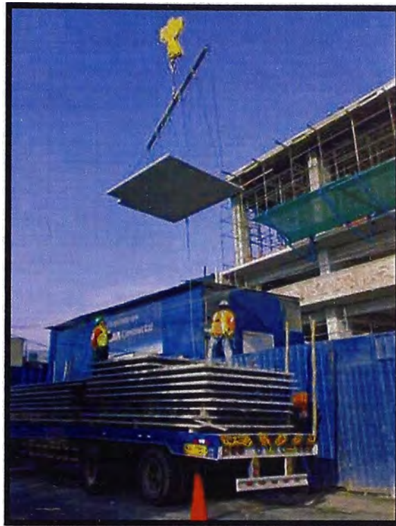
Figura 3.18: Izaje de la prelosa.
