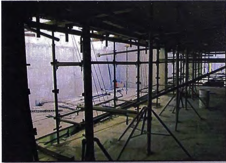
Figura 4.3: Encofrado de fondo de losa sistema convencional.
