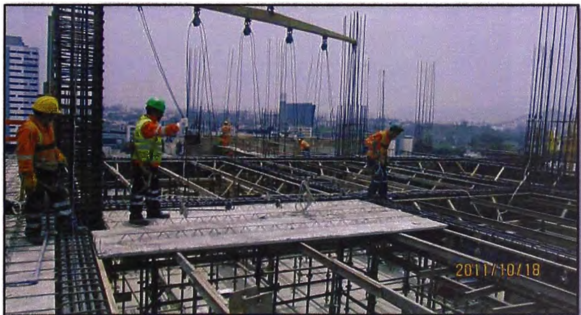
Figura 3.27: Prelosa colocada.
