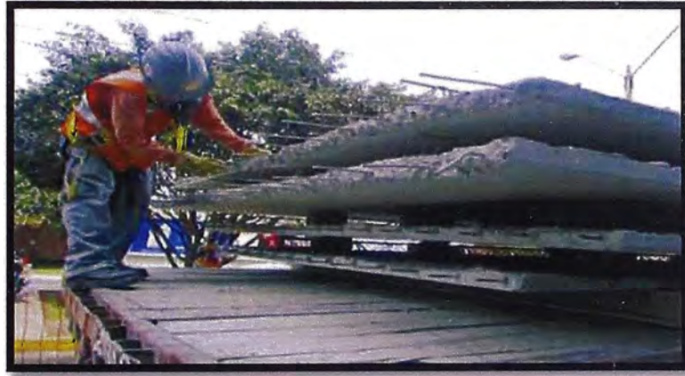
Figura 3.15: Doblado de las mechas de las prelosas.
