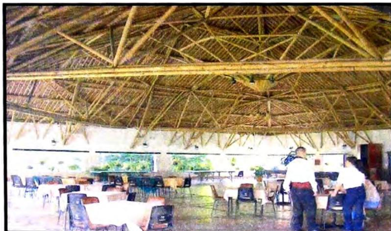
Figura N° 1.14 Vista de la estructura de la cubierta en guadua
