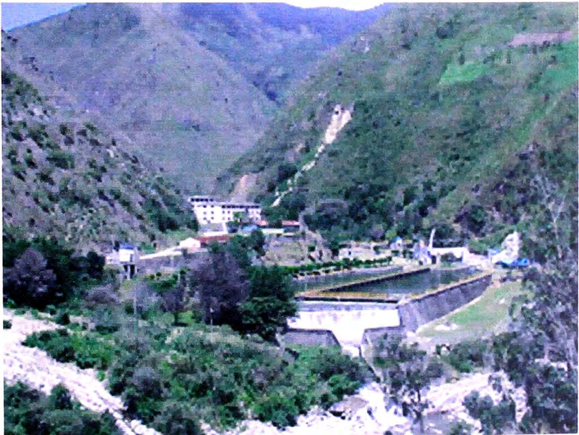
Figura 2.5 (Desarenador de la Central Hidroeléctrica – Yaupi)
