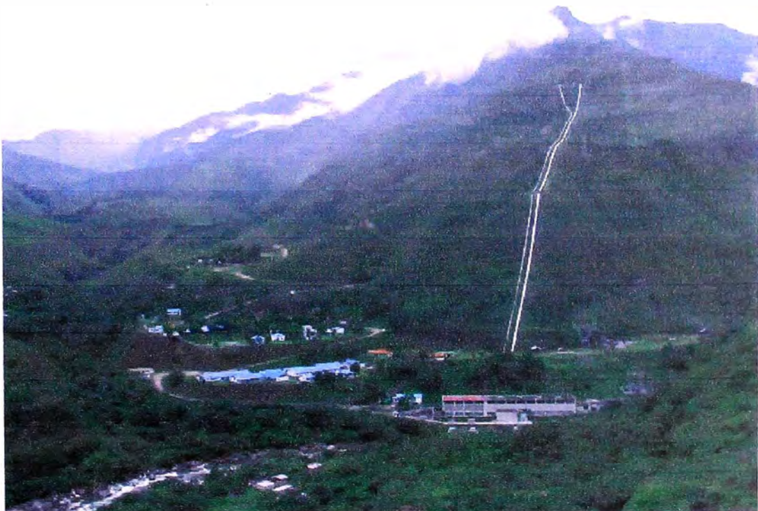
Figura 2.1 (Central Hidroeléctrica – Yaupi)
