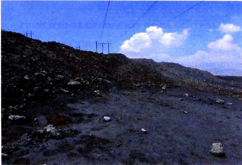
Figura 2.3 (Línea Yaupi – Carhuamayo en 138 Kv)
