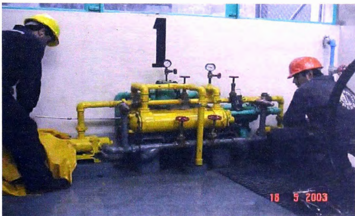
Figura 5.2 (Intercambiador de Calor Agua – Aceite de Lubricación)
