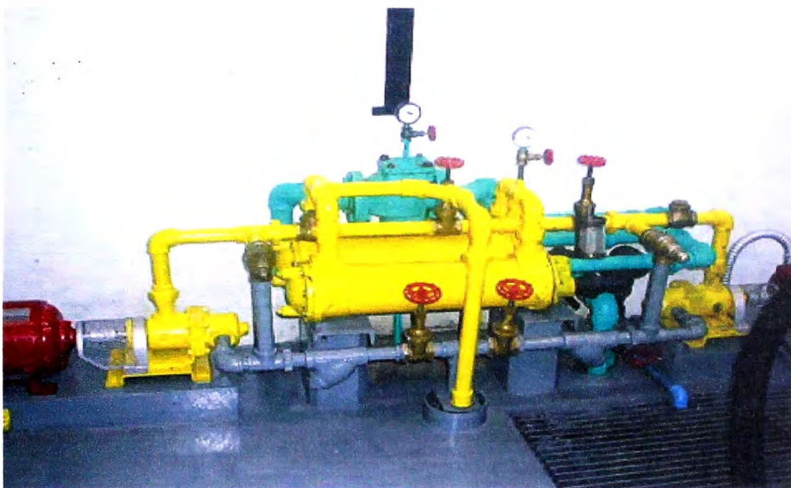
Figura 5.3 (Intercambiador de Calor Agua – Aceite de Lubricación)
