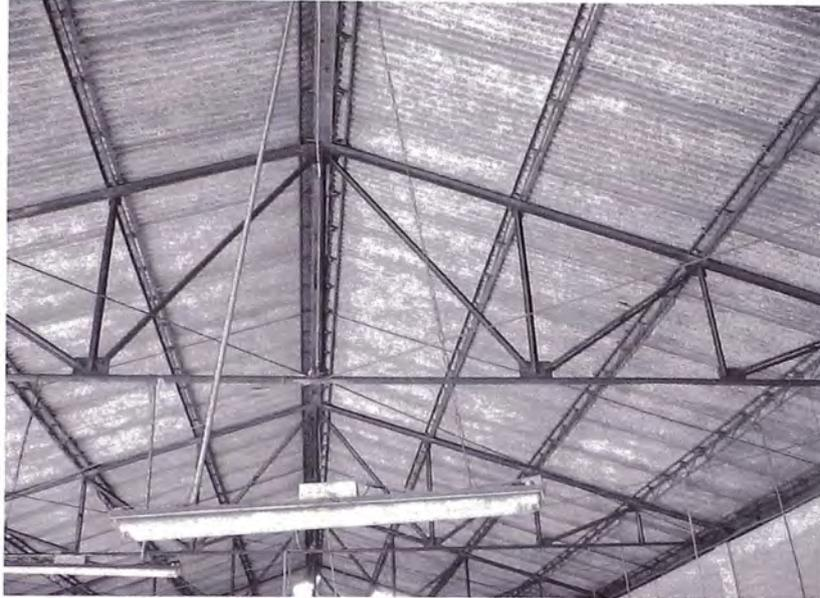
FOTO 1; Estructura reticular con signos de corrosión
