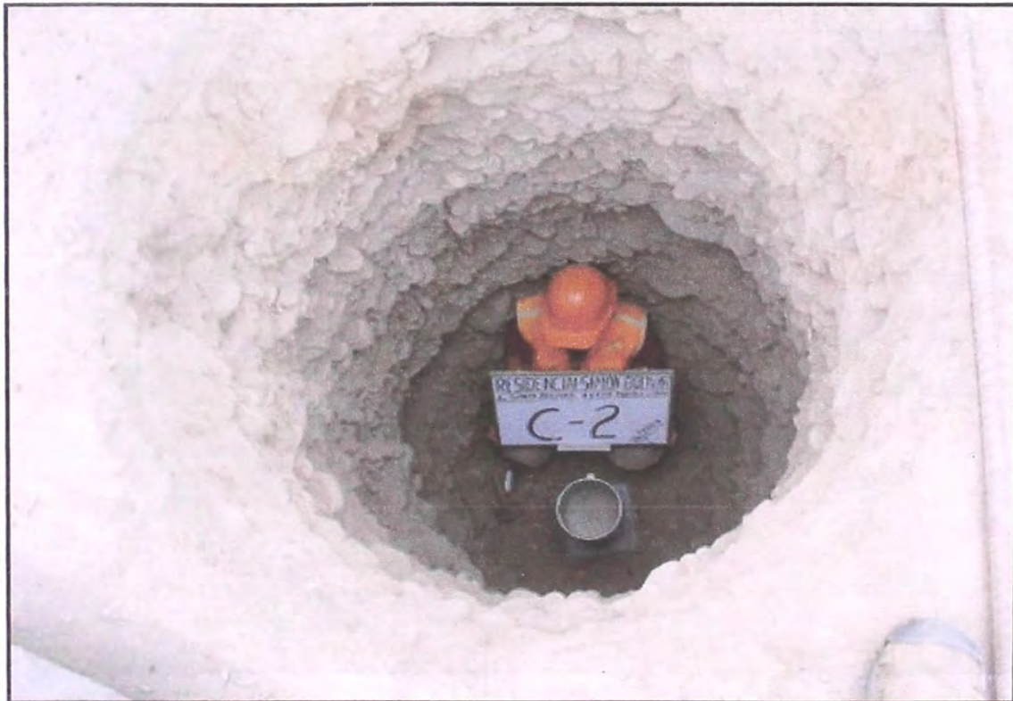
FOTO-06 VISTA DE LA CALICATA N°02, A 6.00M DE PROFUNDIDAD
