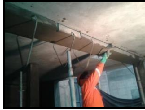
Tarrajeo de vigas y columnas
