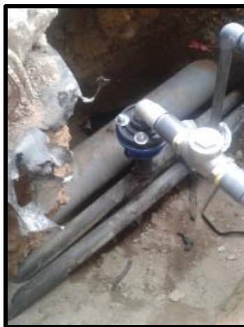
Empalme a red de agua y desagüe existente
