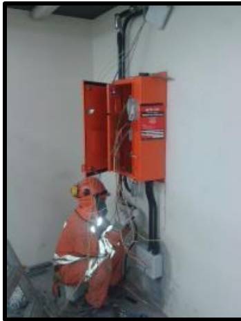
Instalación de tablero y peinado
