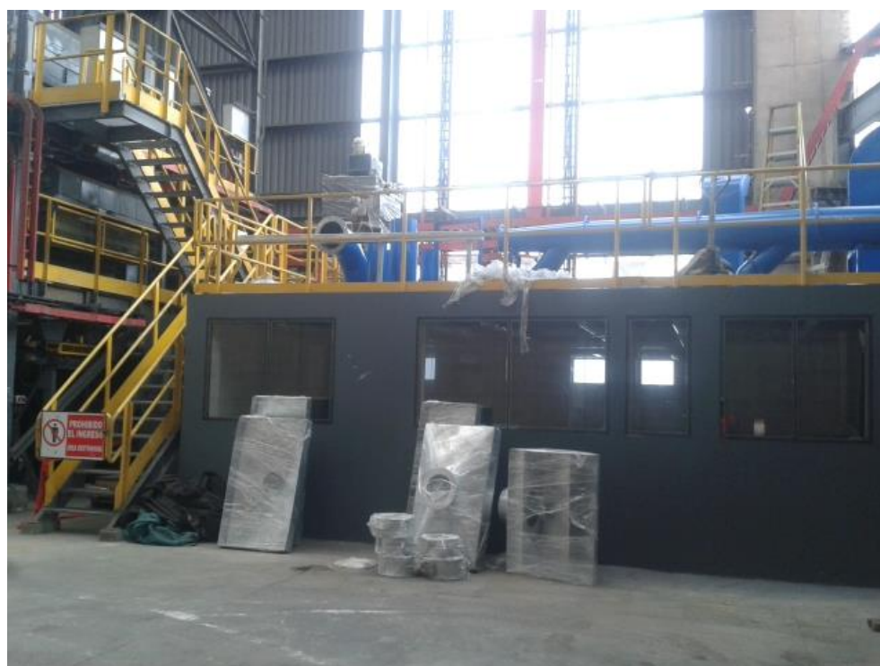
Figura 1.11: Sub contratistas del cliente en labores de colocación de equipos mecánicos en techo.
