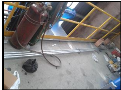
Entubado y conexionado de equipos en techo
