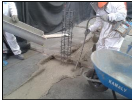
Vaciado de zapatas y cimientos
