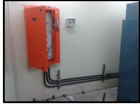
Instalación de tableros
