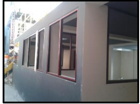
Pintado de muros exteriores y colocación de ventanas
