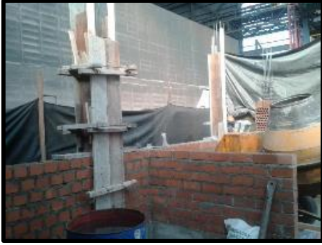
Encofrado de columnas
