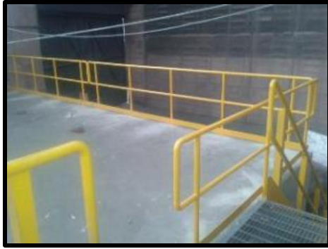
Colocación de barandas y greating en escalera
