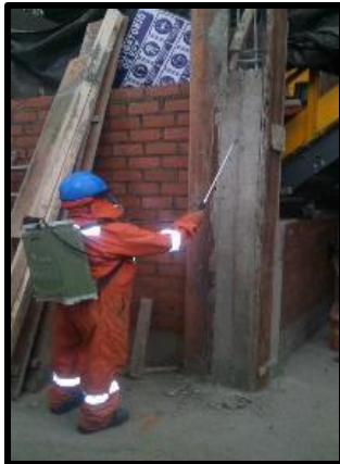
Vaciado de columnas y curado
