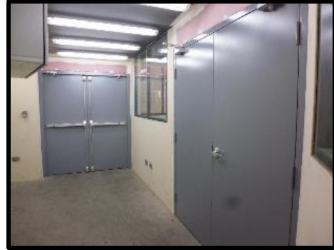
Instalación de puertas metálicas
