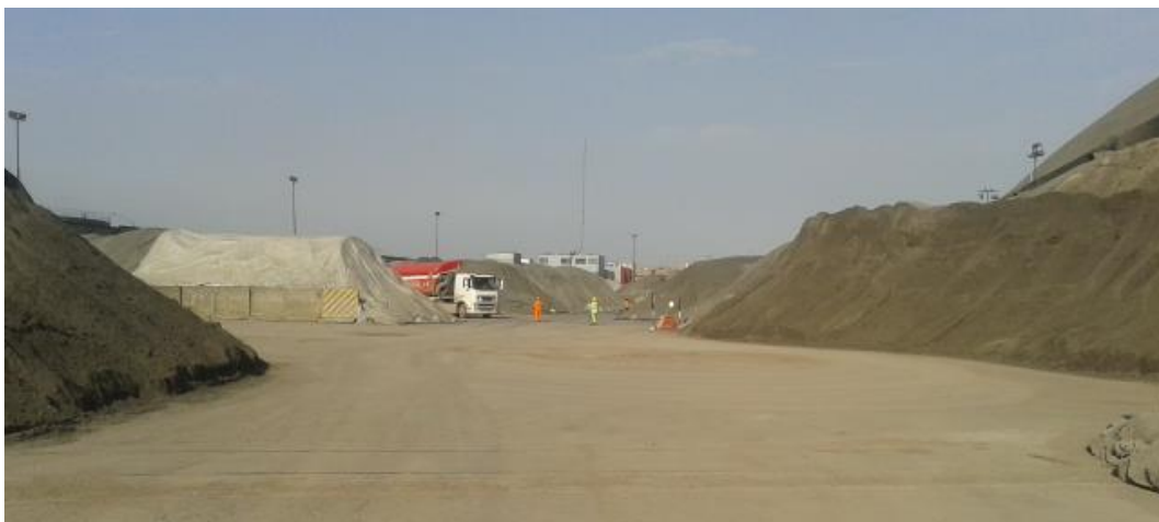
Figura 1.1: Apilamiento de mineral dentro del almacén de Perubar.
