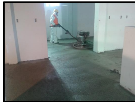
Vaciado de piso
