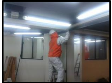
Colocación de mampara
