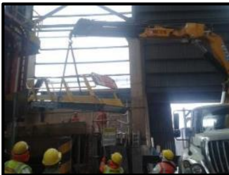
Desmontaje de escalera
