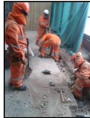
Excavación para zapatas y cimientos
