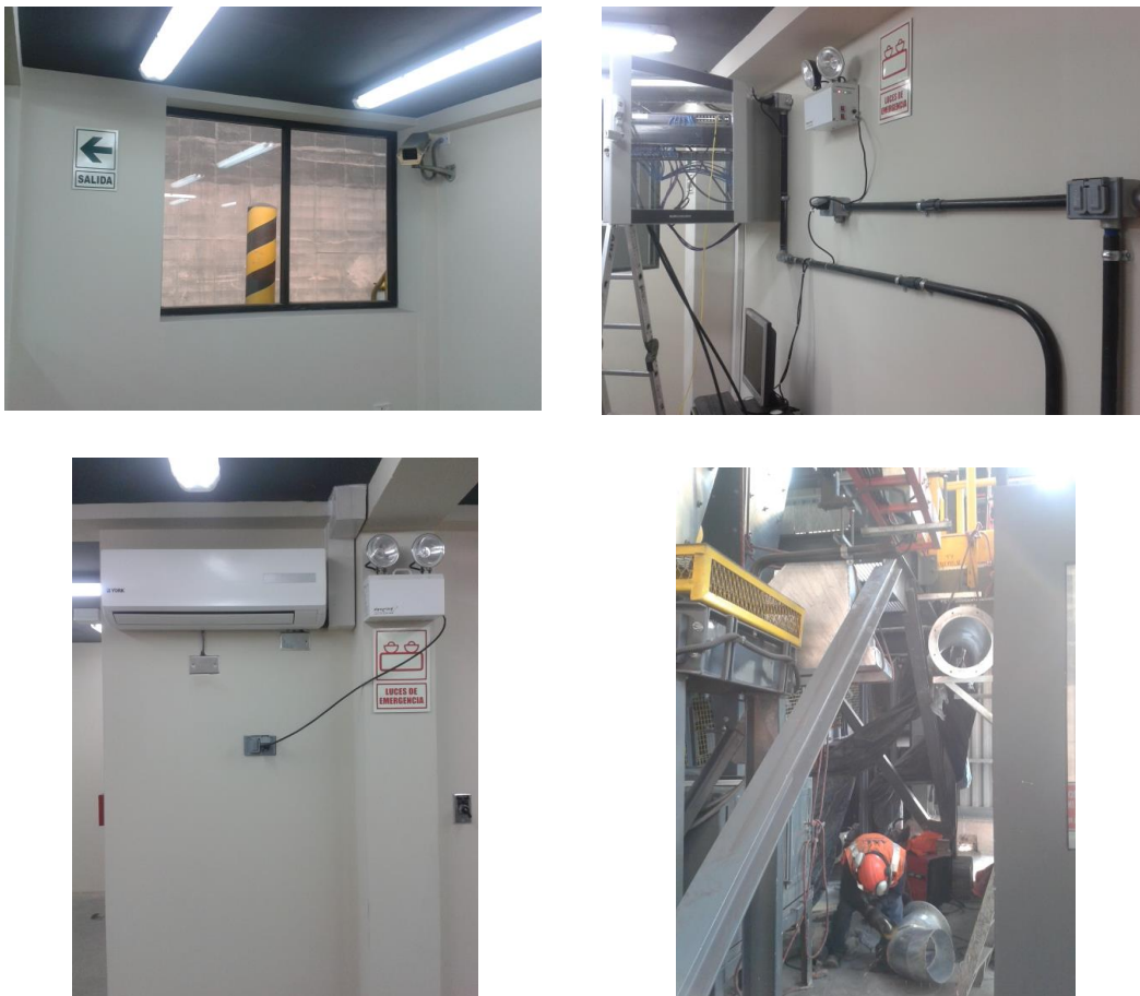
Figura 5.13: Trabajados en paralelo con sub contratistas del cliente.
