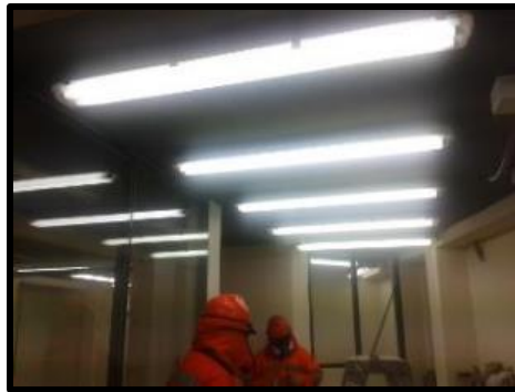
Colocación de luminarias
