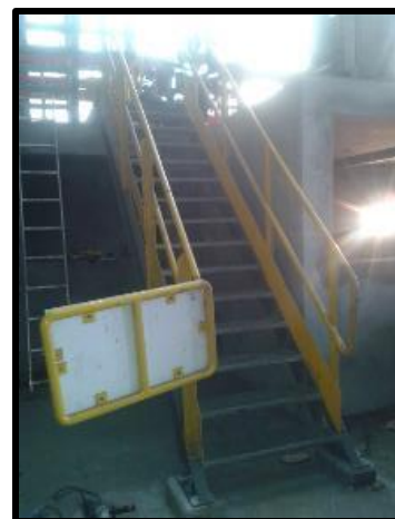
Montaje de escalera
