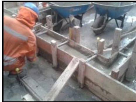
Encofrado y vaciado de sobre cimiento
