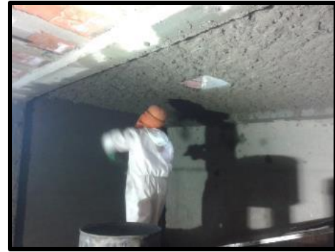
Tarrajeo en cielo raso
