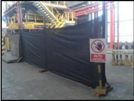
Cerco perimétrico en área de trabajo
