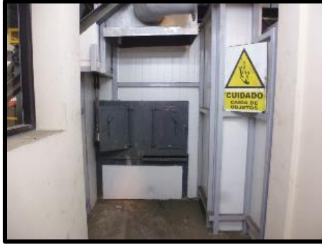
Instalación de termomuro
