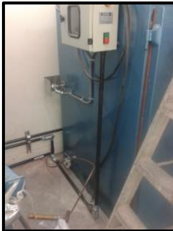
Instalación y conexionado de hornos
