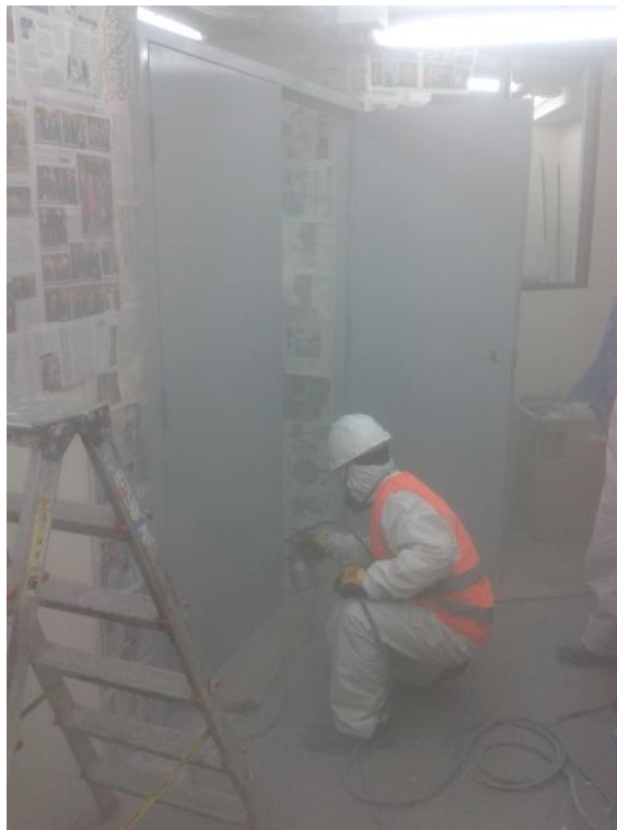
Figura 1.9: Sub contratista de Cidelsa (Empresa Ejecutora) en labores de pintado de puertas. Fuente: Elaboración Propia.
