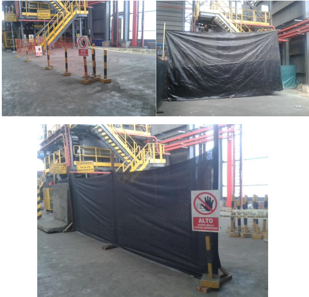
Figura 5.9: Mejoramiento del cerco perimétrico.
