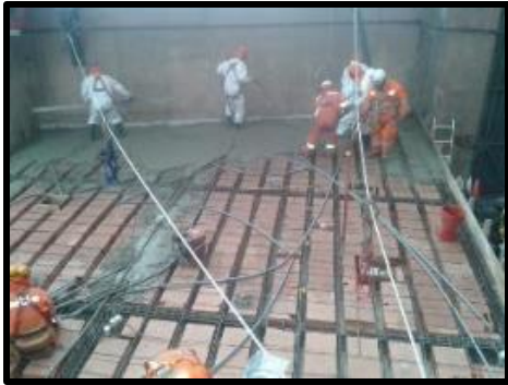
Vaciado de losa aligerada
