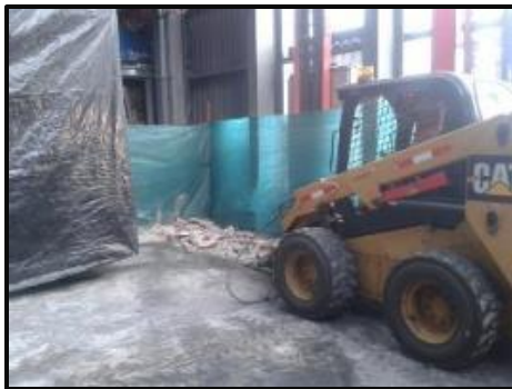
Corte y demolición de losa para zapatas y cimientos
