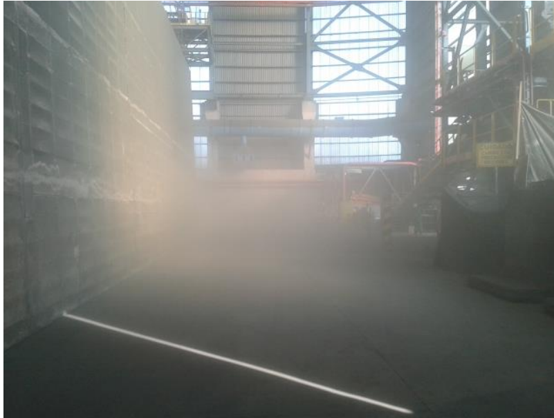
Figura 1.6: Polución en almacén de pre embarque, se aprecia polvo de mineral suspendido en el aire.
