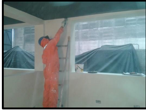
Pintado de muros interiores y cielo raso
