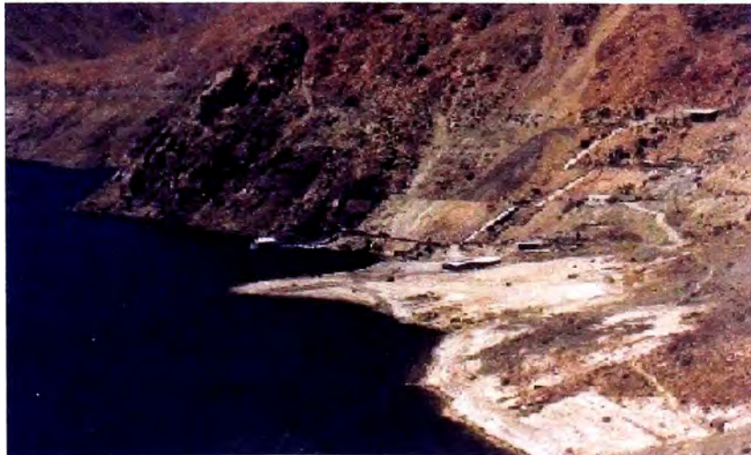
" Vista de la Laguna Aricota y los Túneles de Aducción "
