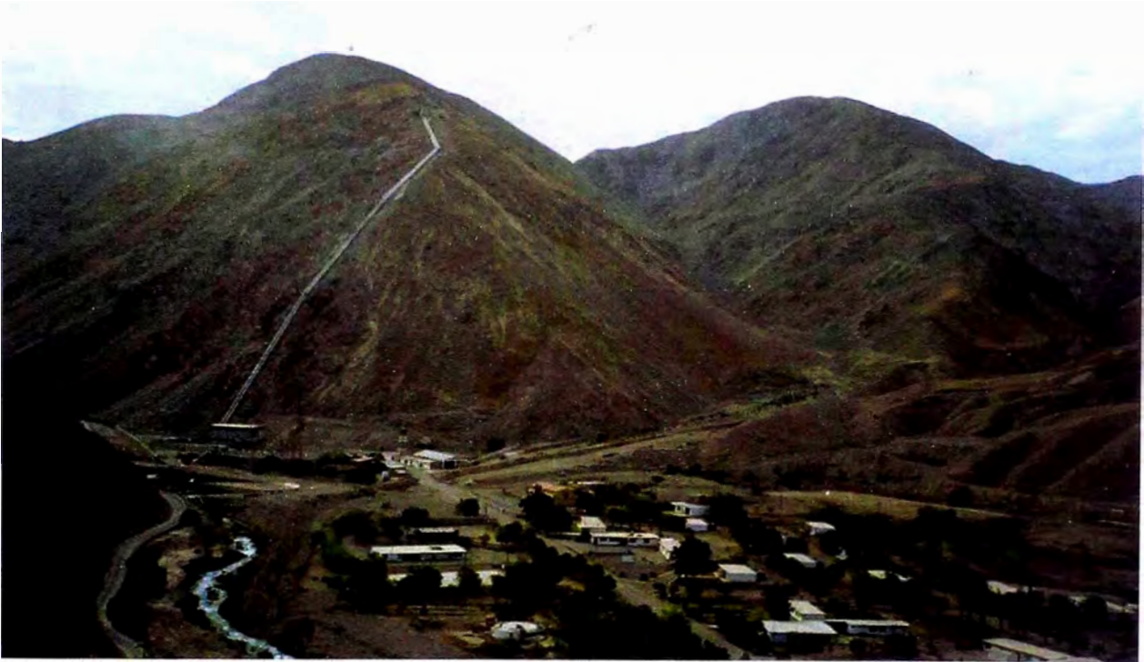
Muestra las instalaciones de C.H. Aricota II, campamento de Chintari y río Curibaya
