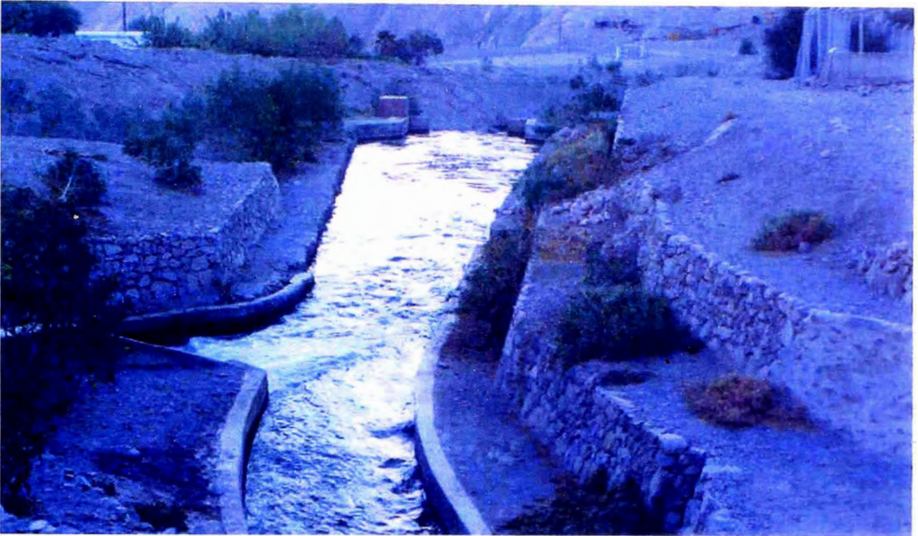
Vista aguas arriba del vertedero de control, cauce del río Curibaya
