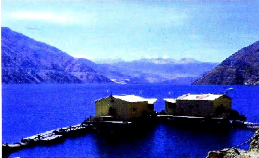
"Pontones de la Planta de Bombeo"
