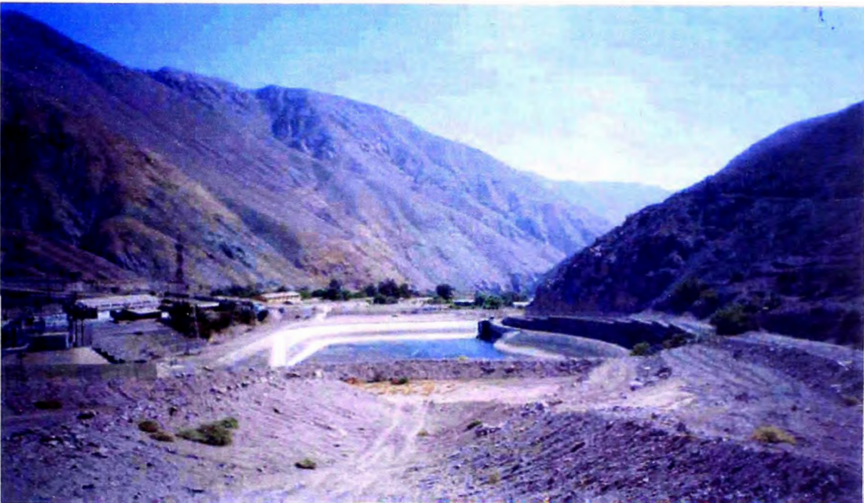
Vista del Reservoirio de Regulación No 1
