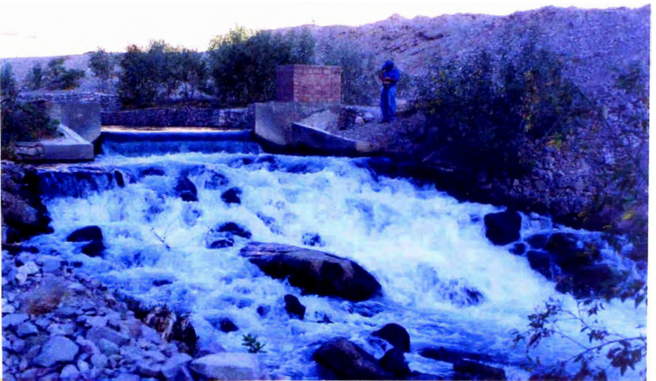
Vista aguas abajo del Vertedero de Control, existente
