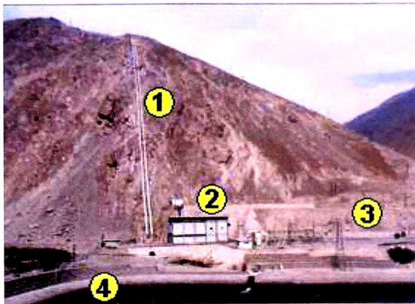
" Vista Exterior de la C.H. Aricota II "
