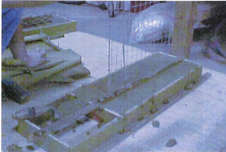
Figura N° 4.6.- Vaceado del cimiento
