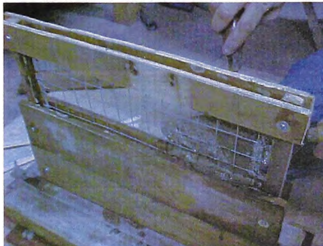
Figura N° 4.9.- Vaceado del muro (parte intermedia)
