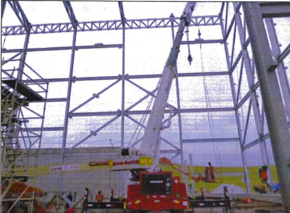
Foto N°25.- Uso de Equipos como grúas y Manliff para Instalación de Columnas Metálicas
