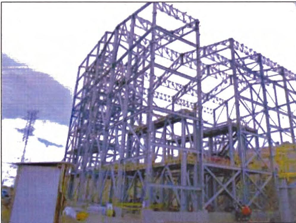
Foto N°24.- Montaje de Metálicos en Zona de Chancado Secundario
