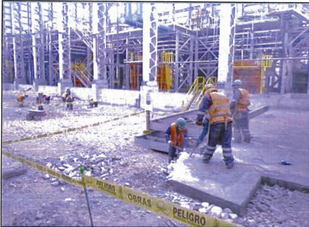
Foto N°76.-Demolición de losa de concreto.
