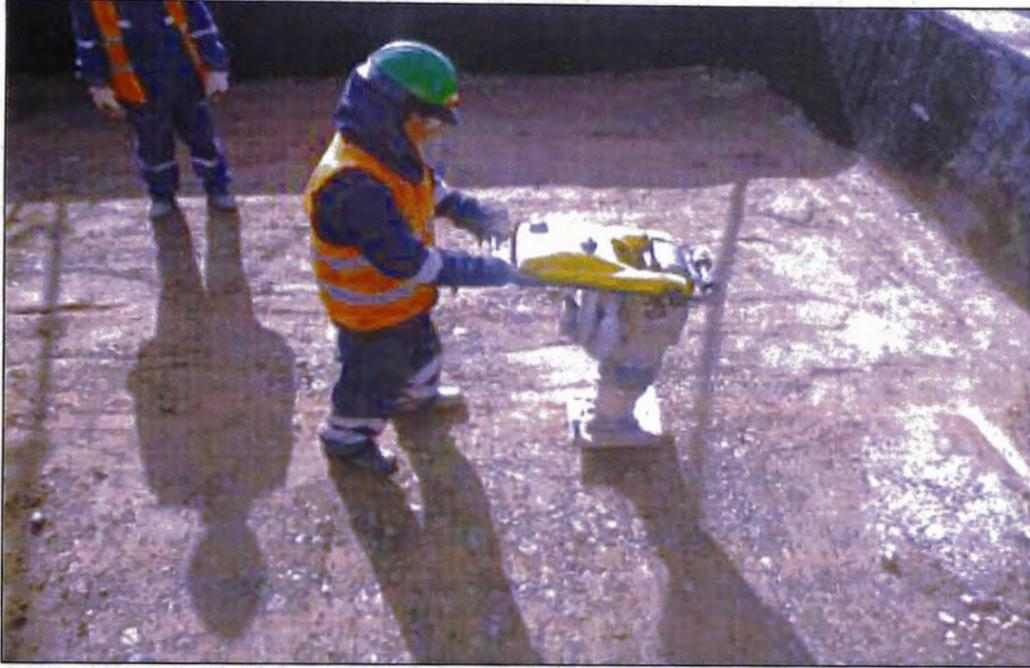
**Foto N°39.- Relleno y compactación con material estructural**
