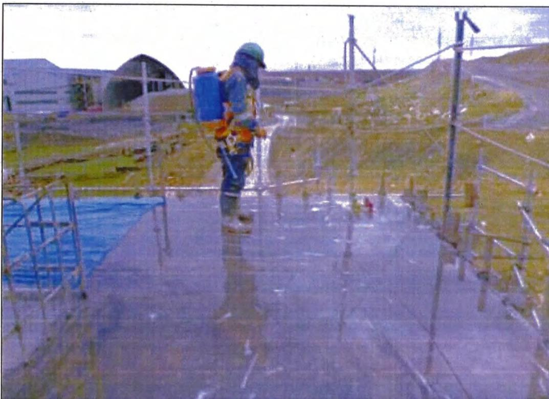
**Foto N°47.- Curado de superficie de losa maciza**
