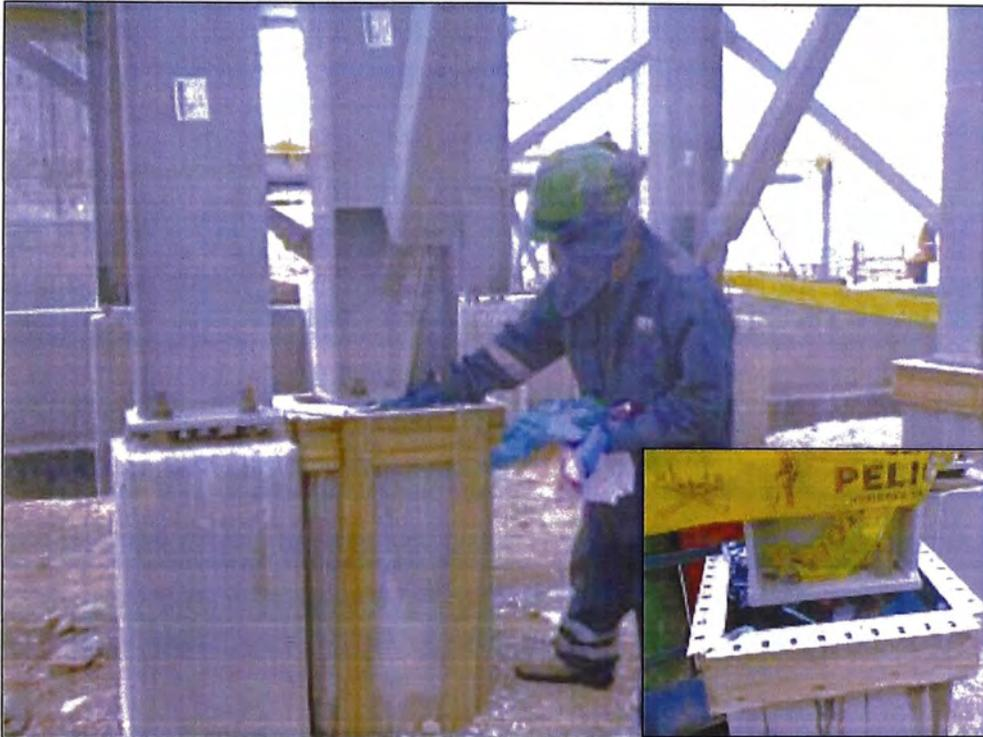
Foto N°23.- Encofrado de pedestales, para la colocación de grout, en el area de chancado secundario.
