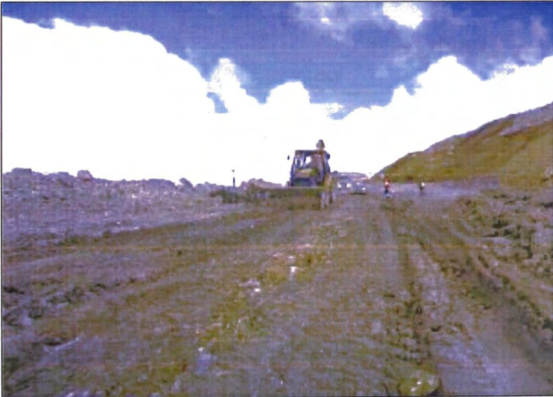
*Foto N°10.- Limpieza de lodo y mantenimiento del acceso principal que va hacia cancha de transferencia/chancado primario.*
