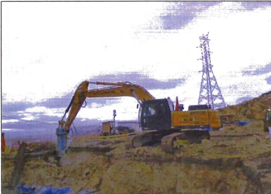
Foto N°18.- Excavación y Demolición en Roca
