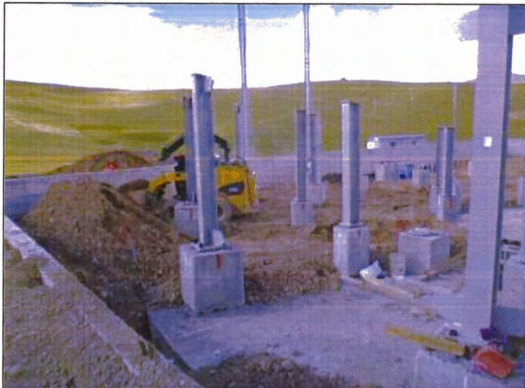
Foto N°31.- Instalación de Columnas Metálicas en Clarificar de Finos.
