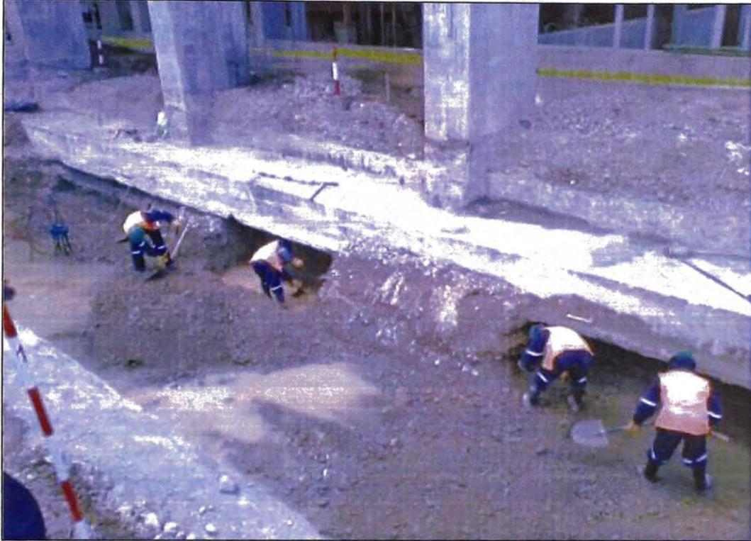
Foto N°58.- Excavación manual en material suelto bajo agua para calzaduras.
