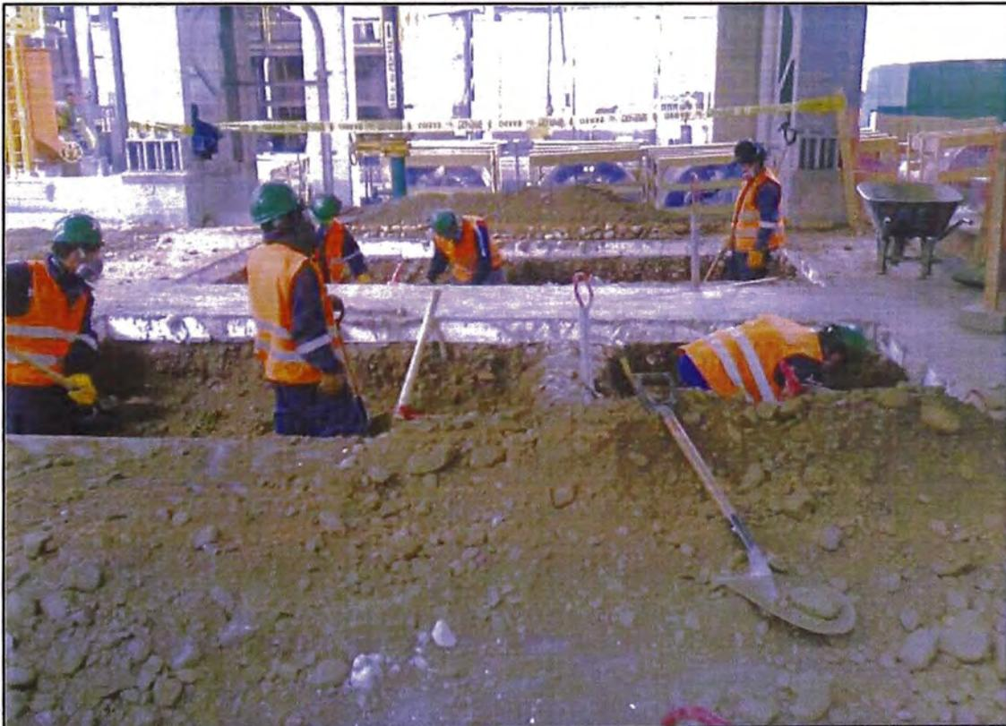
**Foto N°73.- Excavación en base de Sopladores Spencer.**
