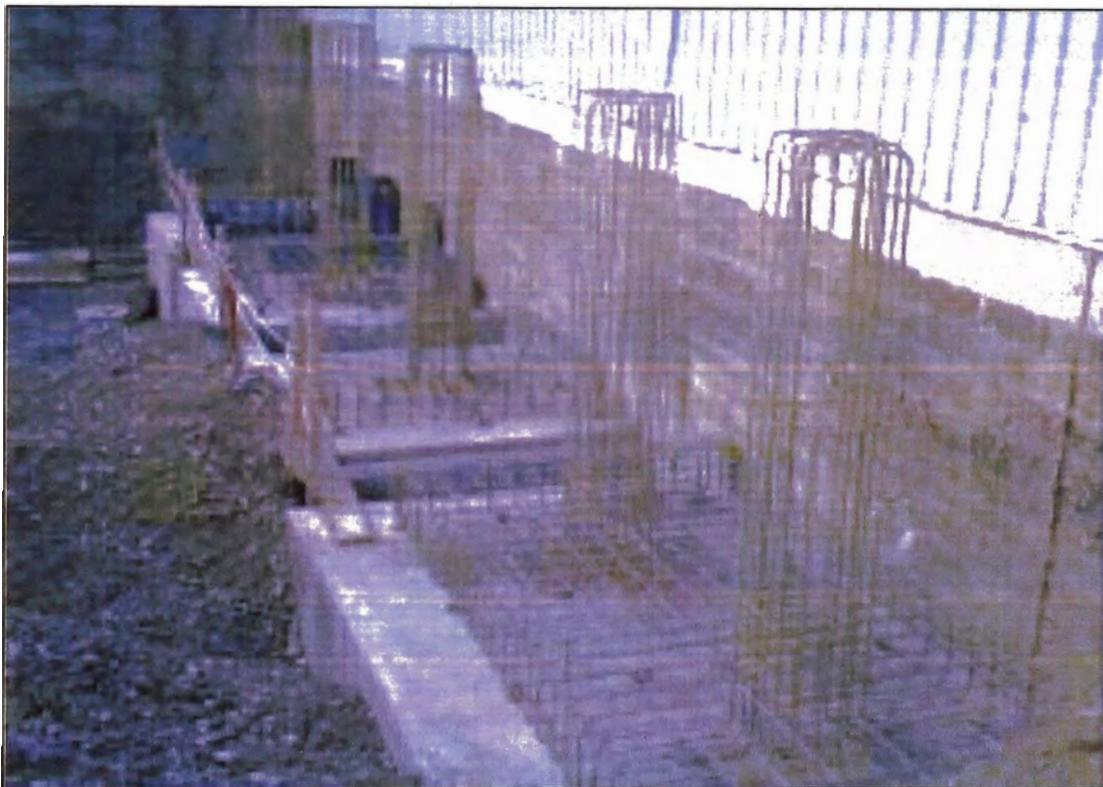
**Foto N°71.- Vista que se muestra la colocación y aseguramiento de aceros en Zapata en Zaranda Derrick**
