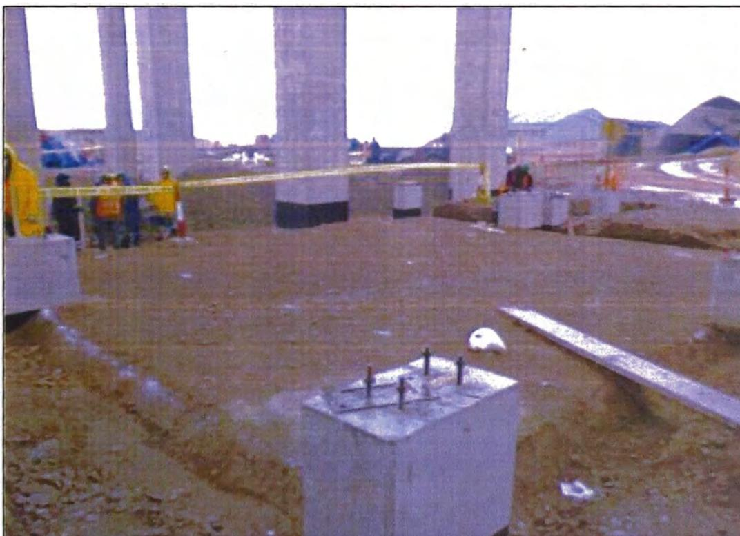
Foto N°42.-Imprimacion con pintura Bituminosa hasta nivel de Piso
