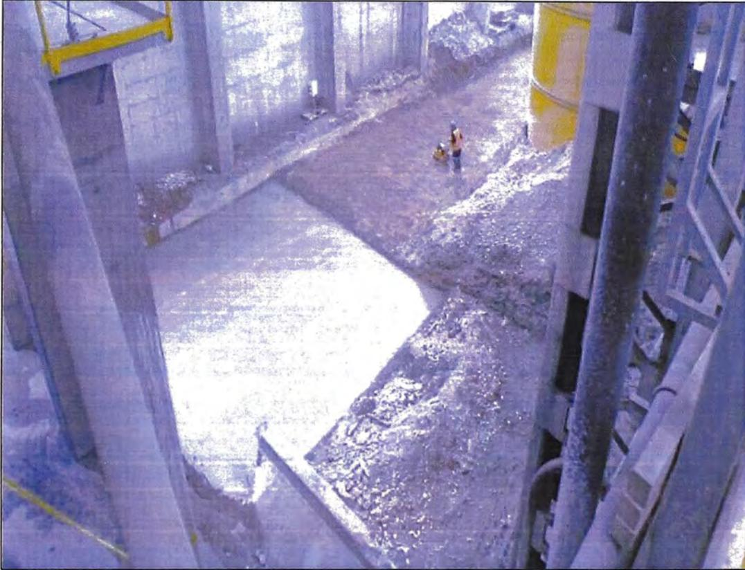
**Foto N°78.- Vaciado culminado de solado dejando habilitado para el armado de acero.**
