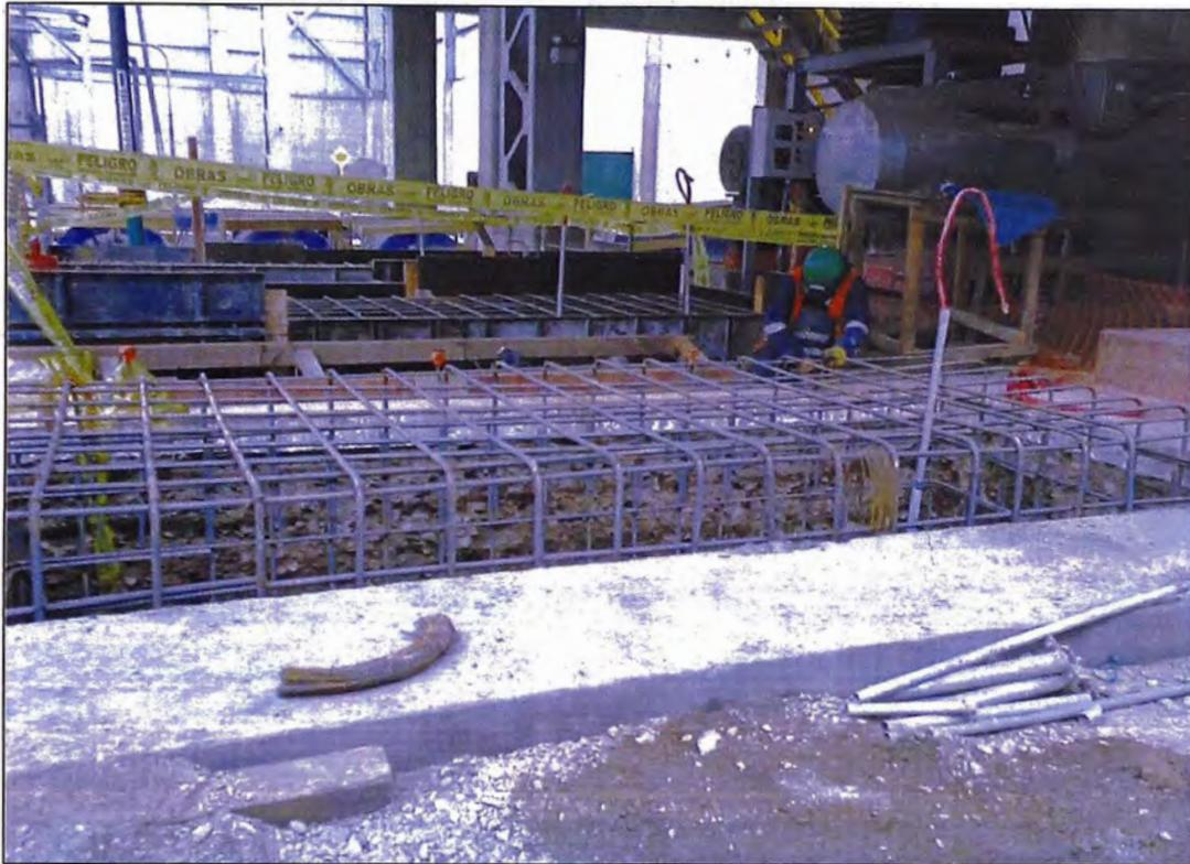
Foto N°74.- Colocación de acero de refuerzo en la base de Sopladores Spencer.
