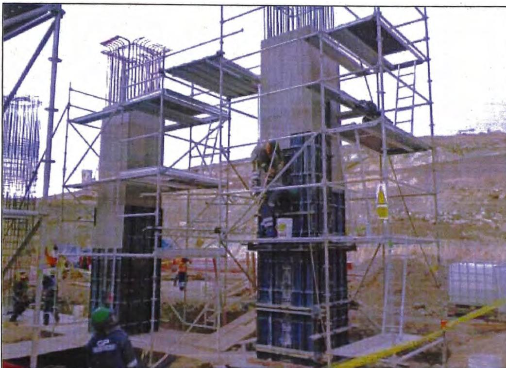
Foto N°41.- Desencofrado de Columnas en chancado Terciario
