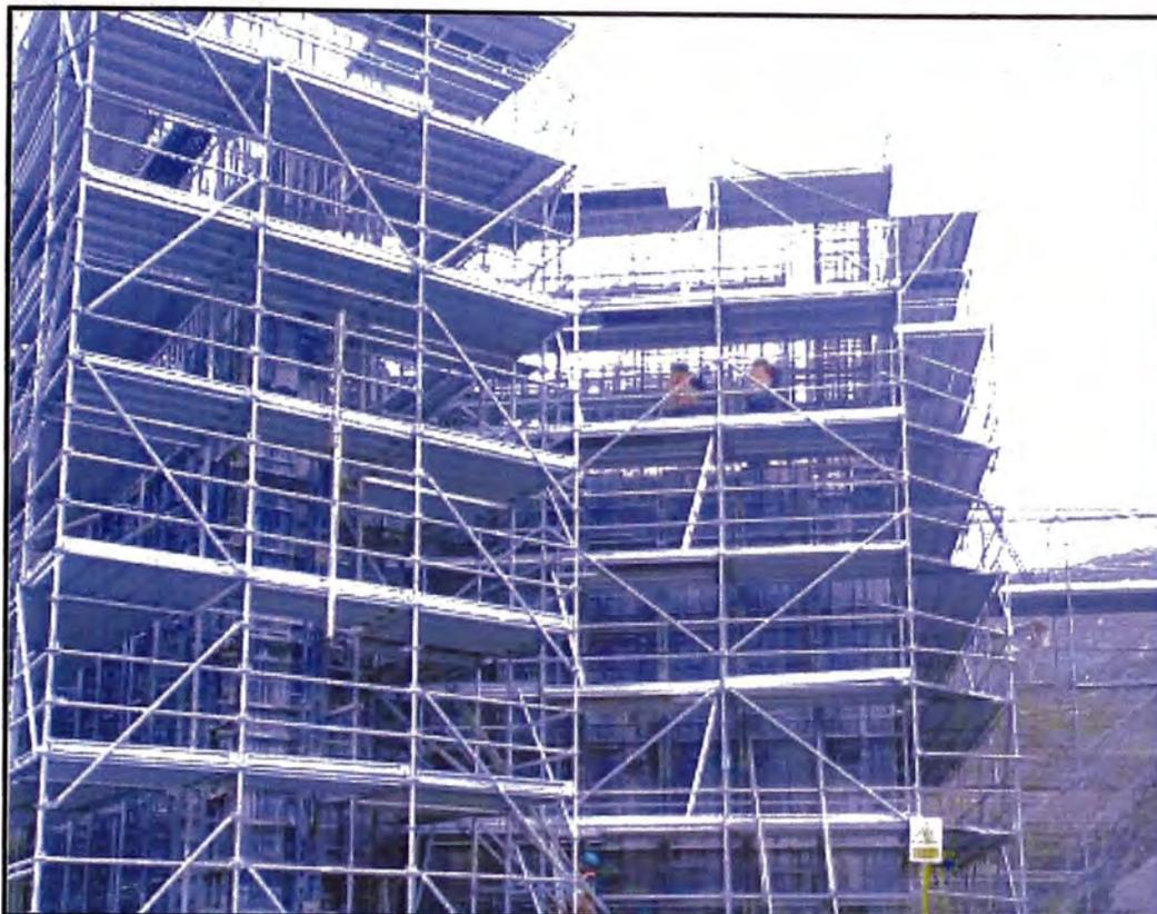
Foto N°11.- Armado de Andamios y acero de refuerzo en muros y contrafuertes del Muro de Descarga Principal (Altura aprox. 14 m)
