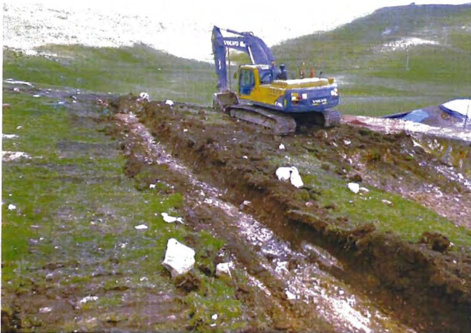
Foto N°35.- Construcción de Cunetas de Coronación para evitar deslizamientos en el talud
