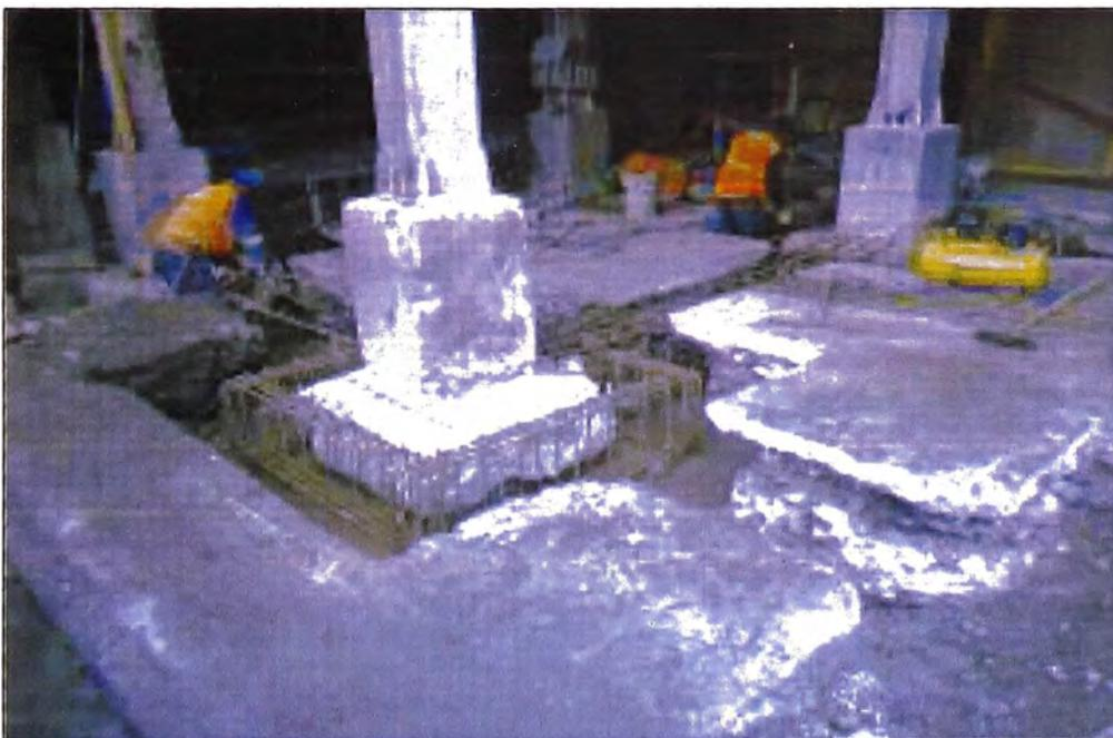
Foto N°85.- La vista colocación de aceros en zapatas en pedestales
