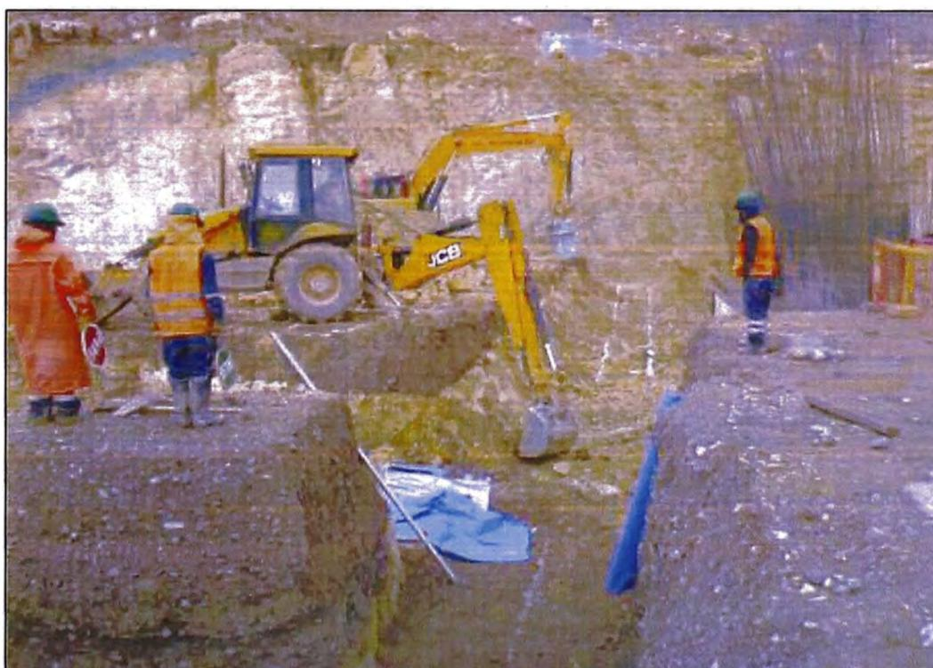
Foto N°20.- Excavaciones de Zanjas en Zona de Chancado Secundario y Area de Lavado.
