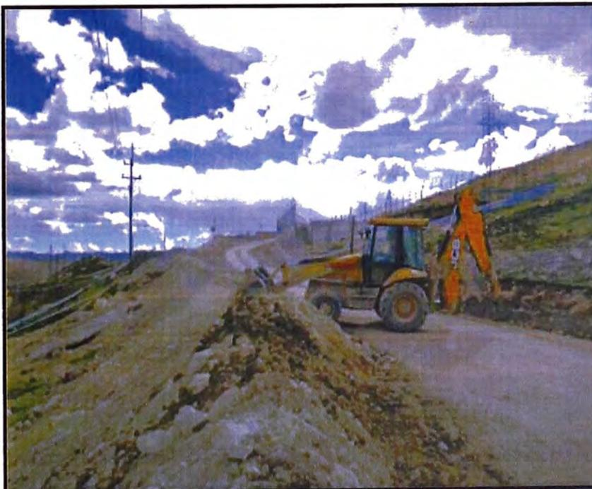
Foto N°38.- Acopio de Material excavado
