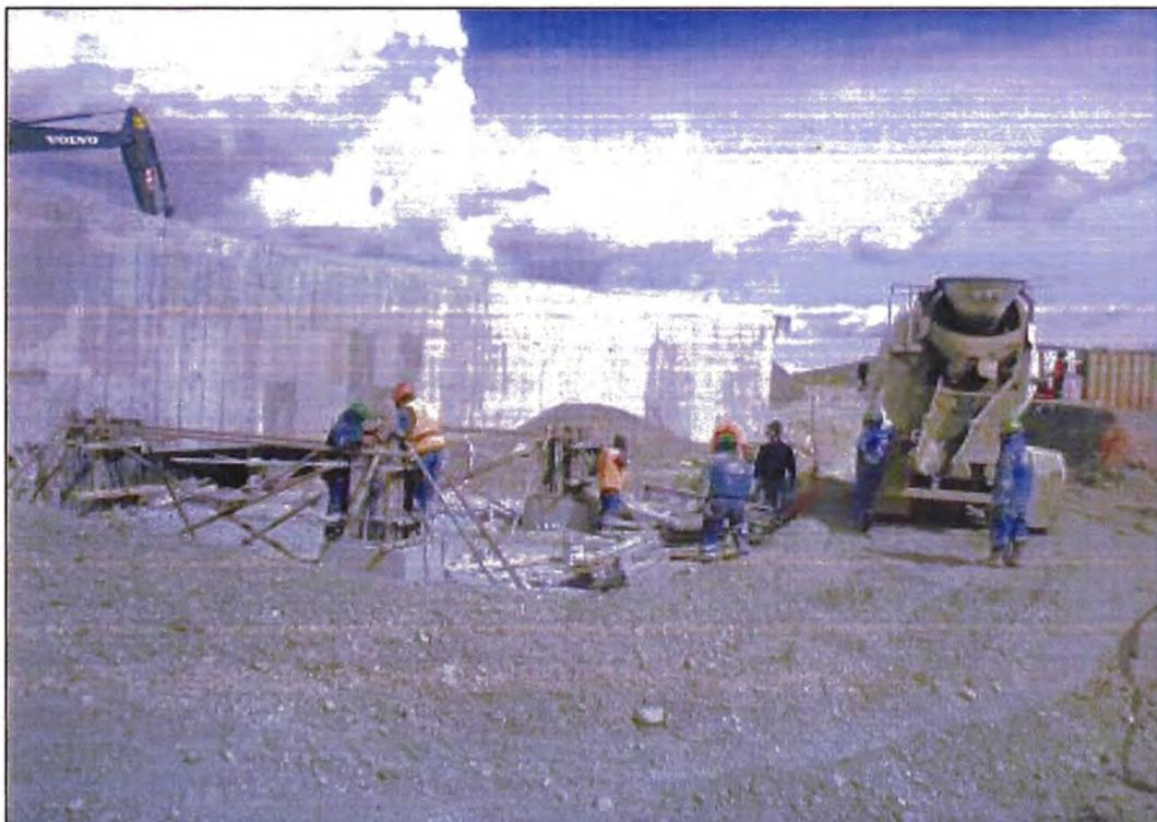
Foto N°14.- Vaciado de concreto en pedestales P-5 en zona de descarga.
