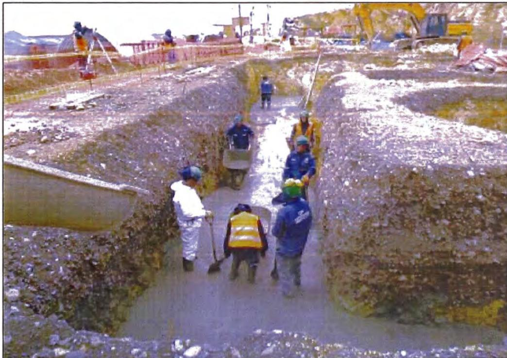
**Foto N°22.- Vaciado de Concreto para solado en zona de Chancado Secundario.**
