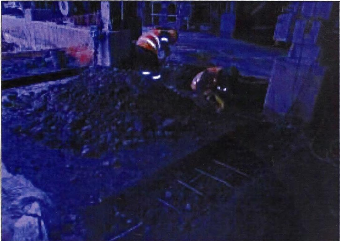
Foto N°84.- Excavación localizada para el encofrado de vigas de reforzamiento.
