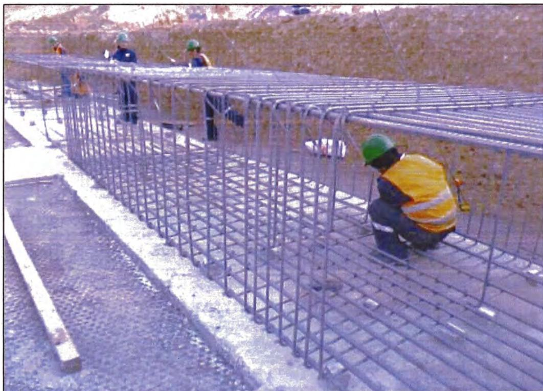
Foto N°38.- Colocado de estribos de 1/2" para la zapata
