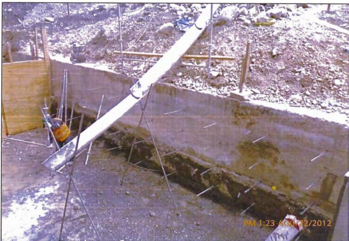
**Foto N°57.- Colocación de anclaje químico en falsa zapata existente según plano de ejecución.**
