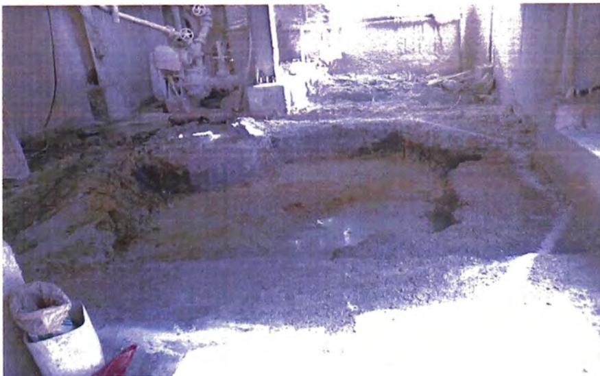
Foto N°40.- Demolición de Estructura de Losa existente
