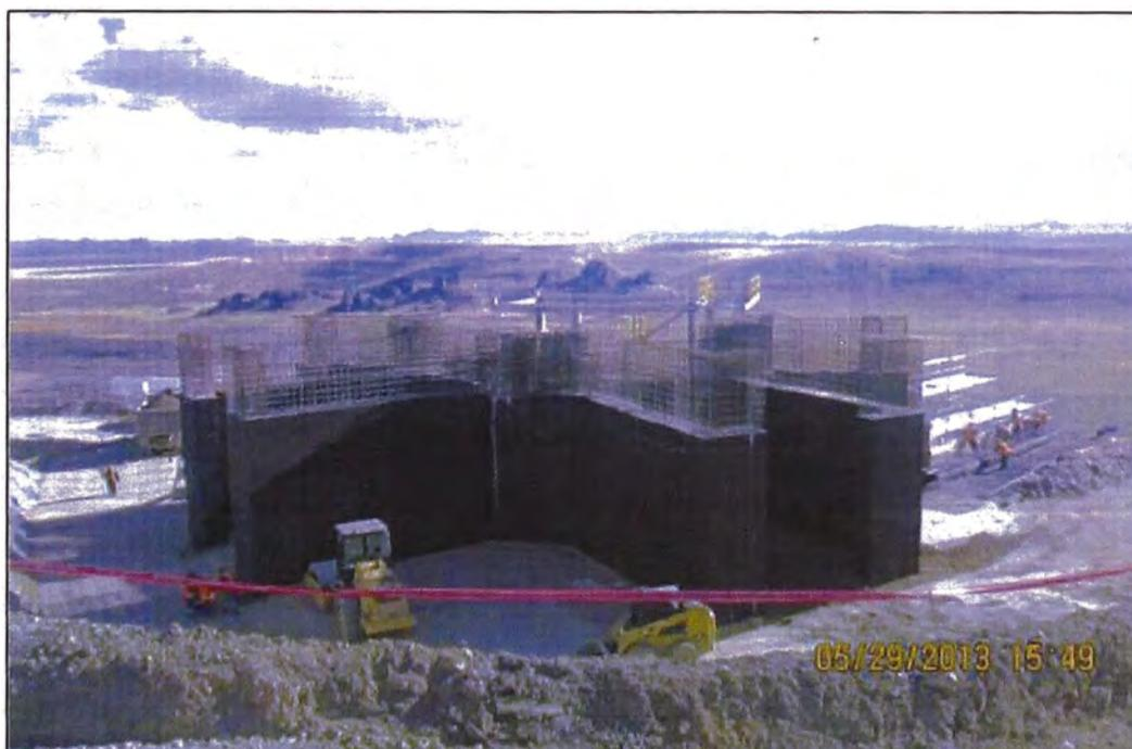
Foto N°12.- Rellenos del Muro de Descarga Principal, aplicación de Material Bituminoso para evitar el contacto del concreto con el material de relleno y sales
