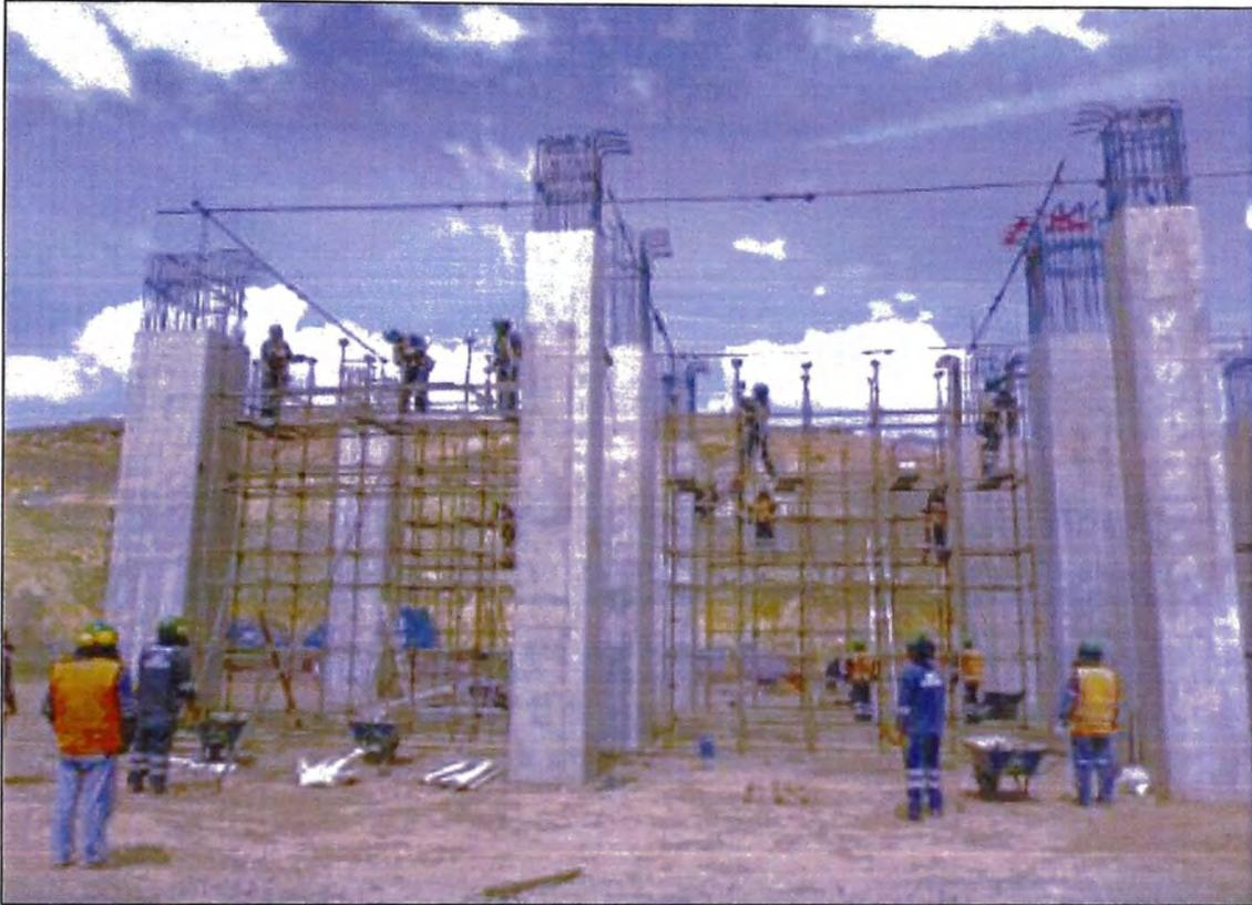
Foto N°43.-Armado de andamios para Losa Maciza de chancado terciario
