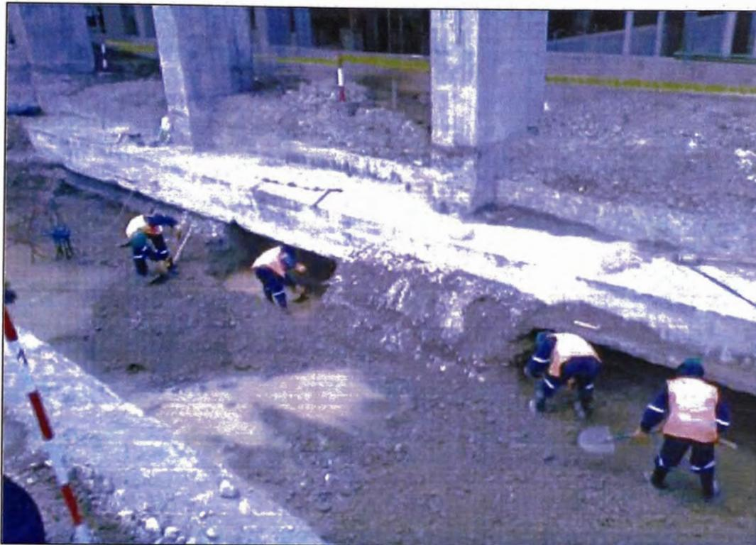
Foto N°39.- Excavacion de calzaduras
