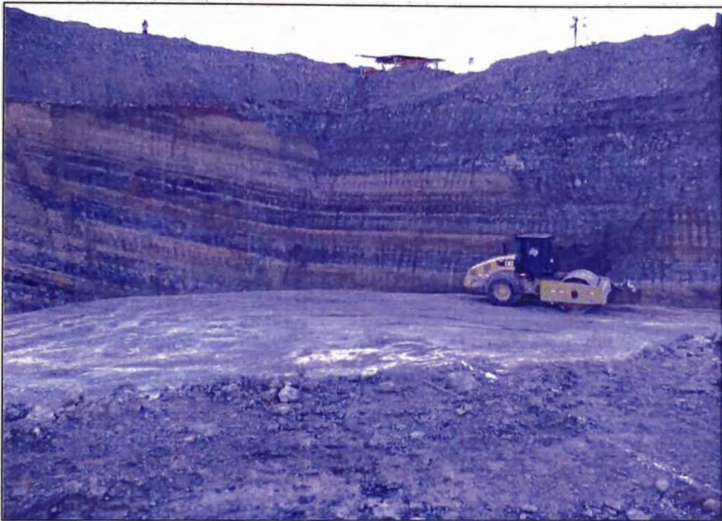
**Foto N°5.- Nivelación y compactación de superficie para cimentaciones de Chancado Primario**
