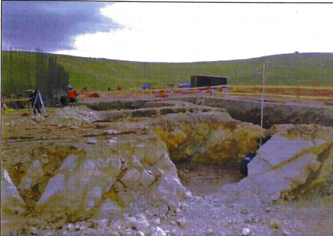
**Foto N°21.- Demolición de Roca para zanjas de Chancado Secundario.**
