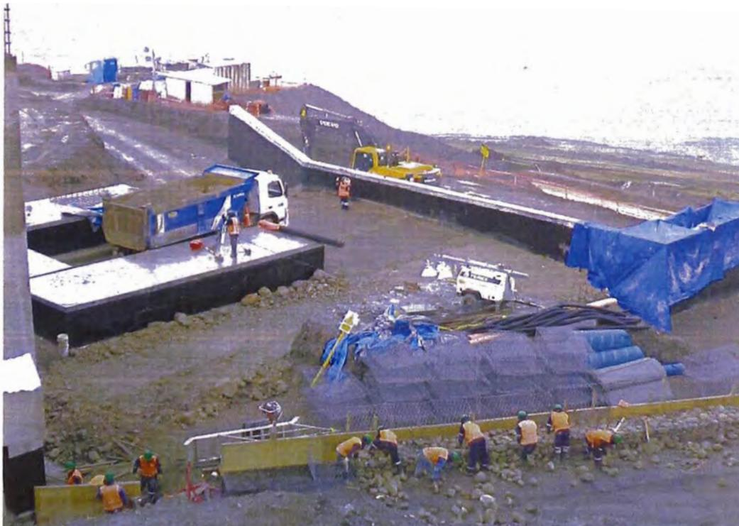
Foto N°16.- Inicios de trabajos del Muro Terramesh – Armado de Gaviones
