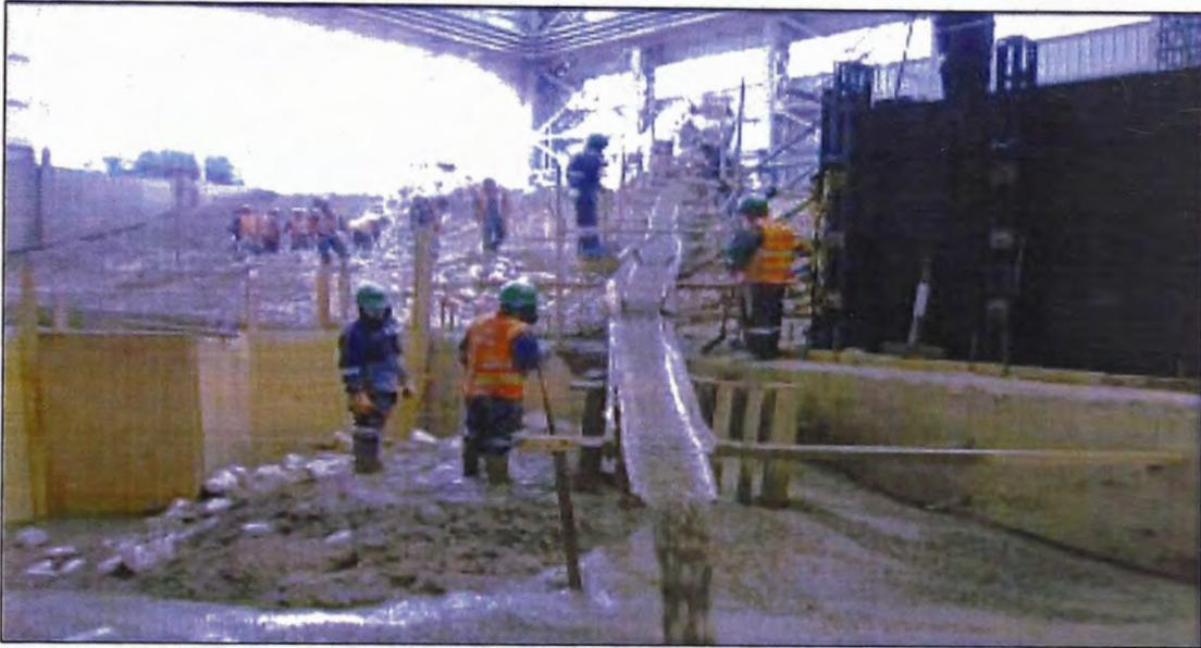
**Foto N°56.- Vaciado de Zapatas de Molinos**
