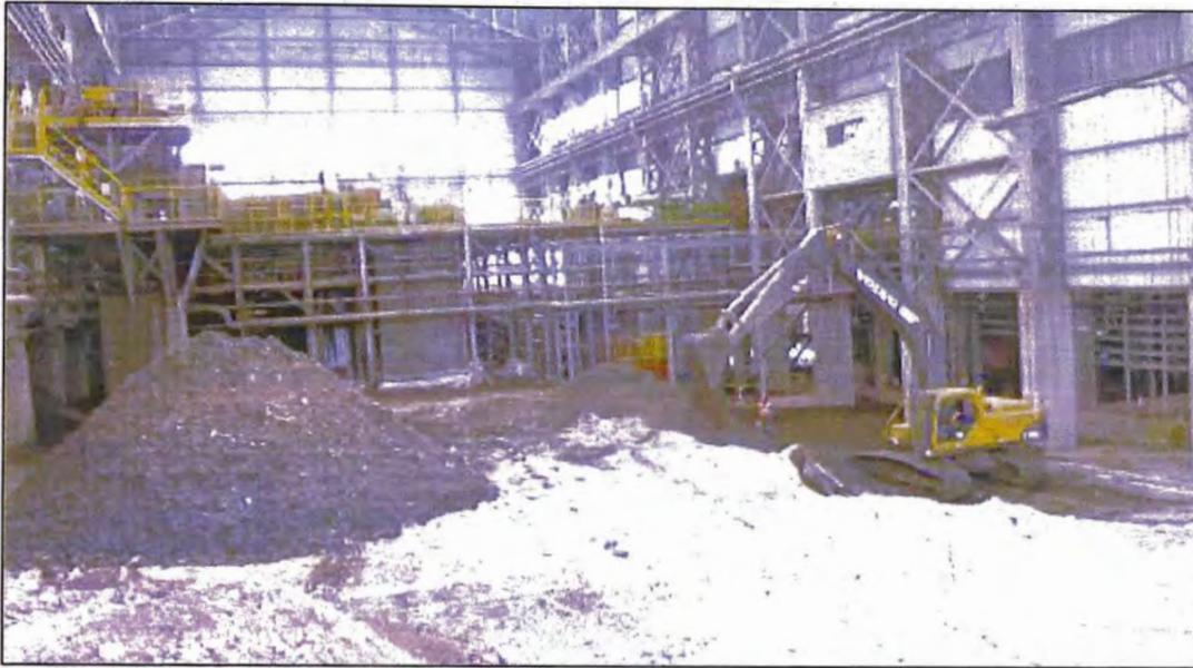
Foto N°53.- Excavaciones para llegar a nivel falsa zapata.
