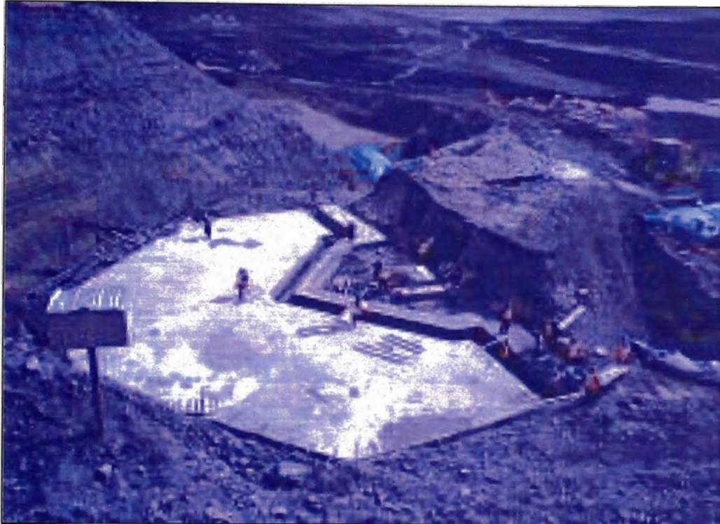
Foto N°7.- Se realizó el desencofrado del Solado
