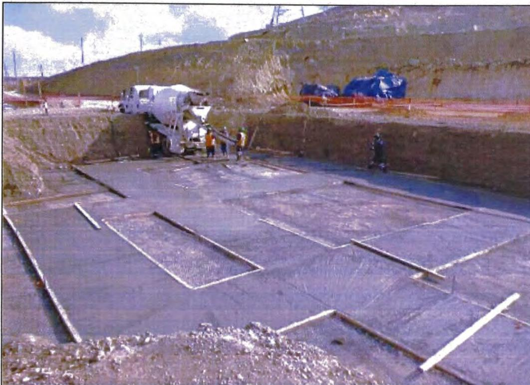
Foto N°37.- Vaciado de solado para zapata concreto  $f'c=100$  kg/cm<sup>2</sup> CTP "I"
