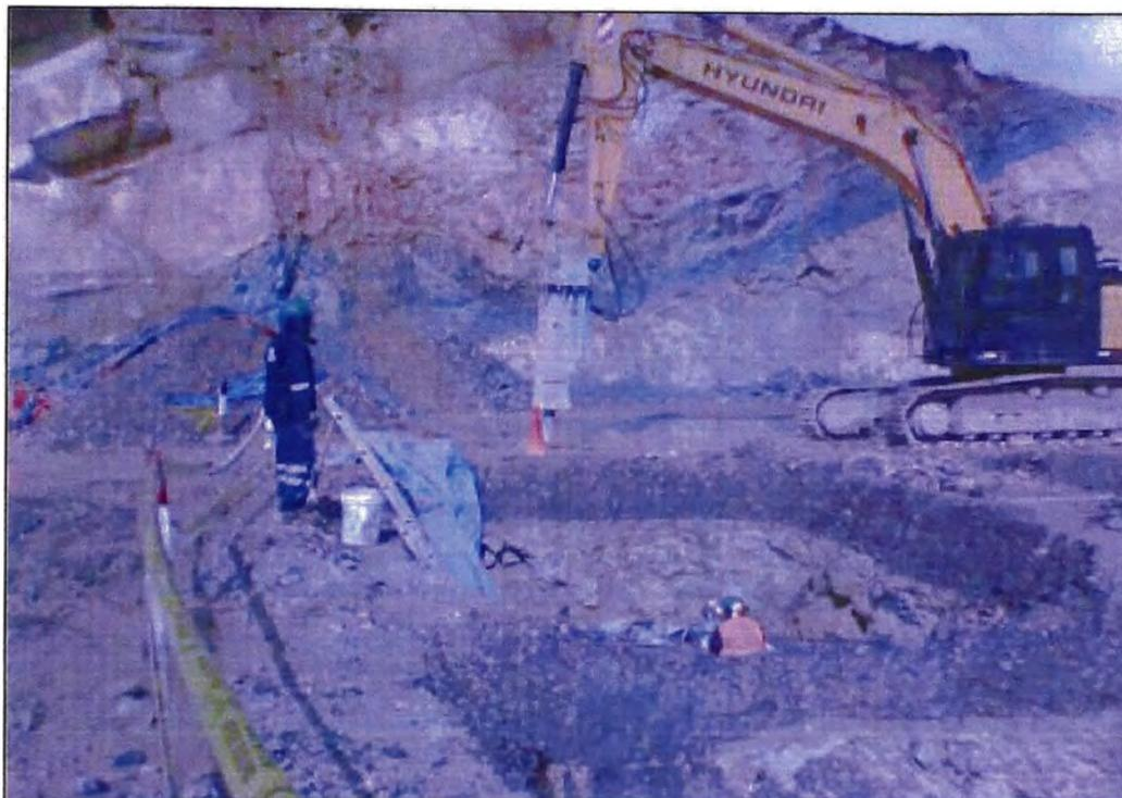
Foto N°19.- Limpieza de zanja y eliminación de agua para relleno y compactación.
