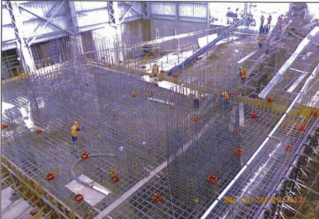
Foto N°64.- Vaciado de concreto  $f_c=280\text{kg/cm}^2$  de la zapata del molino  $20' \times 30'$  con bomba de concreto y mixer.
