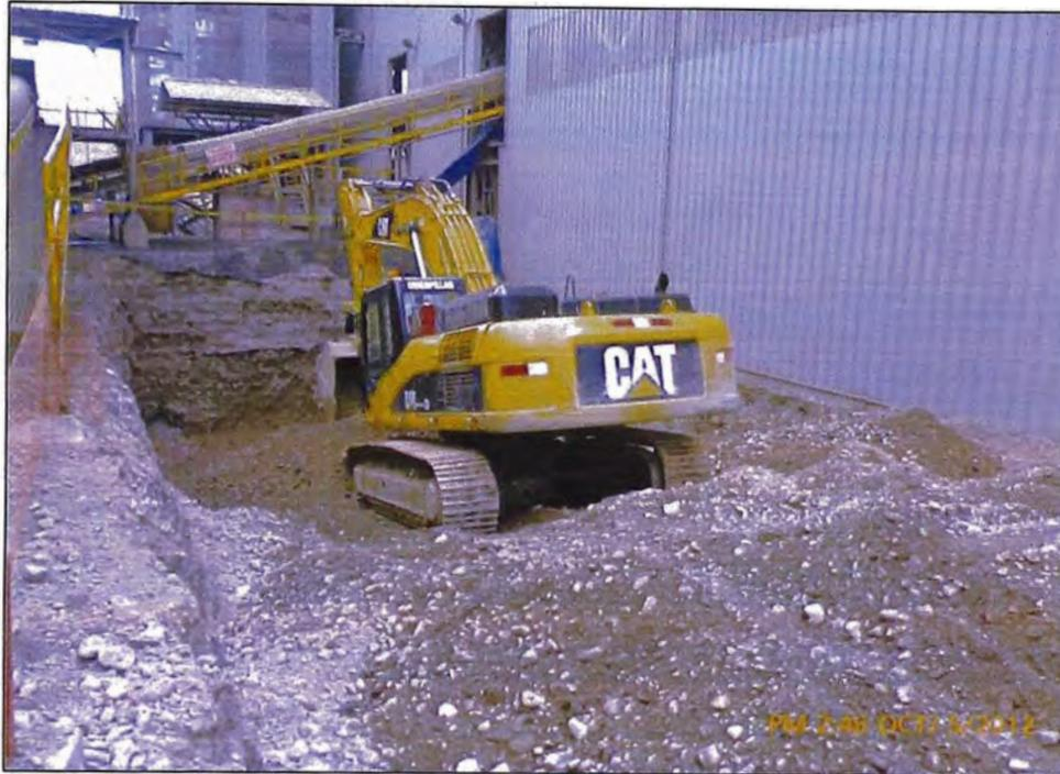
Foto N°68.- Excavación masiva en zona de Zarandas Derrick-Molienda
