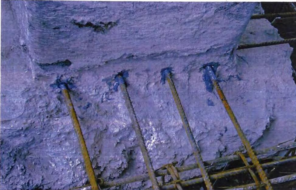
Foto N°41.- Anclaje químico para ampliación de los cimientos del sector reactivos y cal
