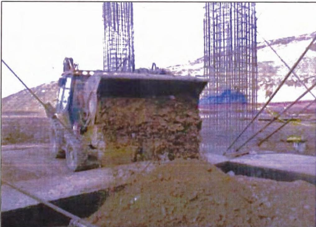
**Foto N°40.- Relleno compactado estructural y transporte de material de préstamo.**
