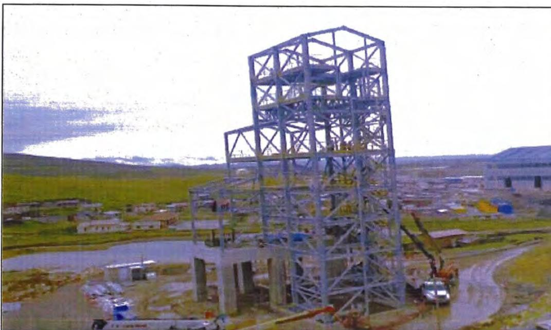
**Foto N°49.- Montaje columnas y vigas metálicas para la instalación de coberturas**
