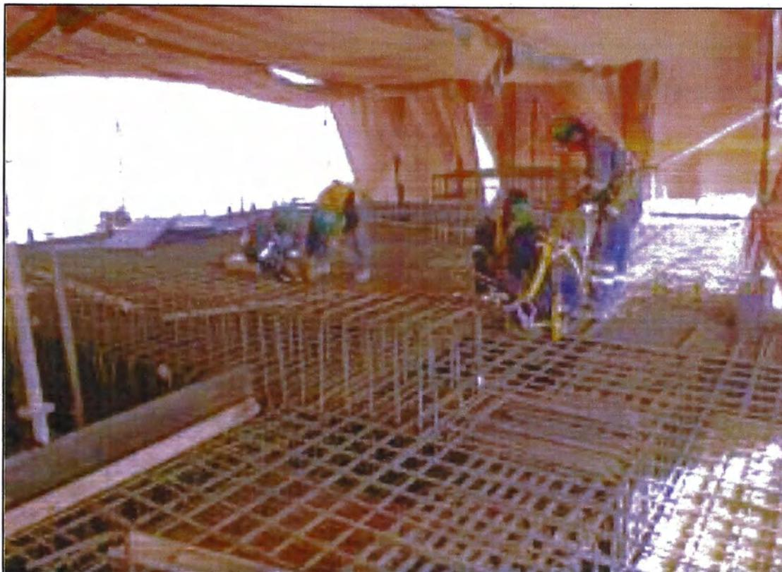
**Foto N°45.- Armado de Acero de refuerzo longitudinales y estribos en las vigas para colocación de cajuela por indefinición de Ingeniería**
