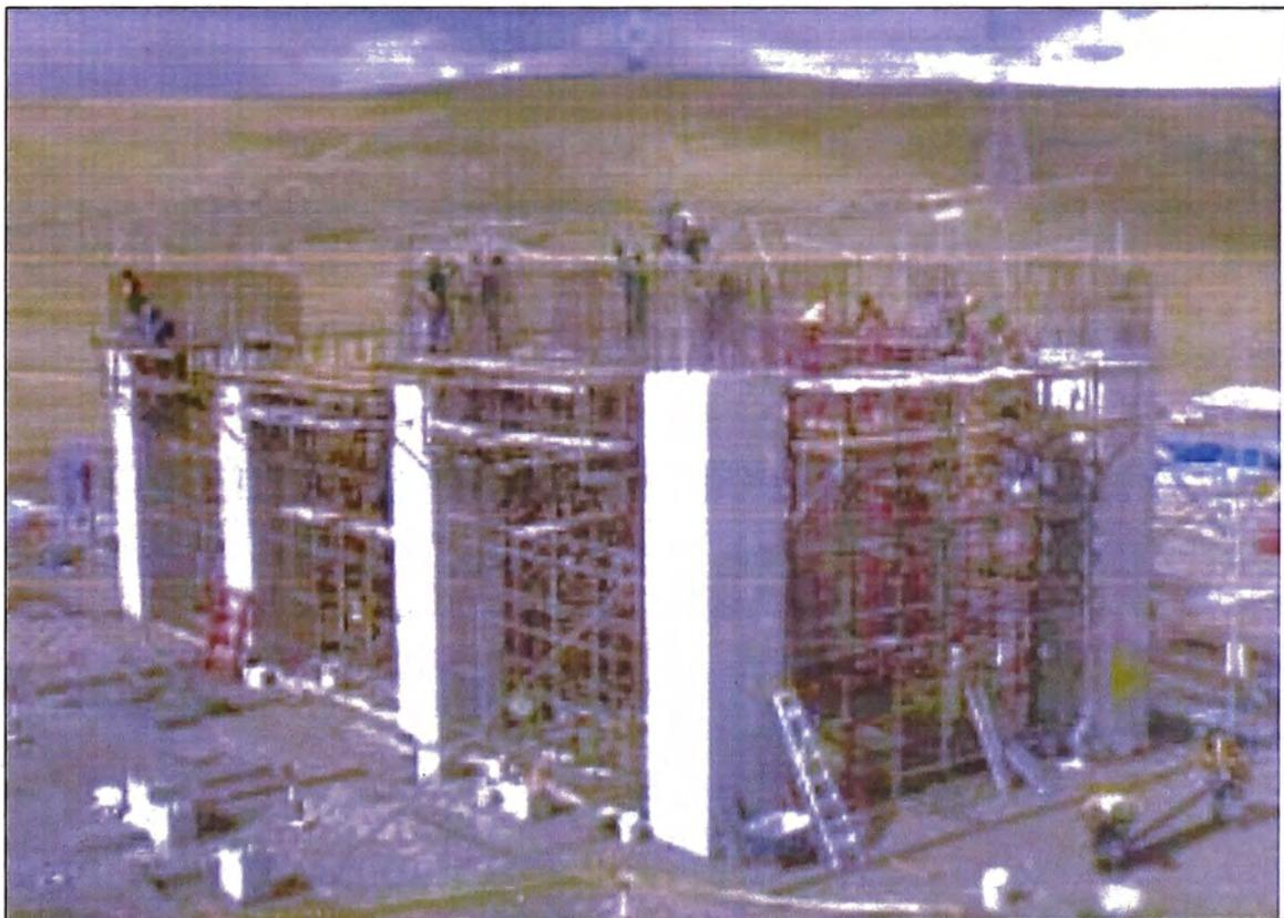
Foto N°44.-Armado de Acero de refuerzo en losa maciza de chancado terciario
