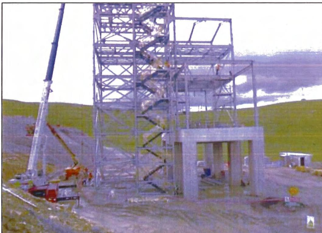
**Foto N°48.- Montaje columnas y vigas metálicas para la instalación de coberturas**
