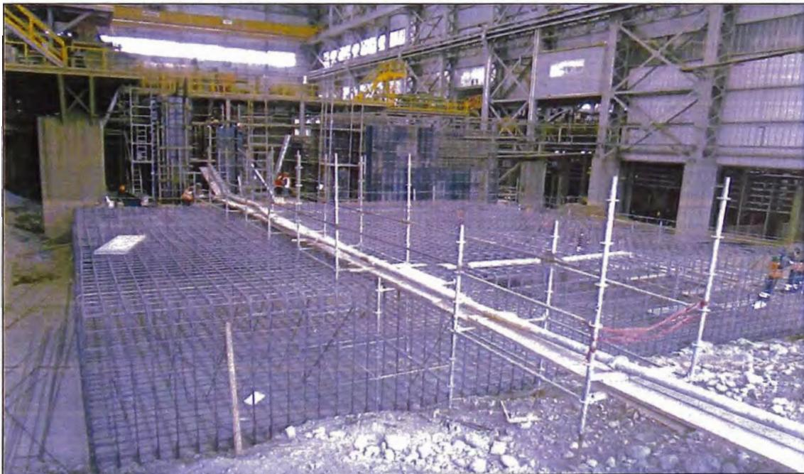
**Foto N°63.- Se observa el armado de aceros en zapatas de molino 20'x30'**
