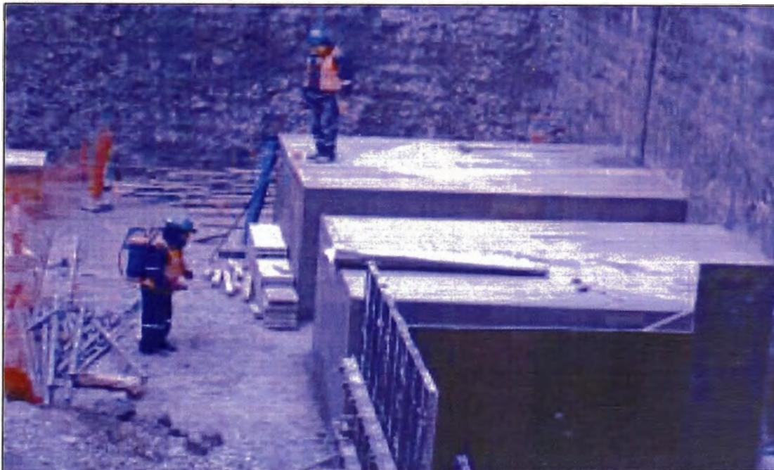
Foto N°69.- Vaciado de Falsa Zapatas en Zarandas Derrick
