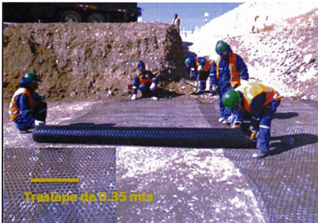
Foto N°34.- Instalación de Geomalla Triaxial con traslape de 0.35 m
